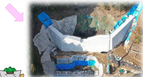
▲305溪流本堤完成(撮影日:令和元年12月20日)
