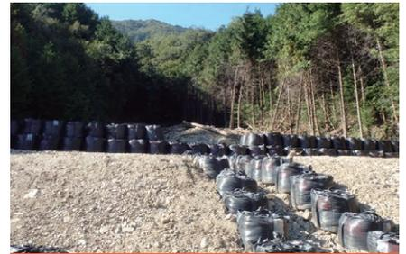
崩れた土砂の再移動防止や流路確保を目的とした大型土のうの設置
