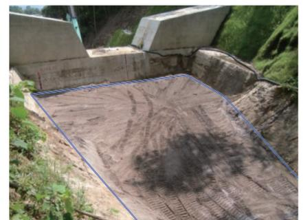
堰堤機能回復(土砂撤去完了)
