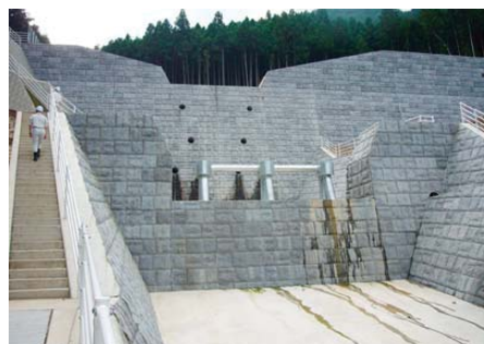
赤土地1号砂防堰堤(H19.10完成) (広島市佐伯区湯来町)
