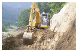
工事用道路掘削状況
