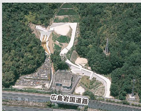
玖波砂防堰堤（大竹市玖波）
