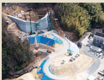
永輝砂防堰堤 (呉市天応東久保)
