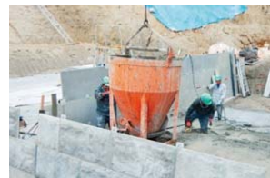
コンクリートの打設
