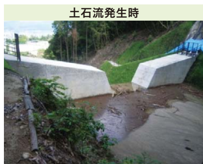
H26.8.20 土石流を捕捉（砂防堰堤の上流側）
