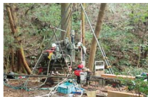
地質調査（ボーリング）
