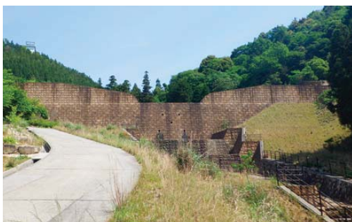
上ヶ原砂防堰堤(H20.10完成) (広島市安佐北区可部町中野)
