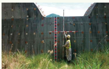
砂防堰堤の点検
