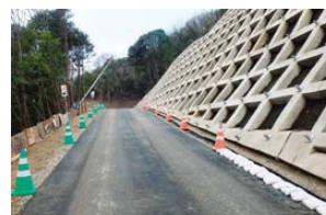
工事用道路の整備
