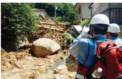
被災状況調査
