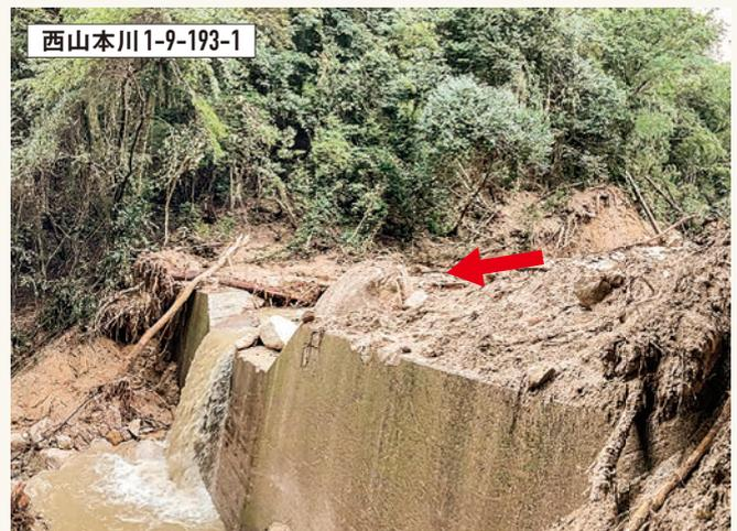
④ 上流堰堤付近の不安定土砂堆積状況 (R3.8.15撮影)
