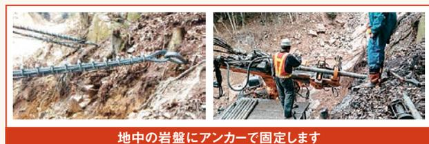
地中の岩盤にアンカーで固定します
