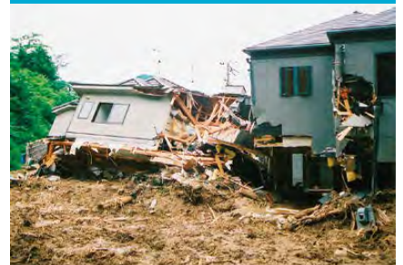
平成11年6月29日土砂災害
