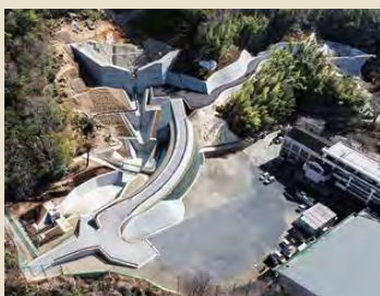
永輝砂防堰堤 (呉市天応東久保)
