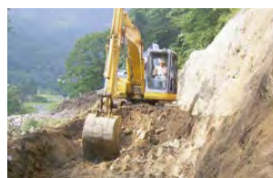
工事用道路掘削状況
