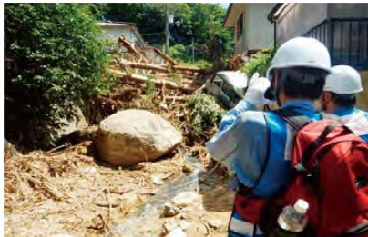
被災状況調査
