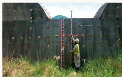
砂防堰堤の点検
