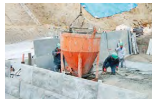
コンクリートの打設
