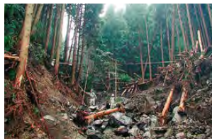
溪床状況の調査
