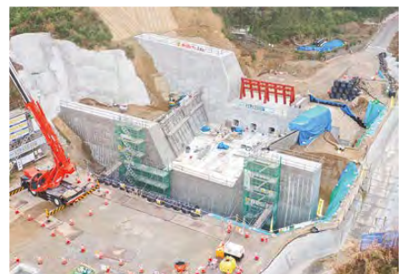
安芸郡坂町 坂 総頭川 (令和5(2023)年12月)
