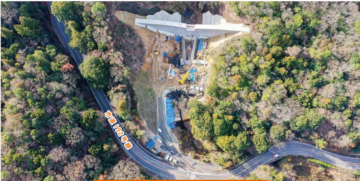
砂防堰堤工事 深山の滝川1号砂防堰堤 (広島市安芸区矢野町)
