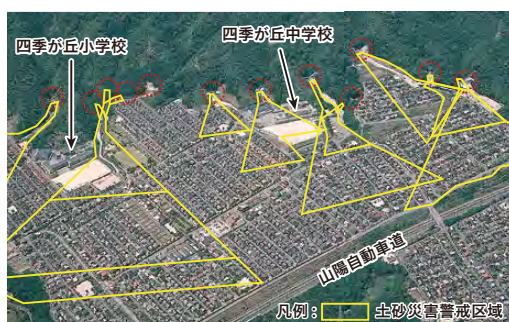
四季が丘地区砂防堰堤群（廿日市市四季が丘）
