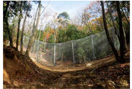
強靱ワイヤーネット設置 (広島市安芸区矢野東)
