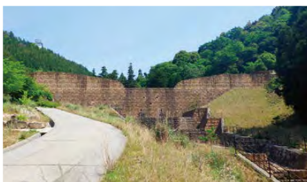
上ヶ原砂防堰堤（H20（2008）.10完成） （広島市安佐北区可部町中野）
