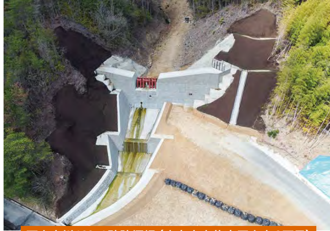
西山本川 193-4 砂防堰堤 (広島市安佐南区山本6丁目)
