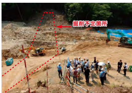
大元谷川（広島市安芸区上瀬野） 令和元（2019）年8月
