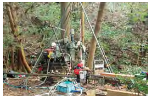
地質調査(ボーリング)
