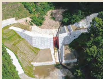
原3号砂防堰堤 (廿日市市原)
