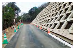
工事用道路の整備
