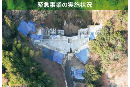
広島市西区田方 御幸川支川 令和5(2023)年12月
