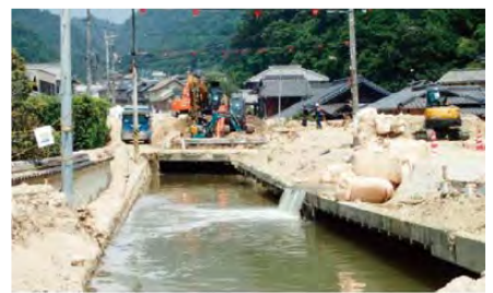
河川等に堆積した土砂の撤去 (呉市天応西条)
