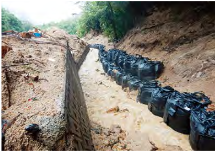
大型土のう設置・流路断面確保 (呉市天応町)
