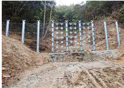
杭式土石流・流木対策工完成 (呉市天応町)
