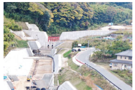
安芸郡坂町 総頭川 (令和7(2025)年11月)
