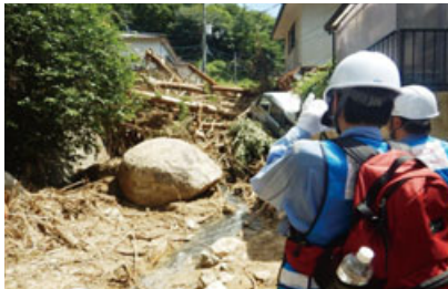
被災状況調査
