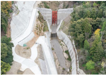
広島市安佐北区口田南 一ヶ谷川 (令和7(2025)年11月)
