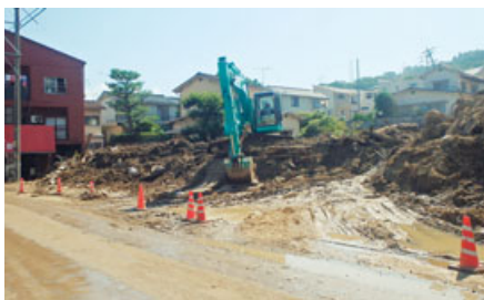
道路啓開作業 (広島市安佐北区口田南)
