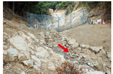
強靱ワイヤーネット設置状況 (広島市安佐南区八木)
