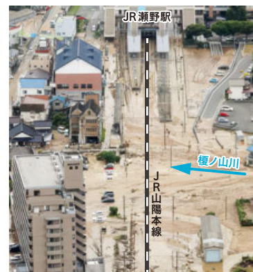
平成30年7月豪雨災害での被災状況(榎ノ山川)
