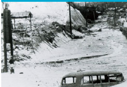
大野陸軍病院の患者用車が流され、国鉄山陽線軌道が土砂で埋没(旧大野町)
