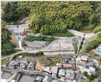
白石1号・2号砂防堰堤 (大竹市)
