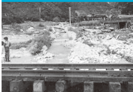
土石流により国道2号や山陽本線など交通施設が被災(廿日市市大野)
