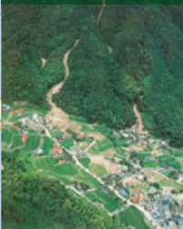
広島市安佐北区亀山 (大毛寺川左支川)
