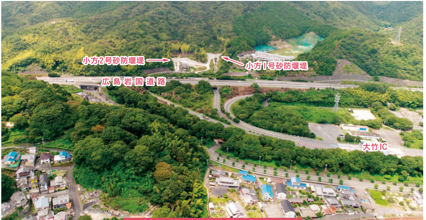
重要な交通網を守る大竹市小方地区の砂防堰堤
