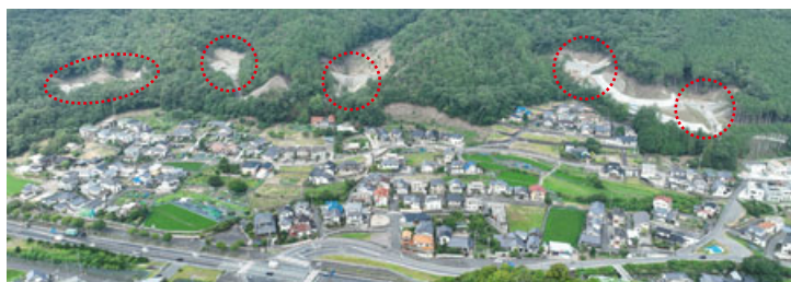
城北地区砂防堰堤群（広島市安佐北区可部）
