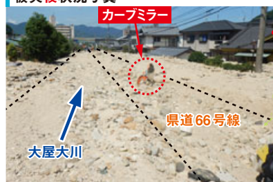
平成30年7月豪雨での大屋大川 (呉市天応西条地区)
