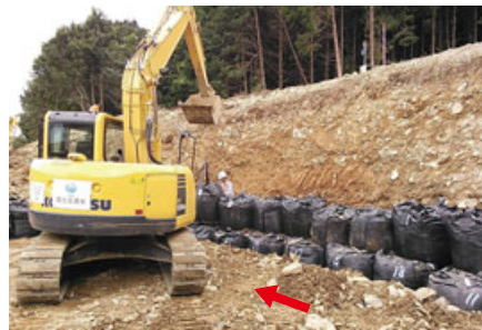
崩れた土砂の再移動防止や流路確保を目的とした大型土のうの設置
