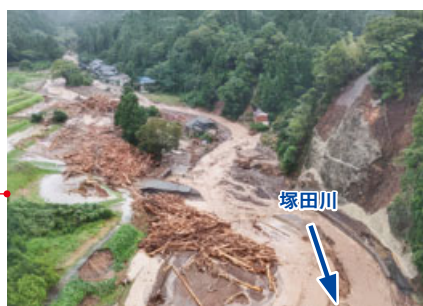
令和6年9月20日からの豪雨(石川県輪島市)
