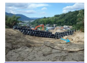
導流工実施状況
