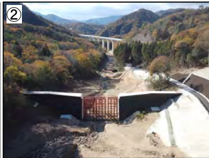
堰堤整備状況（上流側） (2-2-74溪流)
