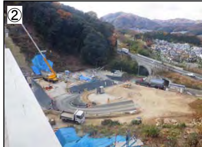
② 前庭保護工・管理用道路施工状況 （2-2-97溪流）
