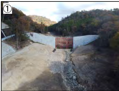
堰堤整備状況（下流側） (2-2-74溪流)
