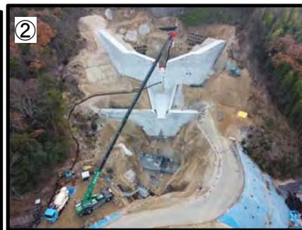
前庭保護工施工状況 (3-91-92隣e渓流)
