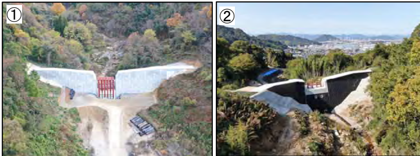
堰堤整備状況 (2-24-7溪流)
