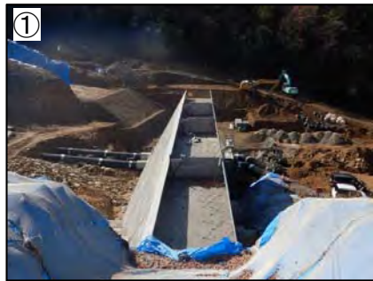
① コンクリート打設（嵩上げ）状況 (1-9-226溪流)
