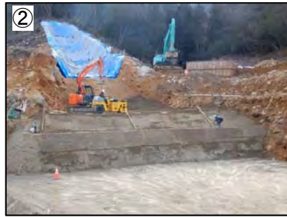
② コンクリート打設（嵩上げ）状況 (1-9-226溪流)
