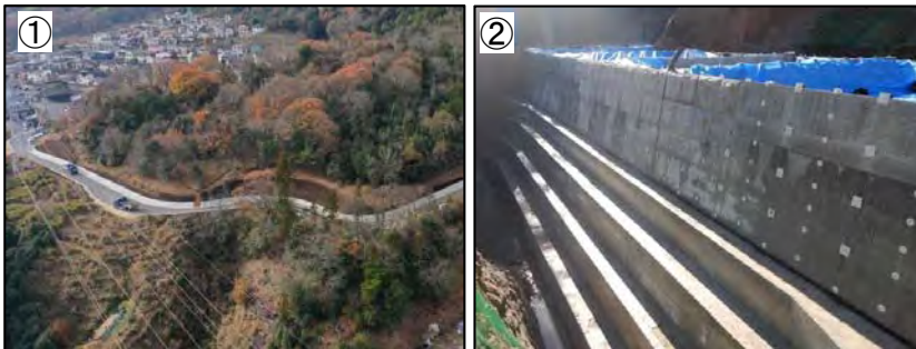
① 進入路施工状況（全景） （1-9-486溪流）
