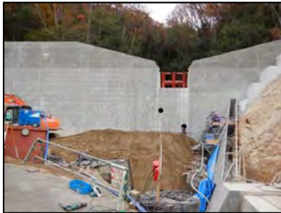
前庭保護工施工状況 (2-23-20溪流)
