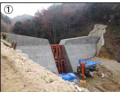
堰堤整備状況 (1-9-279-1溪流)
