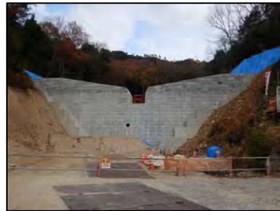
堰堤整備状況 (2-23-13溪流)
