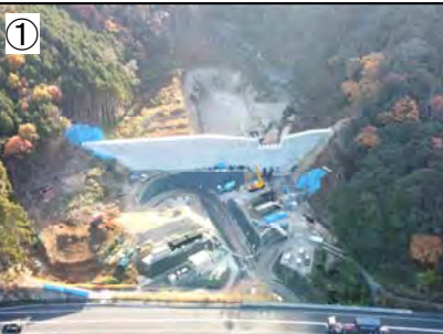
① 前庭保護工・管理用道路施工状況（全景） （2-2-97溪流）
