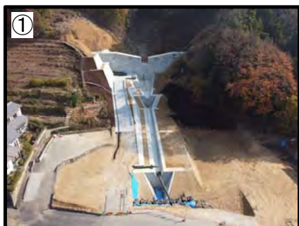
堰堤整備状況（背戸の川） (3-91-90f渓流)
