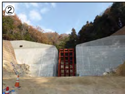
堰堤整備状況 (1-9-279-2隣溪流)
