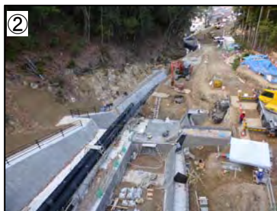
② 流路施工状況 （1-9-33溪流）
