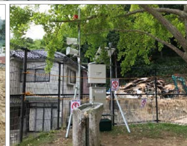
土石流警報装置設置状況
