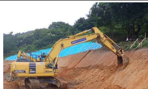
ICTバックホウを用いた掘削状況
