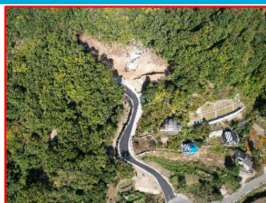
背戸の川支川90b (①本堤工事中)
