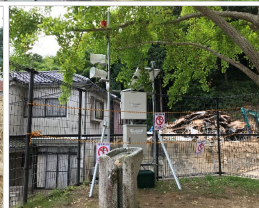
土石流警報装置設置状況
