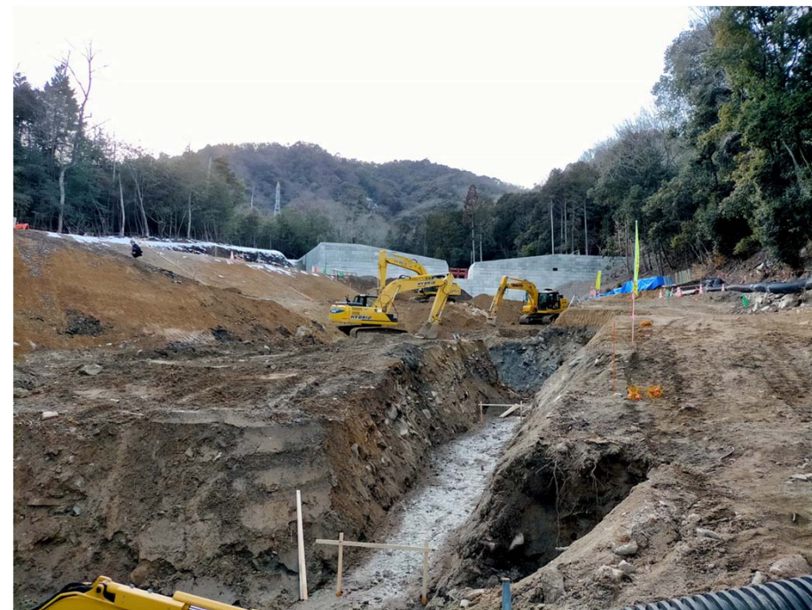
【施工状況 (流路工)】
