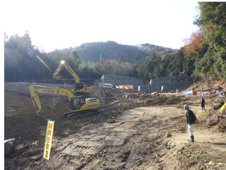
【施工状況 (流路工)】
