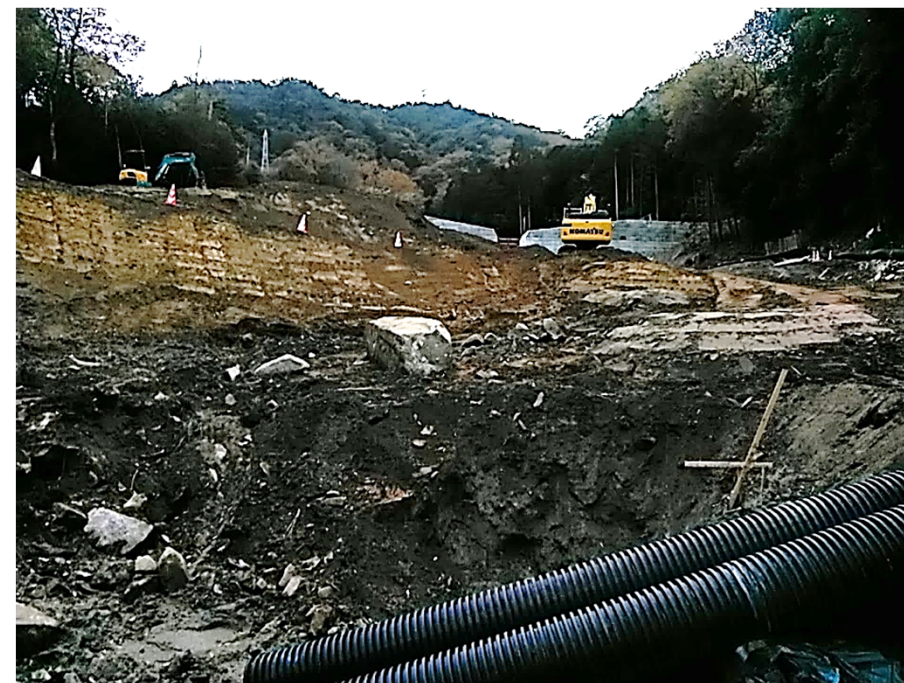
【施工状況 (流路工)】
