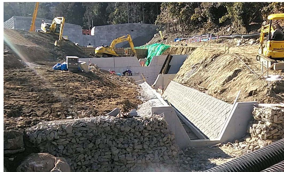
【施工状況 (流路工)】
