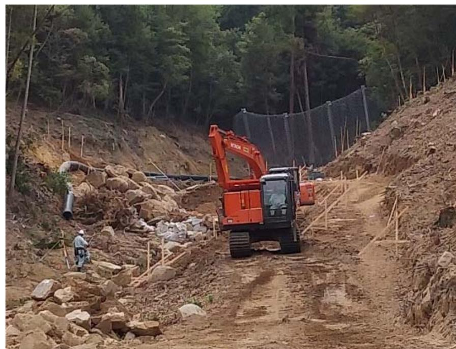
不整地運搬車による掘削残土の搬出
