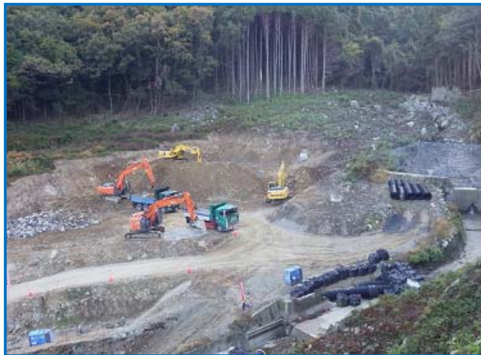
堆砂域の土砂掘削状況
