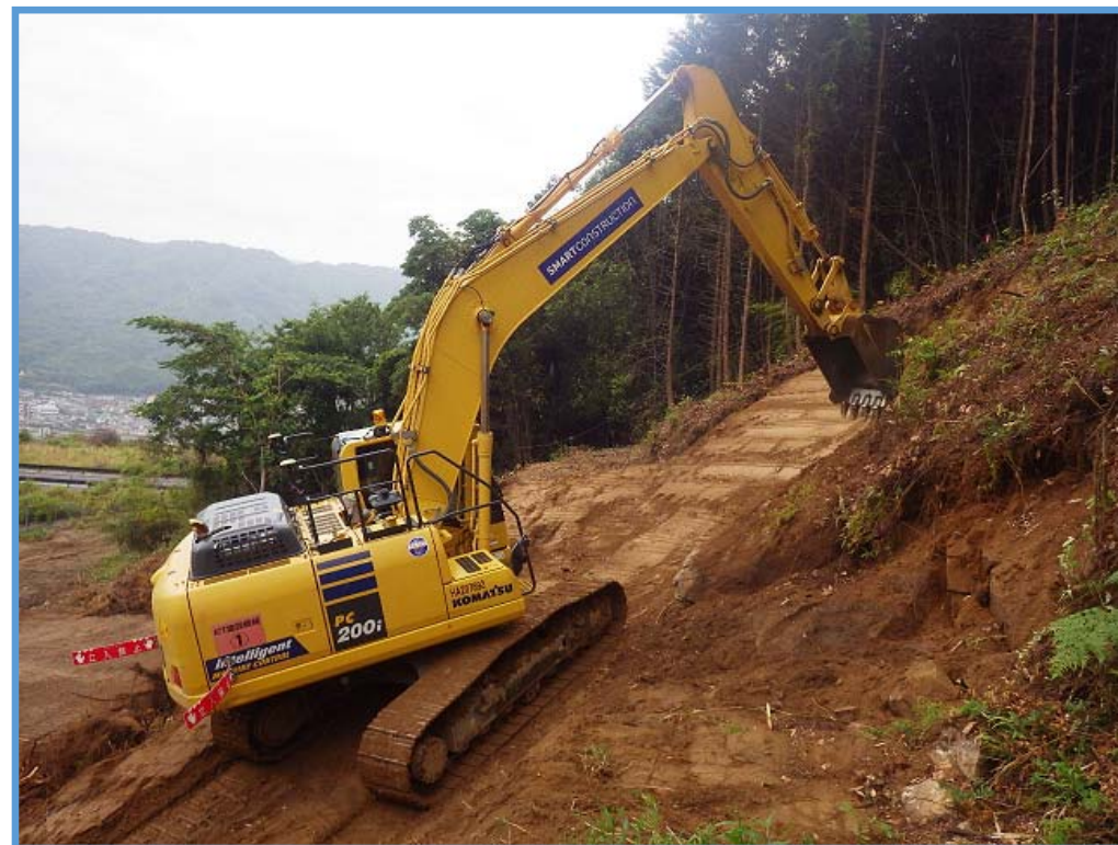
砂防堰堤の本体掘削状況 ②
