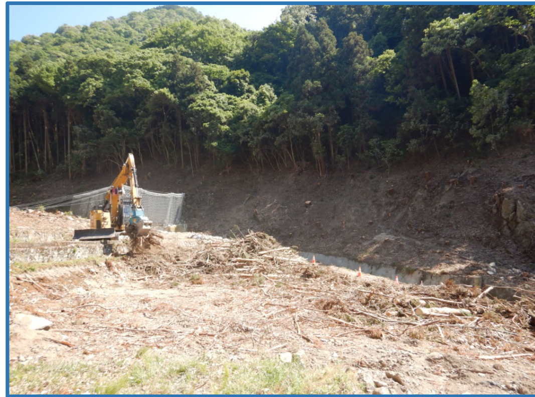
伐木・伐採 実施状況 (砂防堰堤付近)
