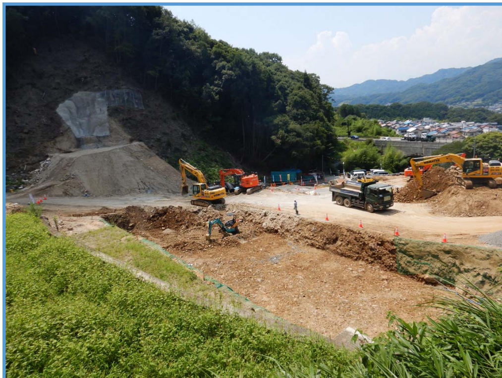
砂防堰堤の本体掘削状況 ①
