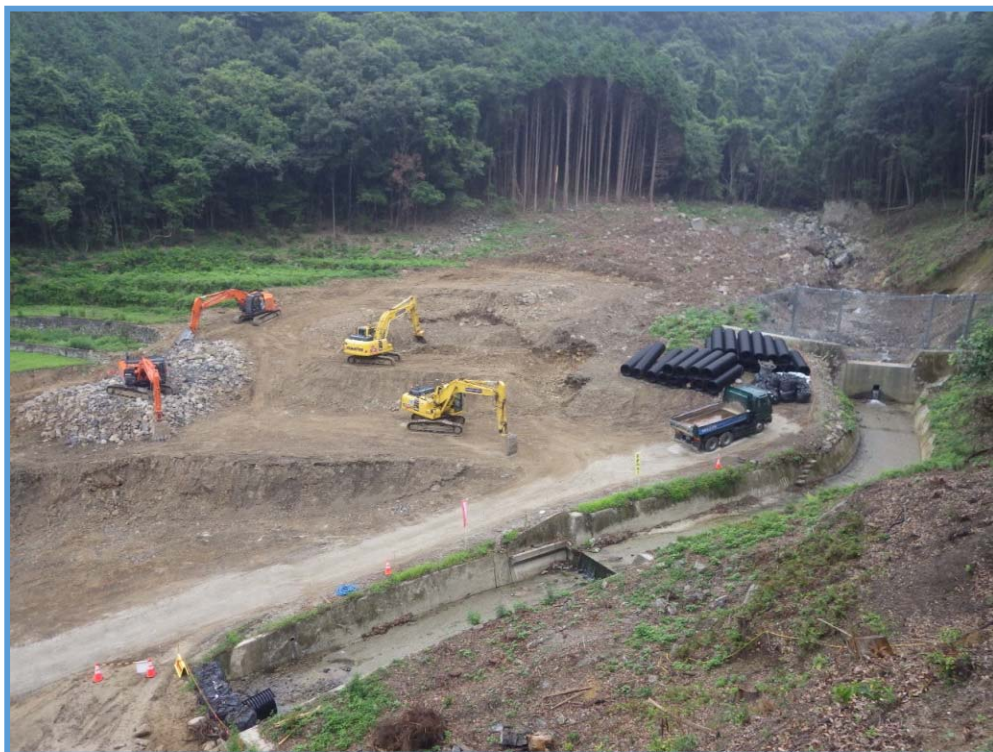
砂防堰堤の本体掘削状況 ①
