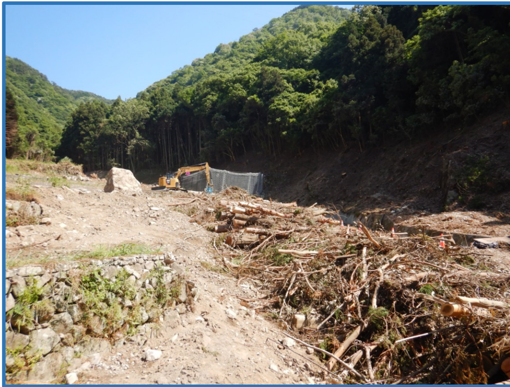
伐木・伐採 実施状況 (全体)
