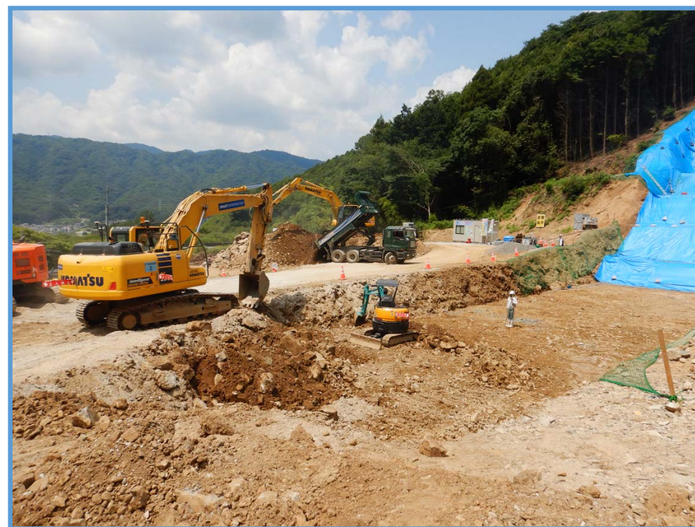
砂防堰堤の本体掘削状況 ②
