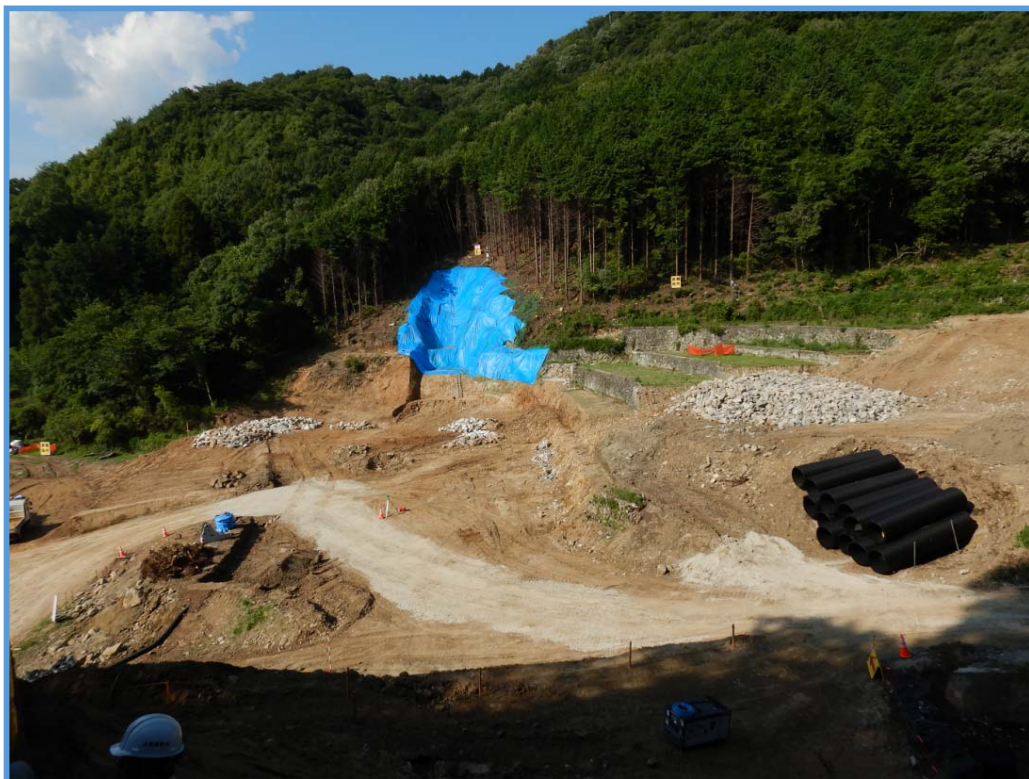
砂防堰堤の本体掘削状況 ①
