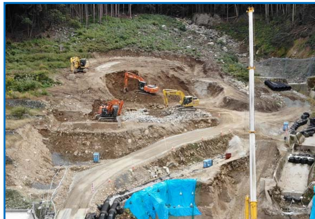
堆砂域の土砂掘削状況
