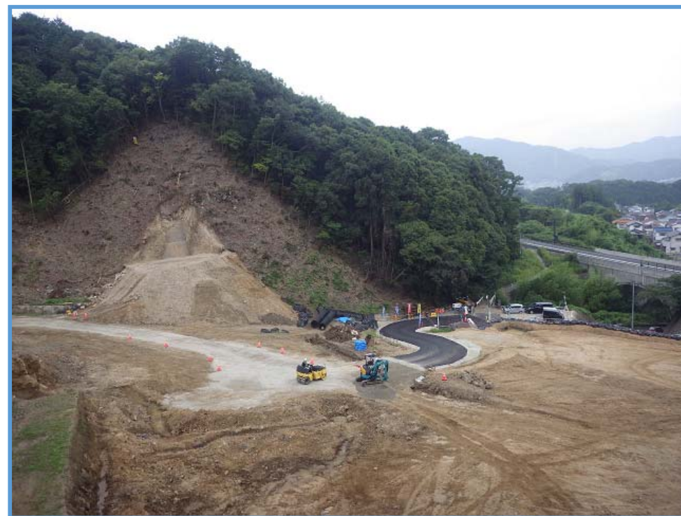
砂防堰堤の本体掘削状況 ②
