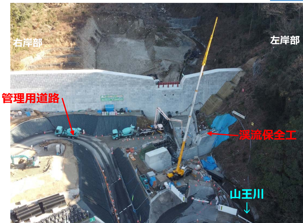
砂防堰堤本体下流部の施工状況
