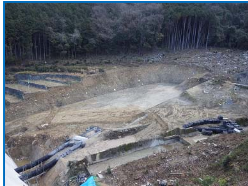
堆砂域の土砂掘削完了
