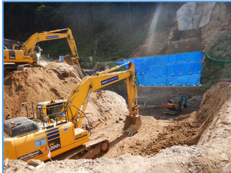
砂防堰堤本体の掘削状況（左岸）
