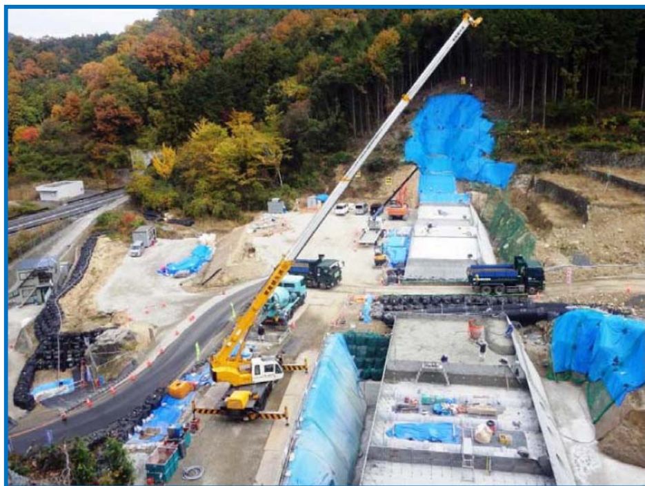
砂防堰堤本体のコンクリート打設状況
