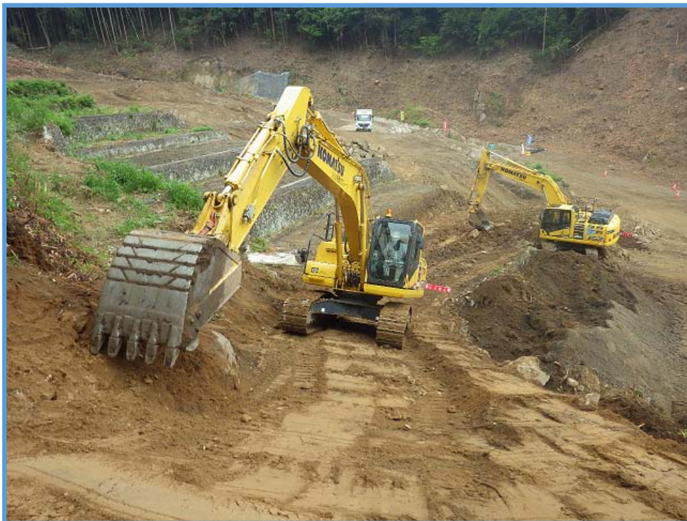
砂防堰堤の本体掘削状況 ①
