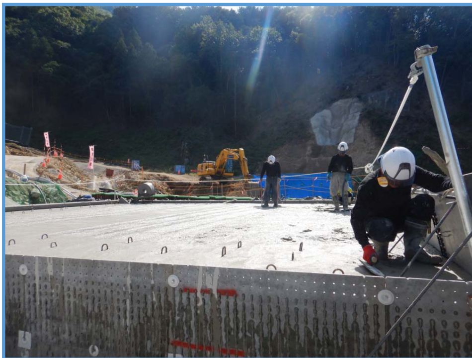
砂防堰堤本体のコンクリート打設状況（右岸）
