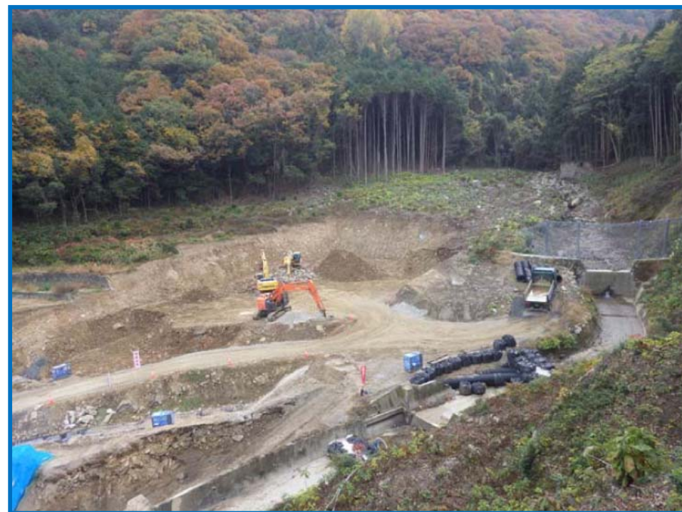
堆砂域の土砂掘削状況
