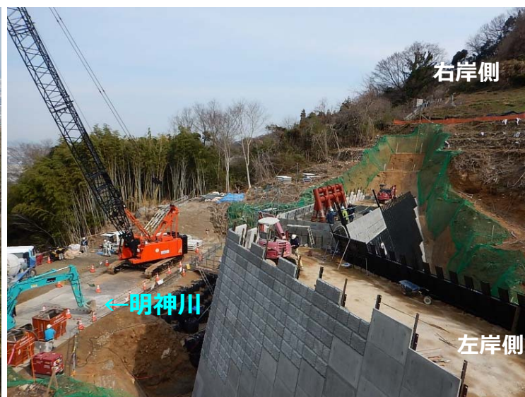
堰堤施工状況(左岸側より)
