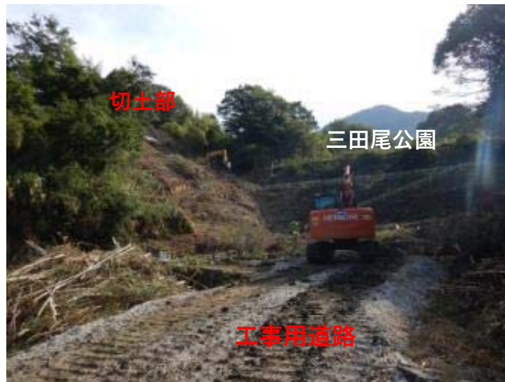
工事用道路（三田尾公園手前）
