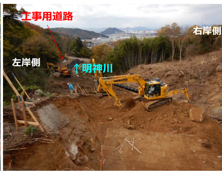
堰堤左岸掘削状況
