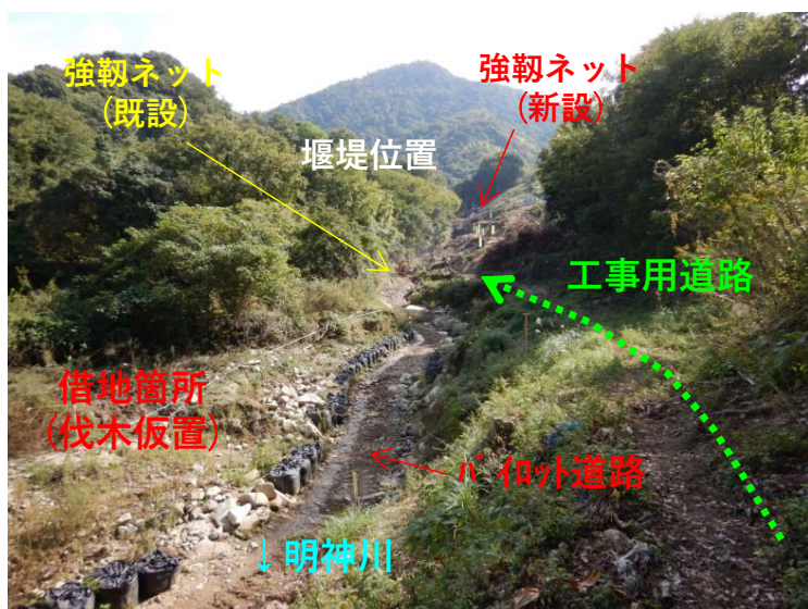
パイロット道路 (堰堤下流部)
