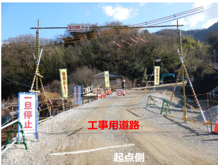
工事用道路起点部
