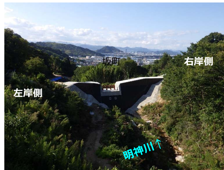
堰堤施工状況(上流より)
