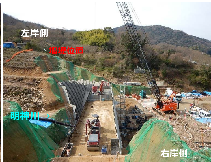
堰堤施工状況(右岸側より)
