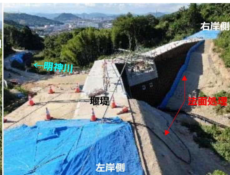
堰堤施工状況(左岸側より)
