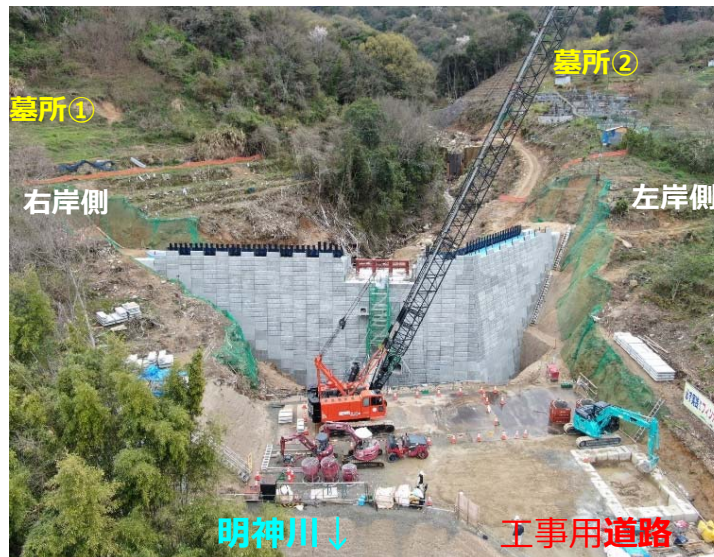
堰堤施工状況(下流斜め)
