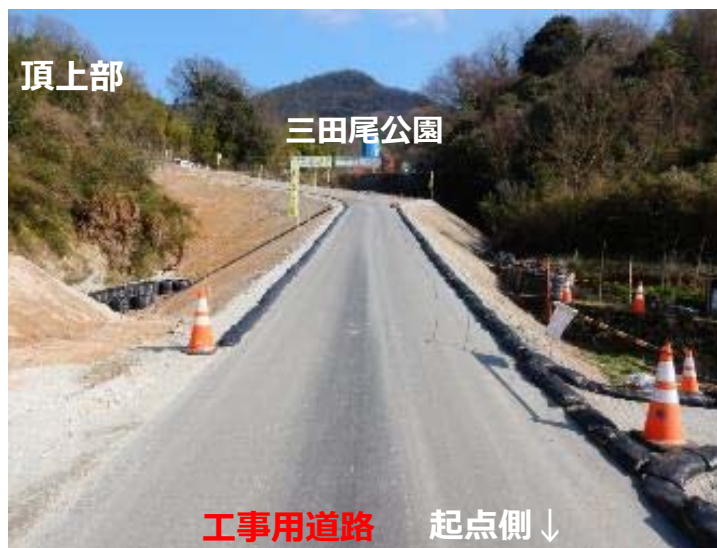
工事用道路（三田尾公園手前）
