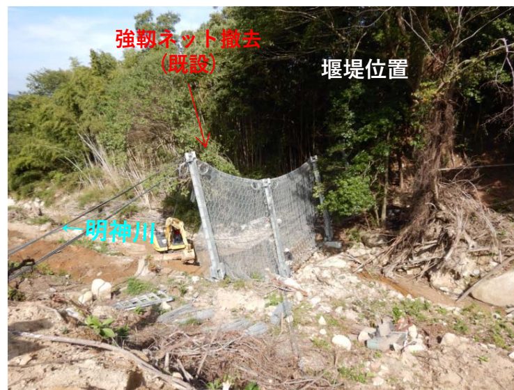
既設強靱ワイヤネット撤去状況
