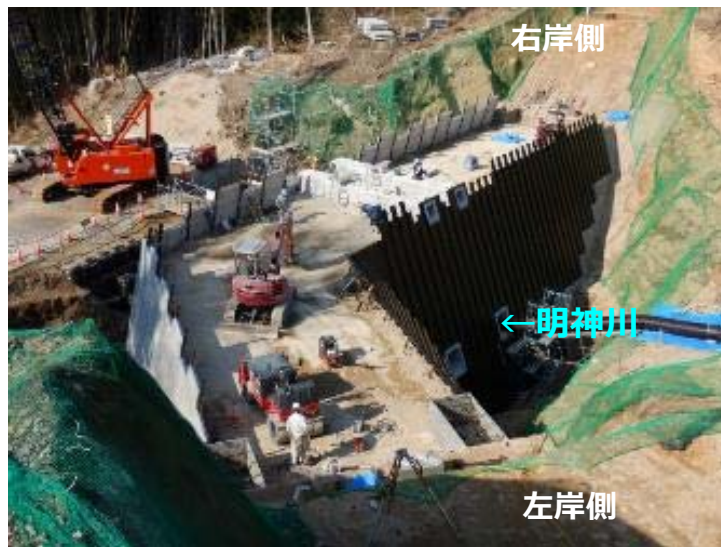
堰堤打設状況(左岸側より)
