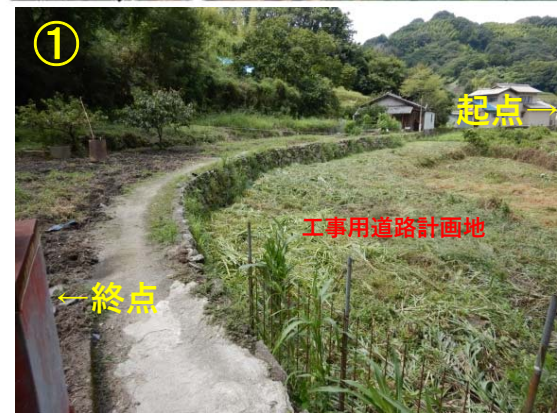
明神川工事用道路 伐採状況
