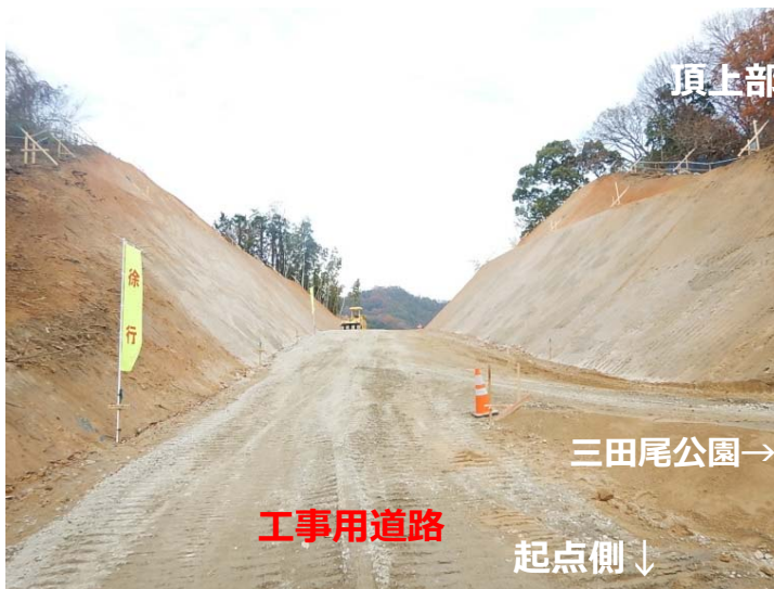
工事用道路 (三田尾公園手前)
