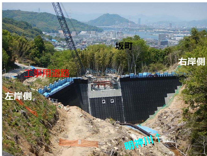
堰堤施工状況(上流より)
