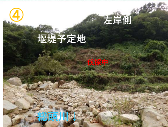
総頭川砂防堰堤付近 伐採状況
