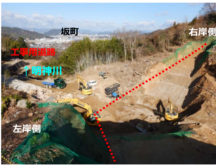
堰堤左岸掘削状況
