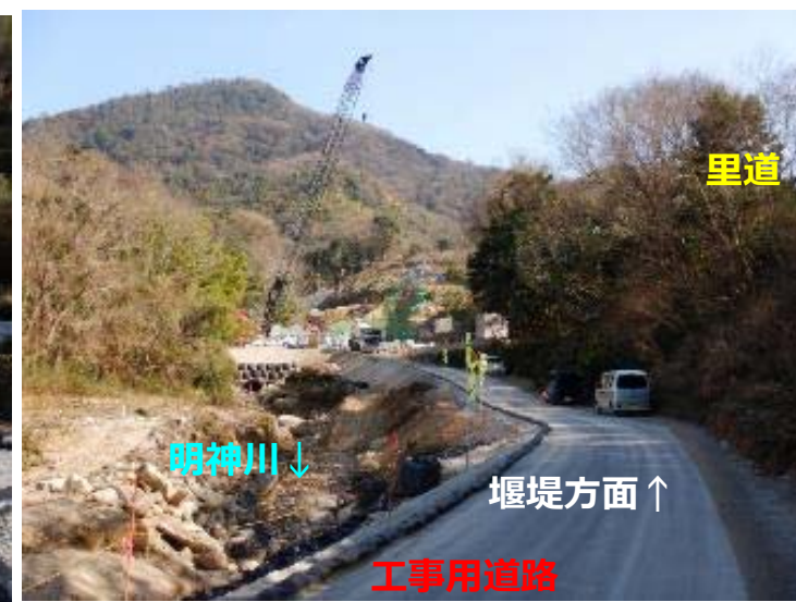
工事用道路（堰堤下流）
