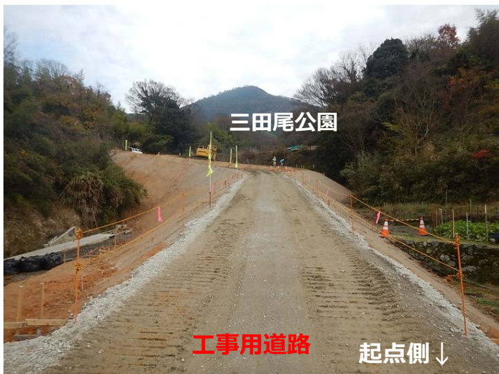
工事用道路起点部
