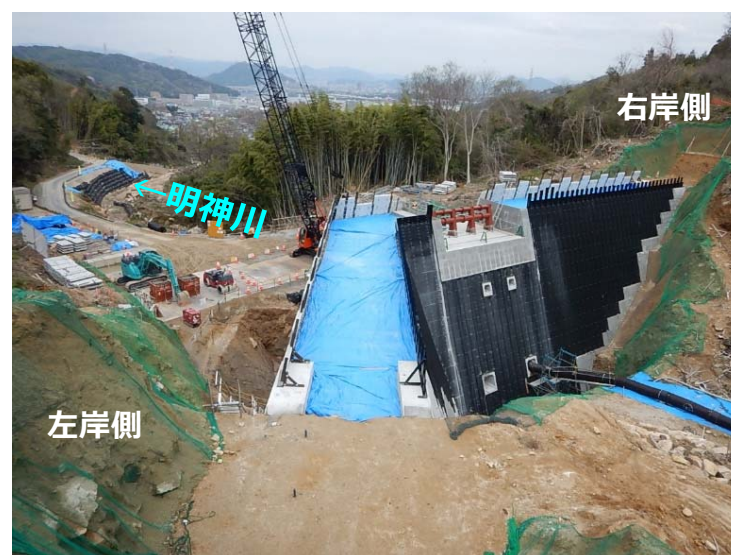
堰堤施工状況(左岸側より)
