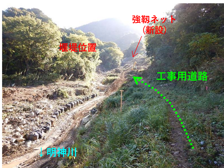
パイロット道路（堰堤下流部）
