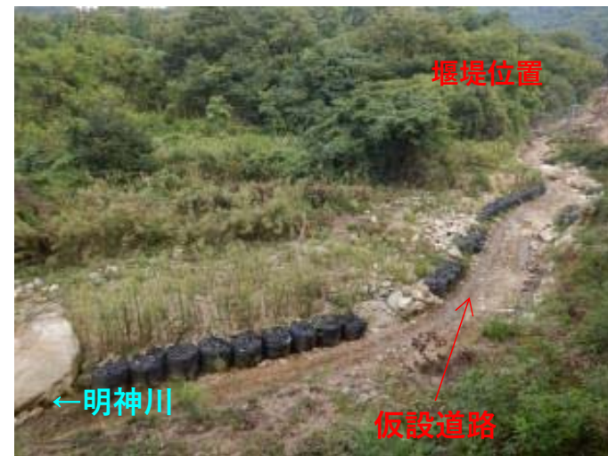
工事用道路（堰堤下流部）
