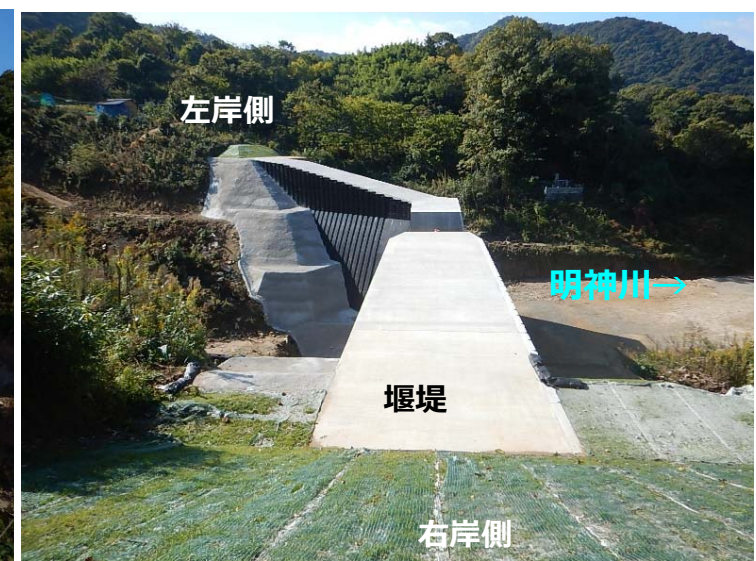
堰堤施工状況(右岸側より)
