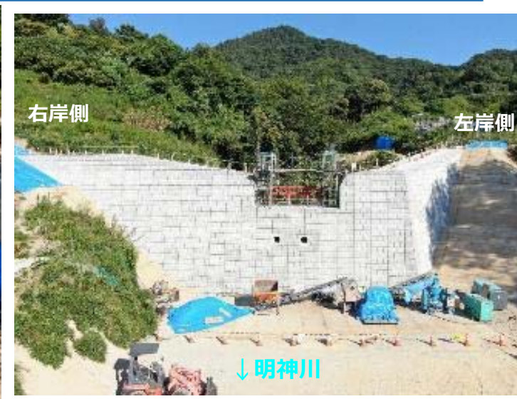
堰堤施工状況(堰堤直下)
