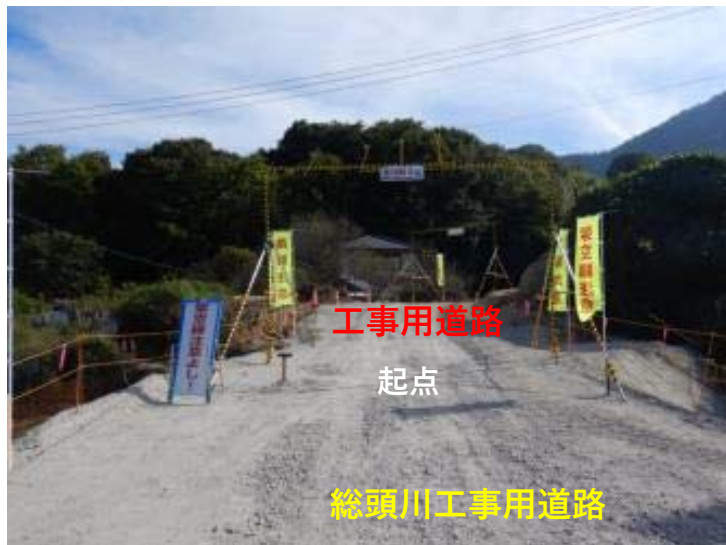
工事用道路起点部
