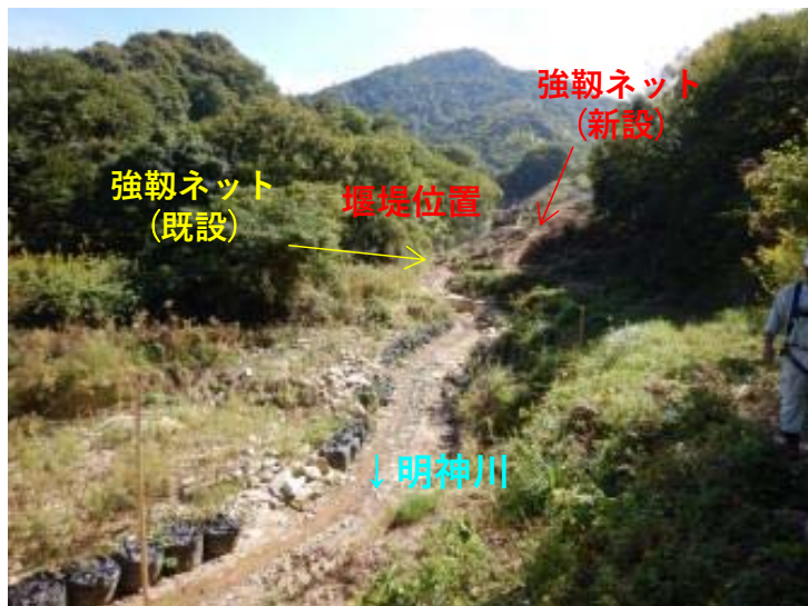
パイロット道路（堰堤下流部）
