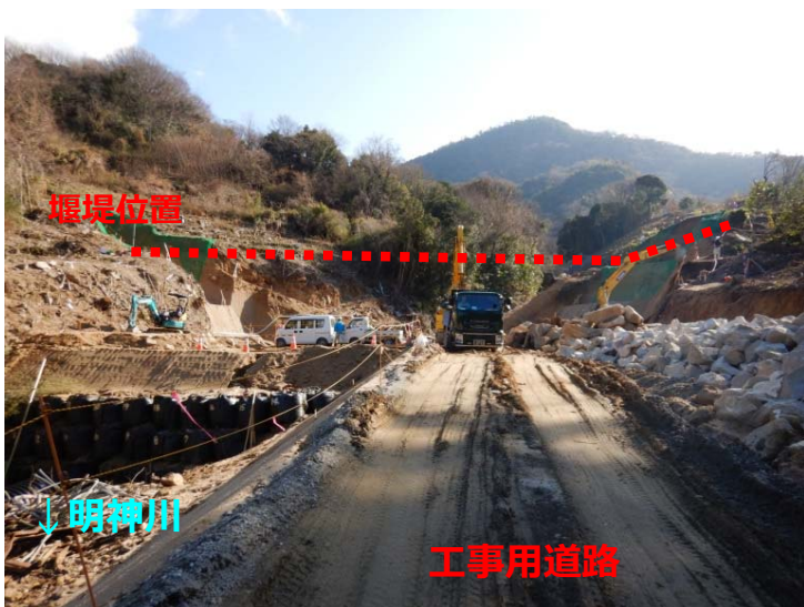
堰堤掘削状況(下流より)
