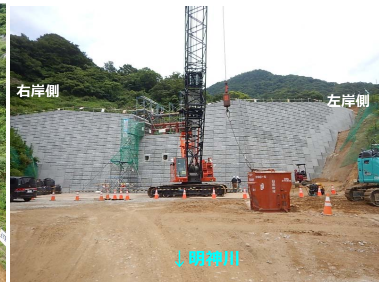
堰堤施工状況(堰堤直下)
