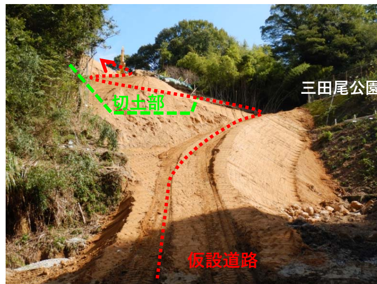
工事用道路 (三田尾公園手前)
