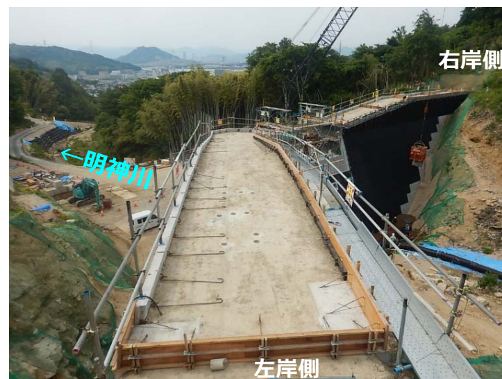
堰堤施工状況(左岸側より)
