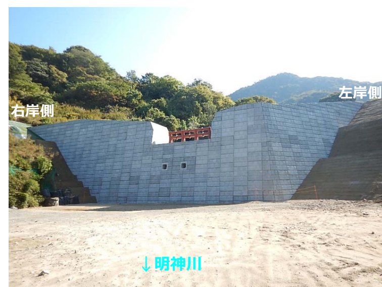
堰堤施工状況(堰堤直下)
