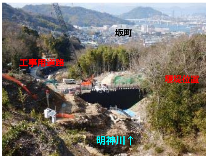
堰堤打設状況(上流より)
