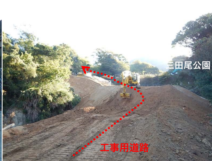
工事用道路（三田尾公園手前）
