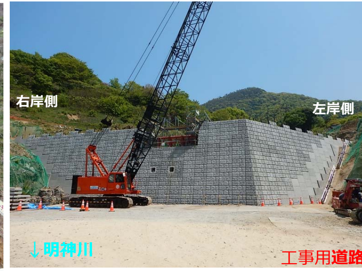
堰堤施工状況(堰堤直下)
