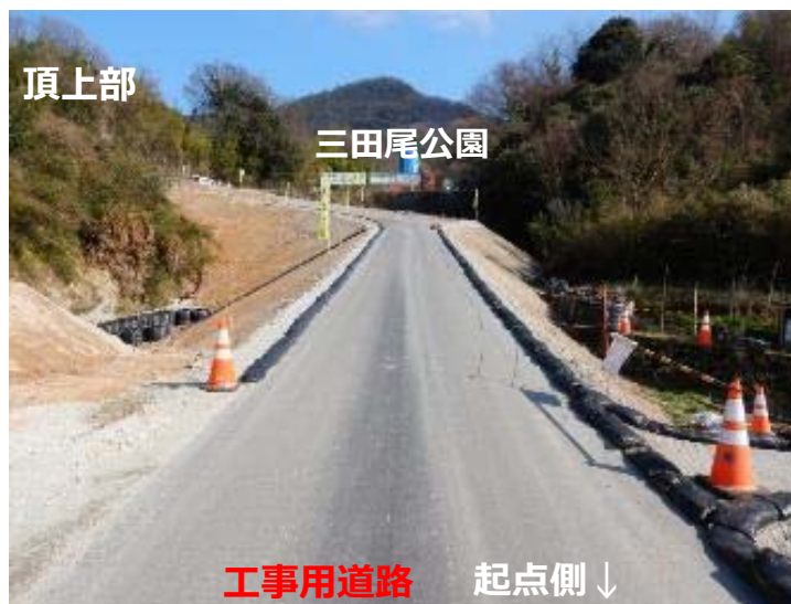
工事用道路 (三田尾公園手前)
