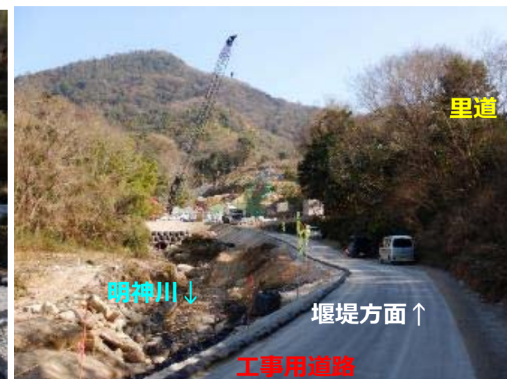
工事用道路 (堰堤下流)
