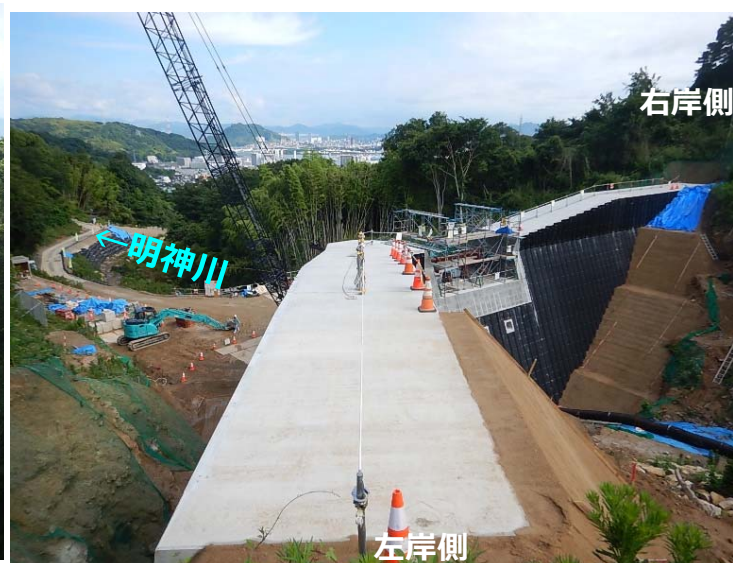
堰堤施工状況(左岸側より)
