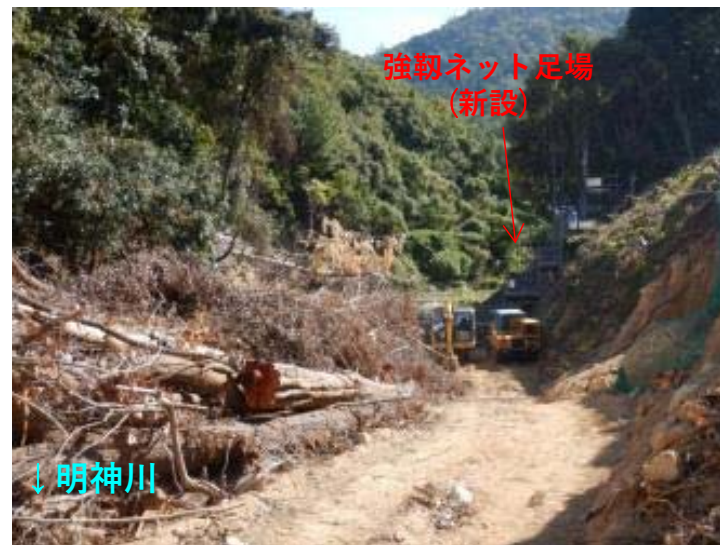
新設強靱ワイヤネット仮設足場設置状況
