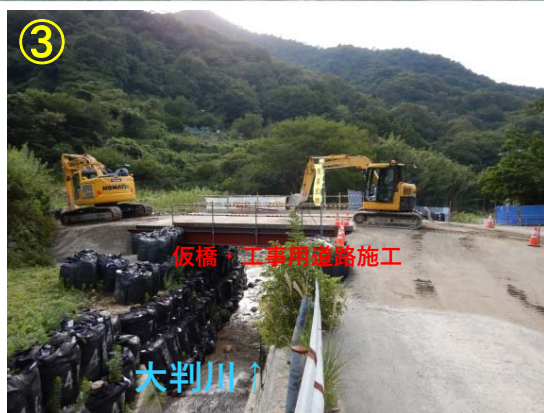
大判川渡河仮橋 設置状況
