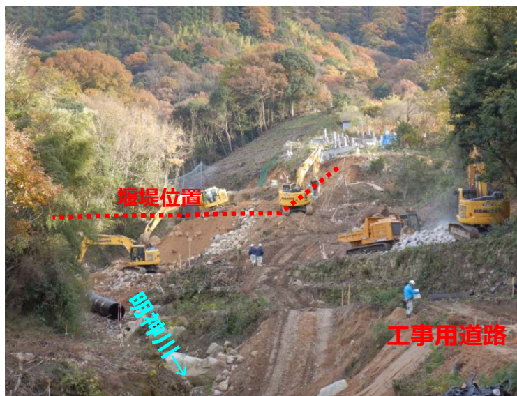
堰堤掘削状況(下流より)
