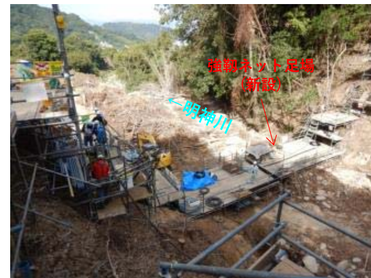
新設強靱ワイヤネット施工状況
