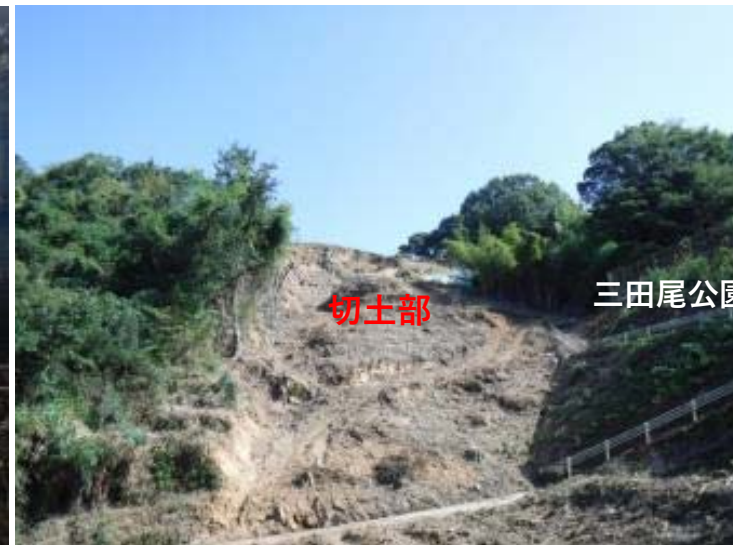
工事用道路切土部（三田尾公園手前）
