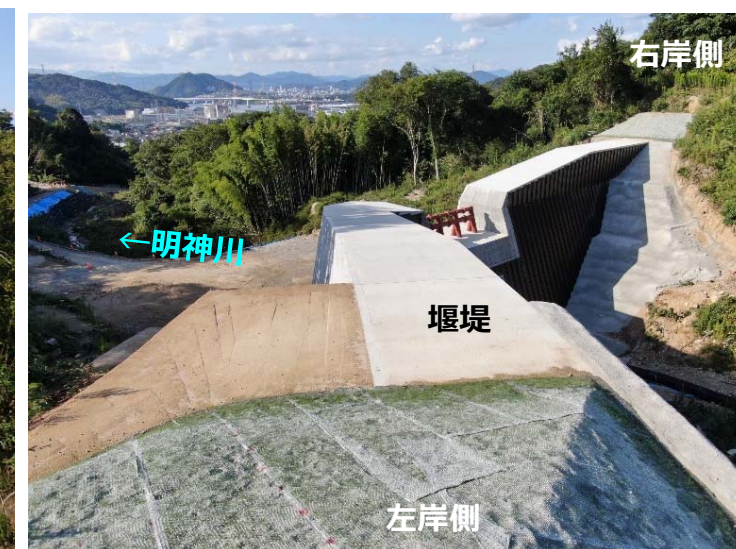
堰堤施工状況(左岸側より)
