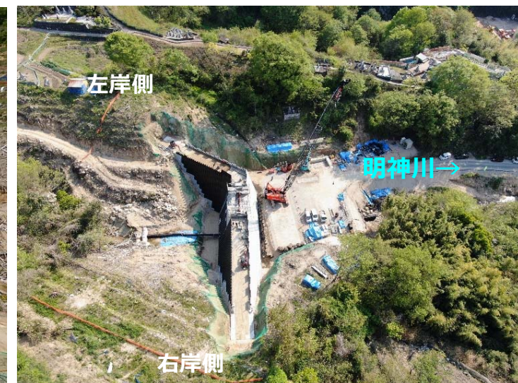
堰堤施工状況(右岸側より)
