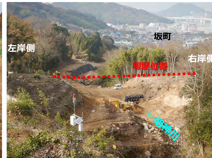
堰堤掘削状況(上流より)
