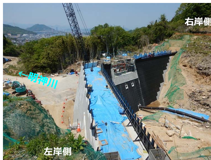
堰堤施工状況(左岸側より)
