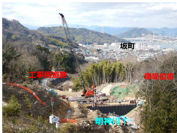
堰堤打設状況(上流より)
