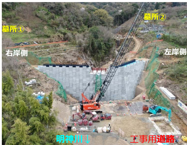
堰堤施工状況(下流斜め)
