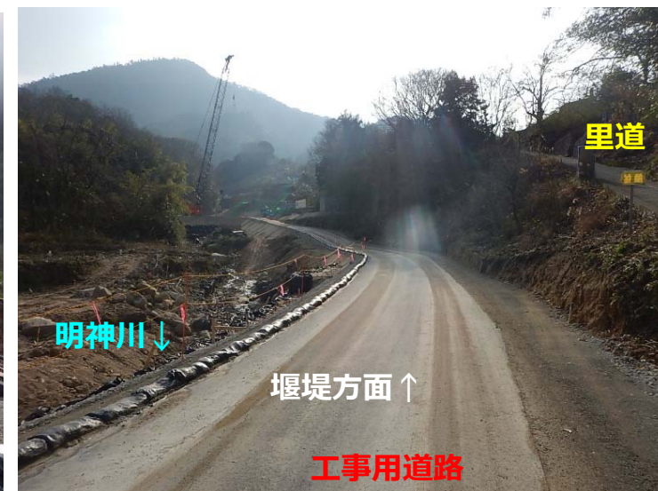
工事用道路 (堰堤下流)
