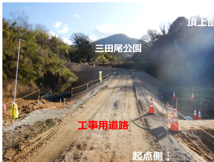
工事用道路（三田尾公園手前）
