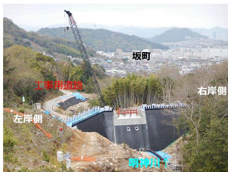
堰堤施工状況(上流より)
