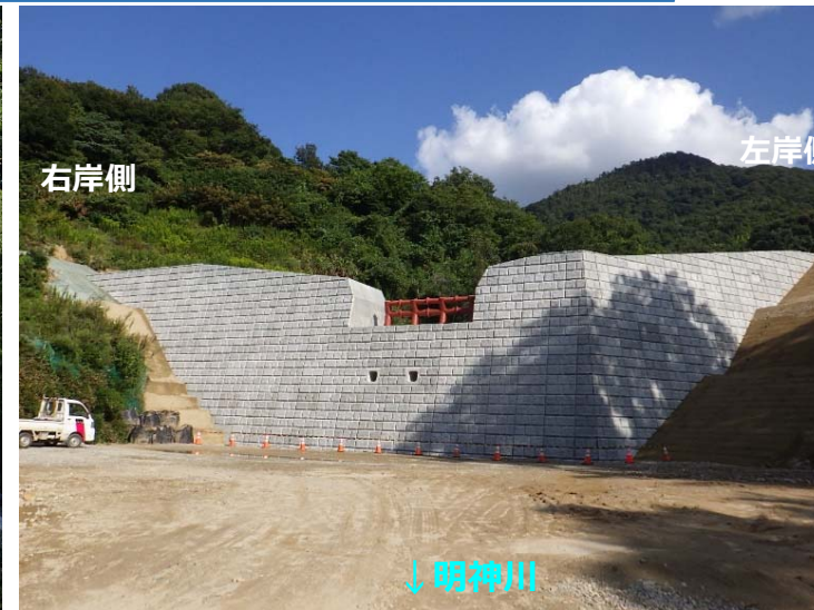
堰堤施工状況(堰堤直下)
