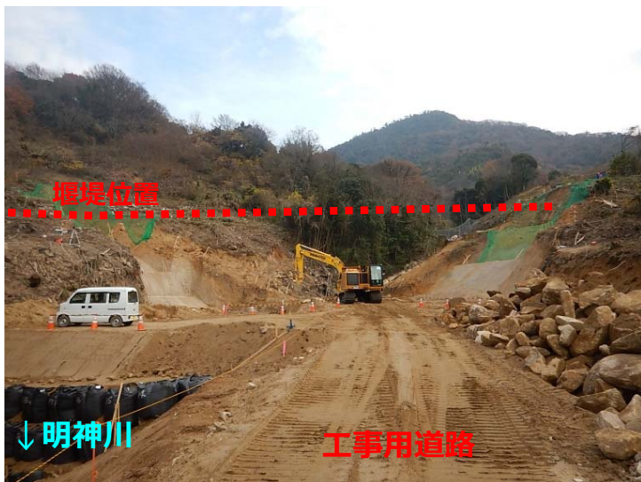
堰堤掘削状況(下流より)
