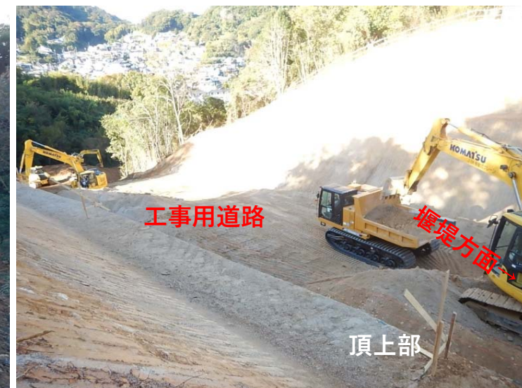
工事用道路（切土状況）
