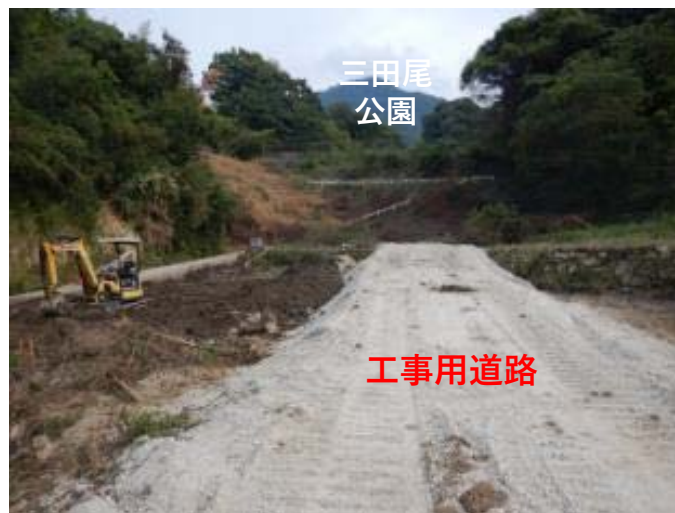
工事用道路（三田尾公園手前）
