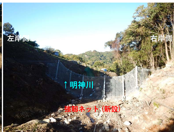
新設強靱ワイヤネット設置状況
