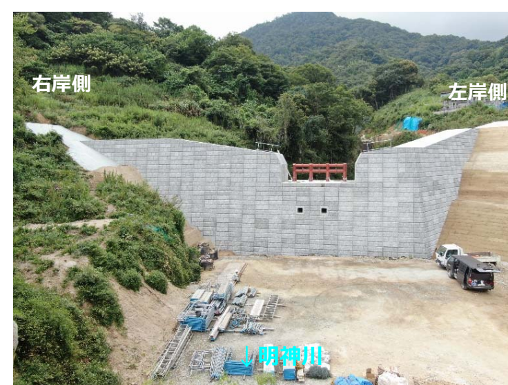
堰堤施工状況(堰堤直下)
