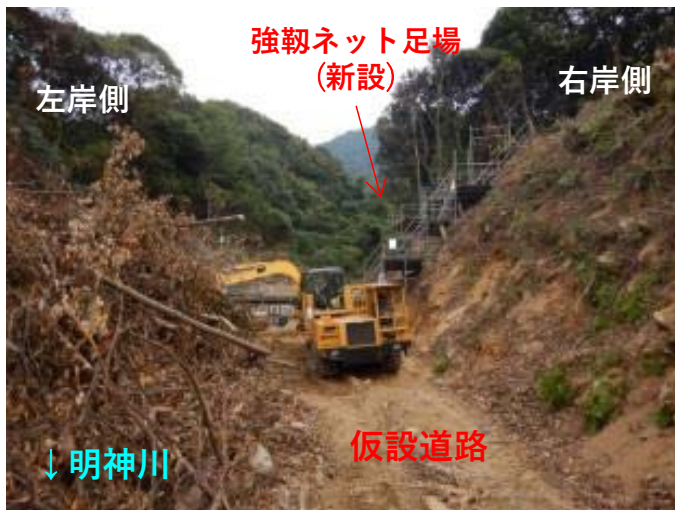
強靱ワイヤネット施工状況
