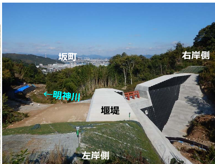
堰堤施工状況(左岸側より)
