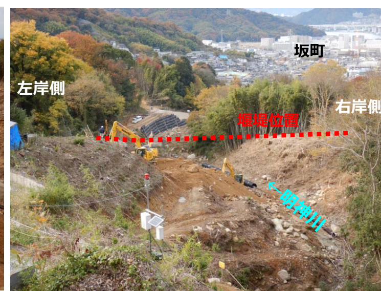
堰堤掘削状況(上流より)
