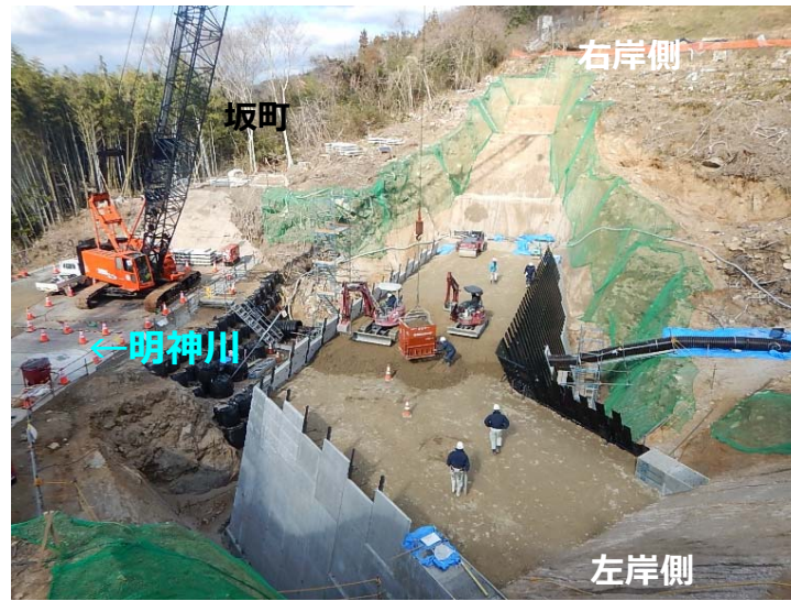
堰堤打設状況(左岸側より)
