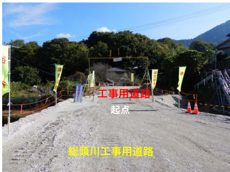
工事用道路起点部
