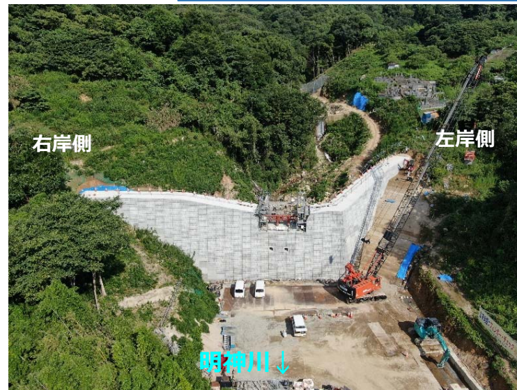
堰堤施工状況(下流斜め)
