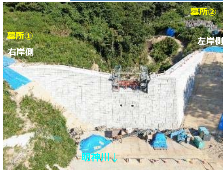
堰堤施工状況(下流斜め)
