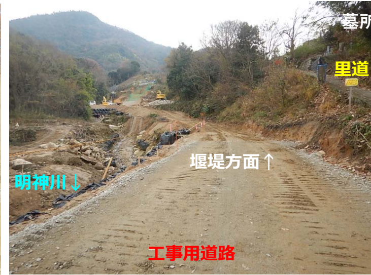
工事用道路 (堰堤下流)
