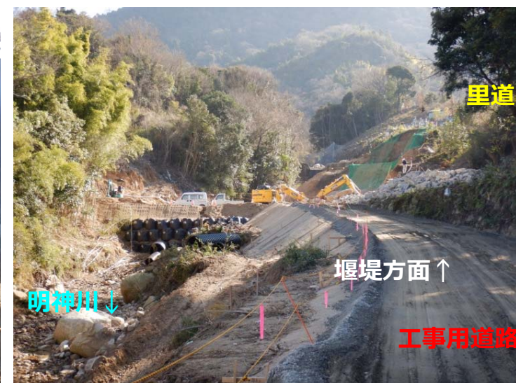
工事用道路（堰堤下流）
