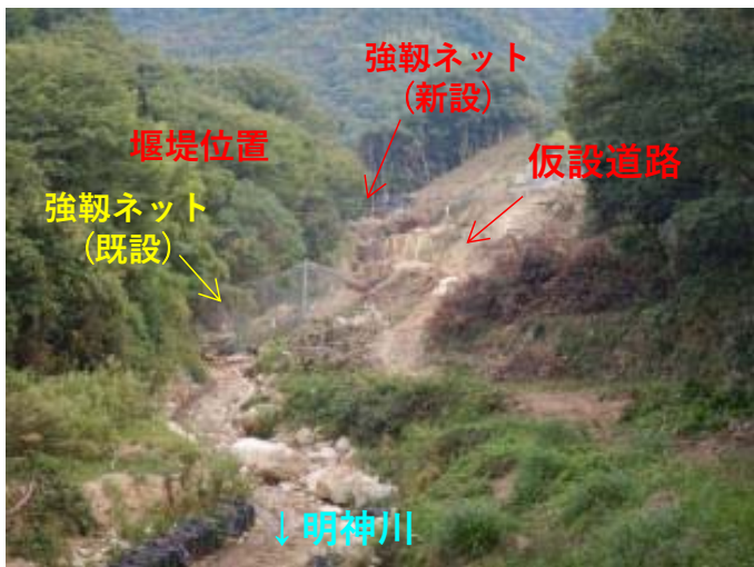
仮設道路（堰堤下流部）
