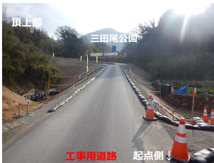
工事用道路 (三田尾公園手前)
