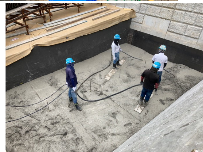
水叩工施工状況
