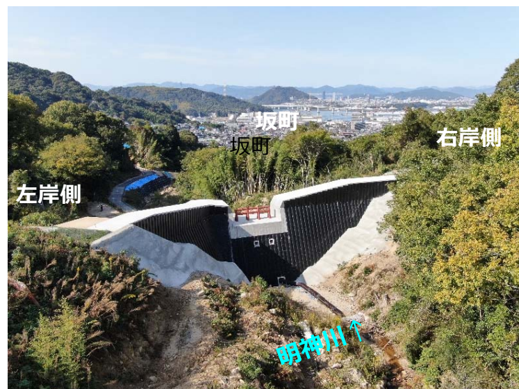
堰堤施工状況(上流より)
