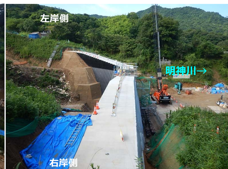
堰堤施工状況(右岸側より)
