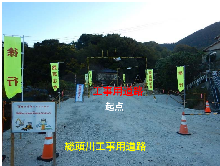
工事用道路起点部
