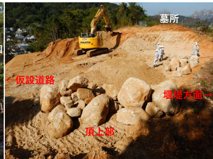
工事用道路 (切土状況)
