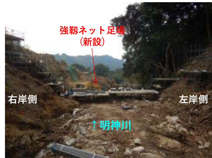
強靱ワイヤネット仮設足場設置状況
