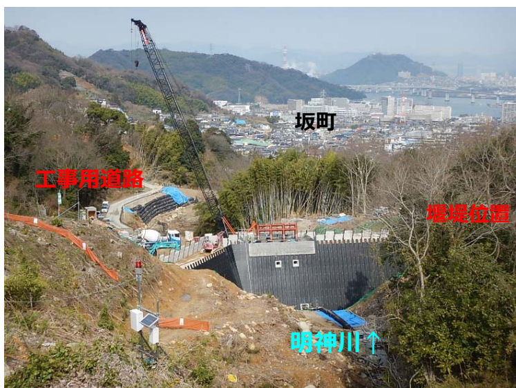
堰堤施工状況(上流より)
