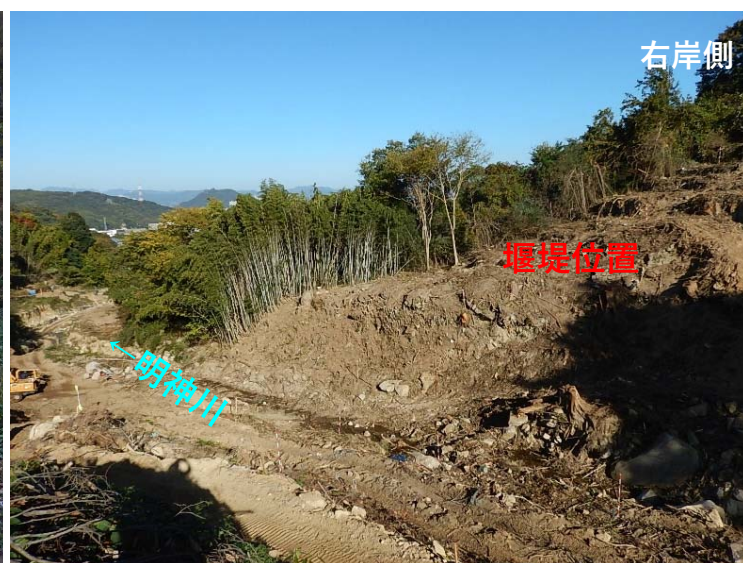
堰堤付近伐採状況
