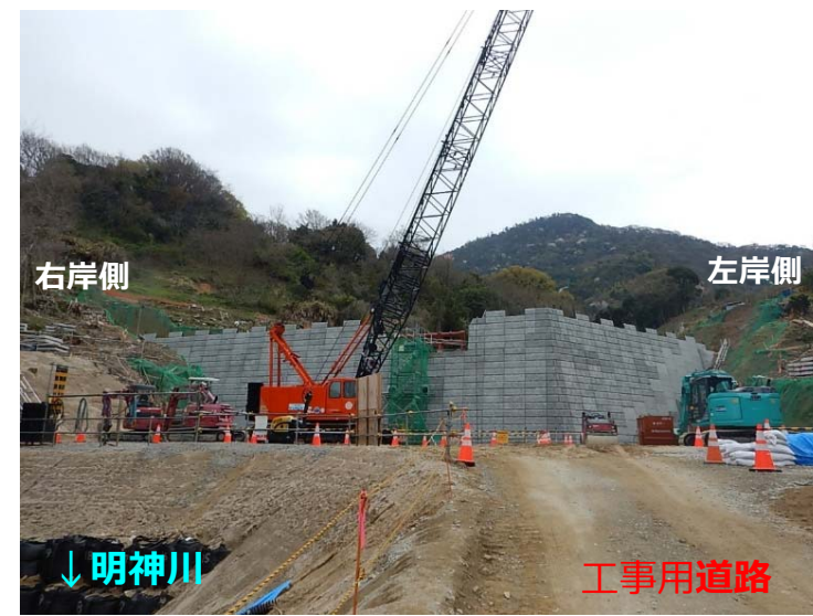
堰堤施工状況(堰堤直下)
