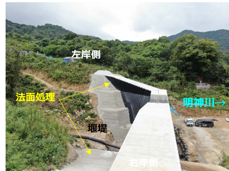
堰堤施工状況(右岸側より)
