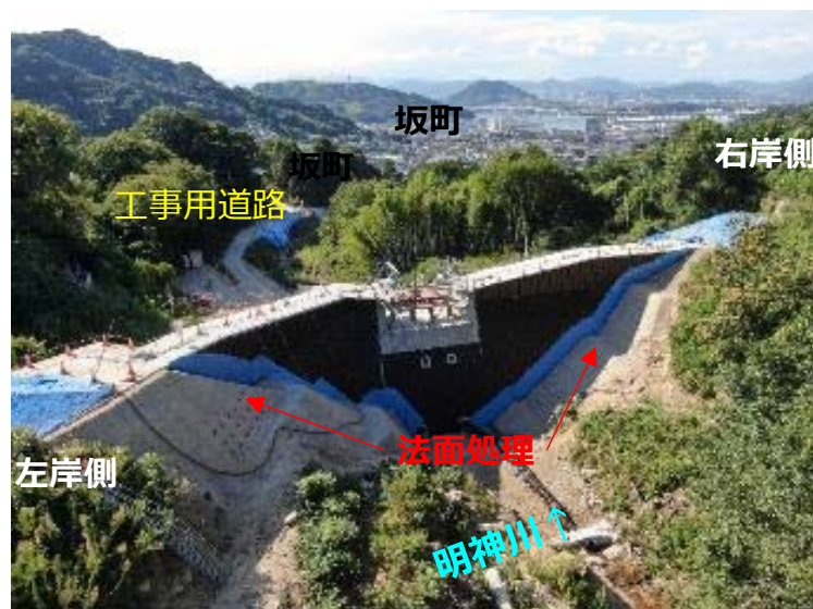
堰堤施工状況(上流より)
