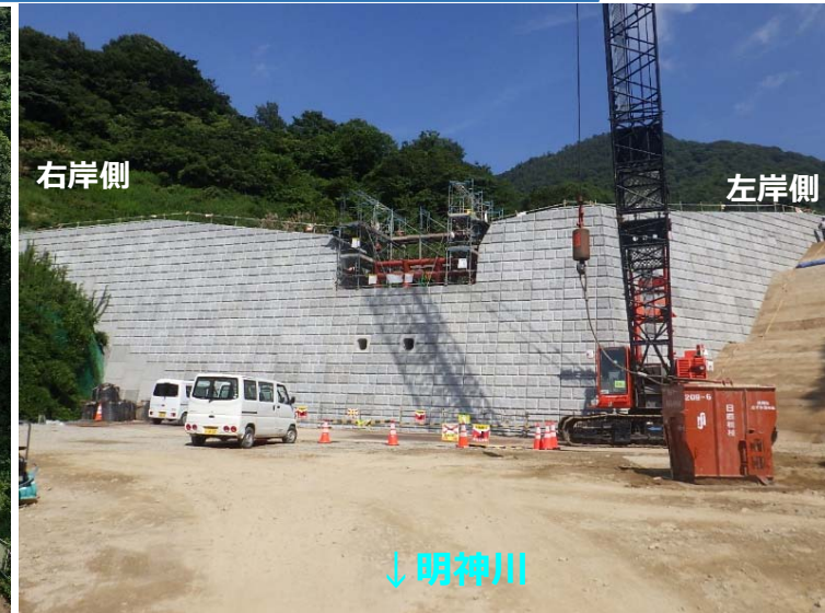
堰堤施工状況(堰堤直下)
