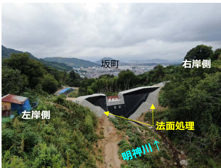
堰堤施工状況(上流より)
