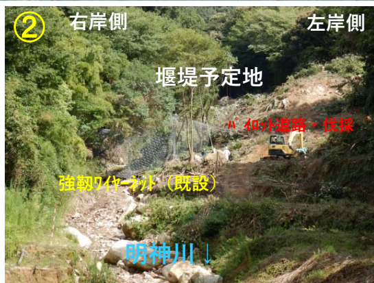
明神川砂防堰堤付近 伐採状況
