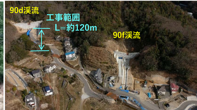
砂防堰堤全景（90d, 90f溪流）
