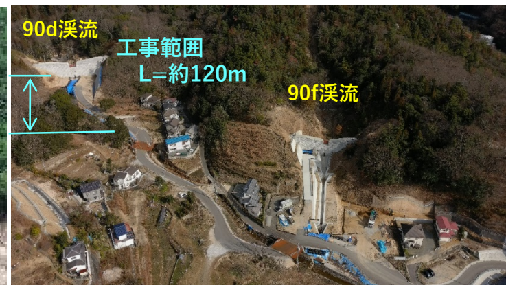
砂防堰堤全景（90d, 90f溪流）
