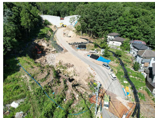
下流側より（全景）
