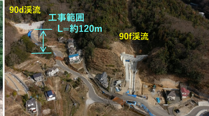
砂防堰堤全景（90d，90f溪流）
