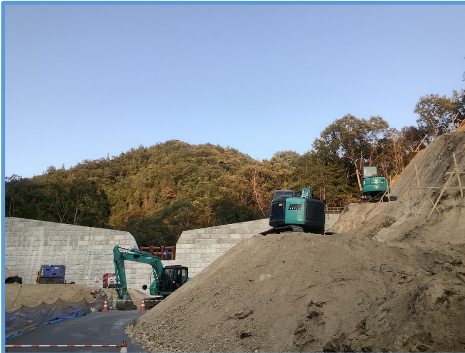
砂防堰堤左岸下流の法面掘削状況
