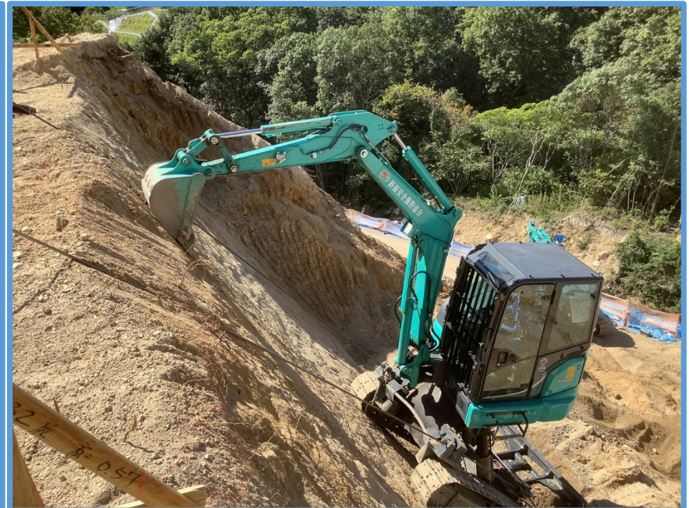
砂防堰堤左岸下流の法面掘削状況
