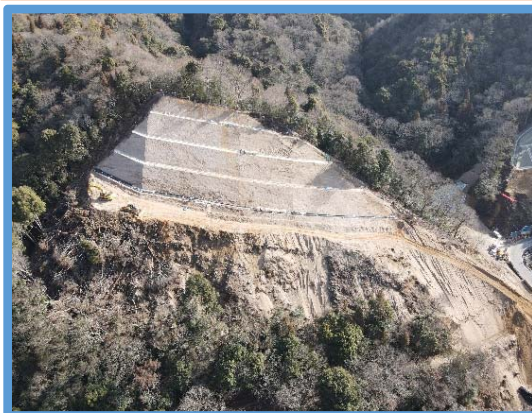
施工中（1月29日時点）
