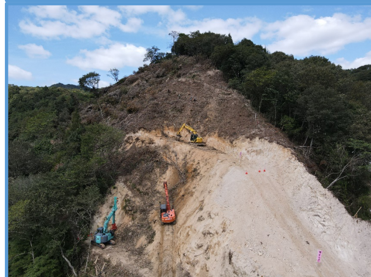
管理道の掘削状況
