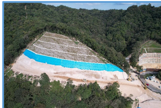
施工中（9月30日時点）
