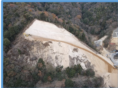
施工中（12月23日時点）
