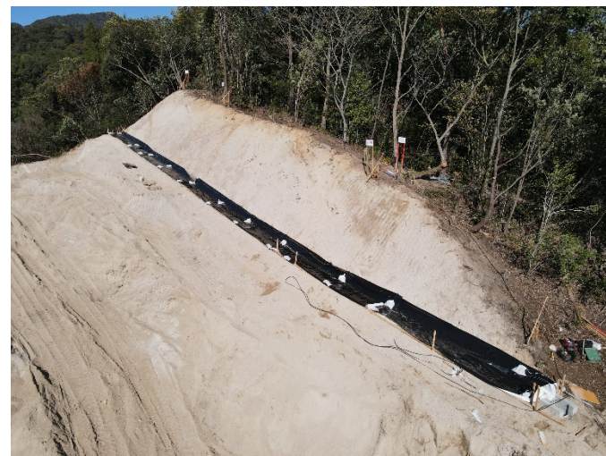
管理道の法面掘削実施状況
