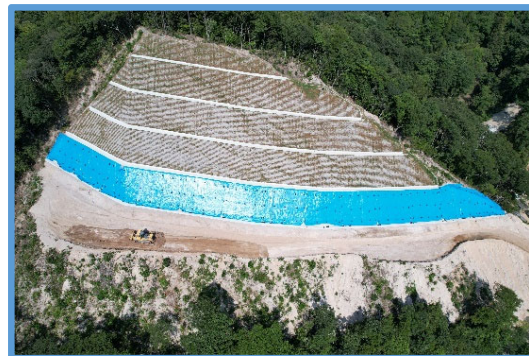
施工中（8月4日時点）
