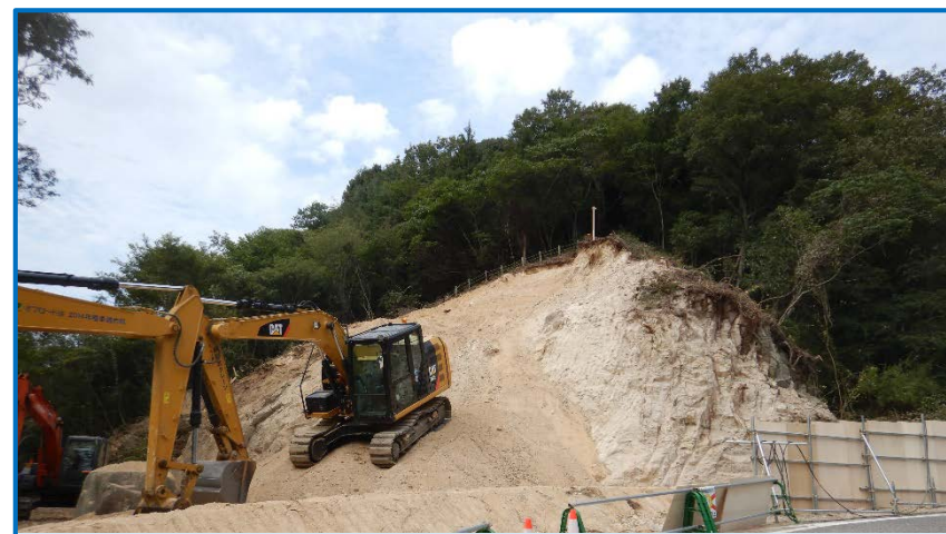
管理道の掘削状況
