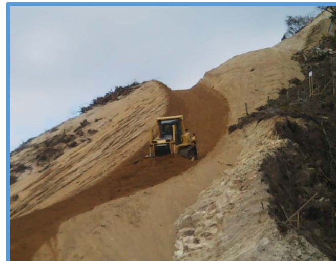
管理道の法面掘削実施状況
