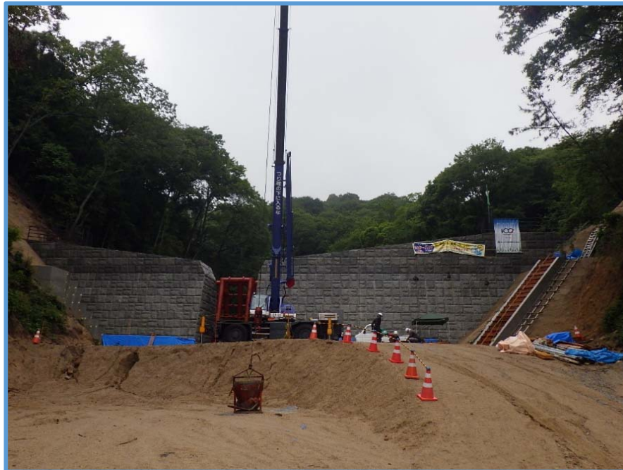
砂防堰堤の階段工実施状況
