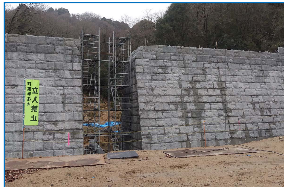
砂防堰堤本体のコンクリート打設状況
