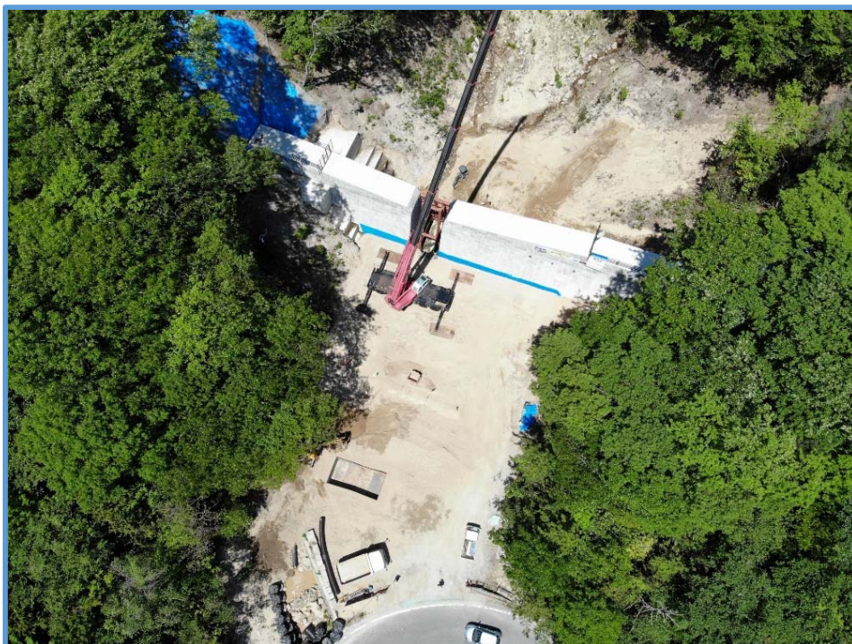
砂防堰堤の埋戻し実施状況
