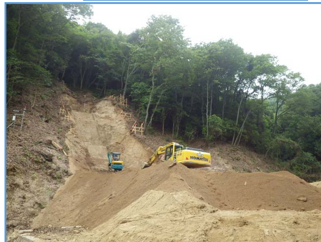
砂防堰堤の本体掘削状況②
