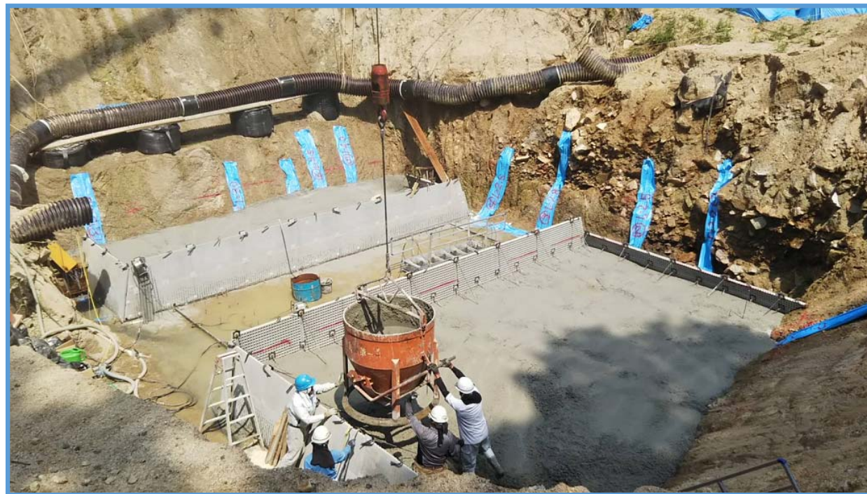
砂防堰堤本体のコンクリート打設状況
