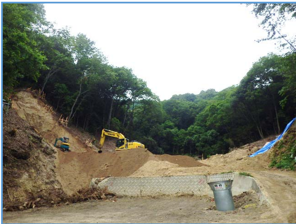
砂防堰堤の本体掘削状況①
