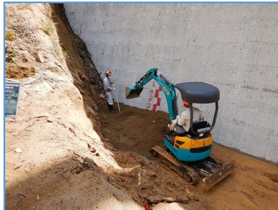
砂防堰堤の埋戻し実施状況
