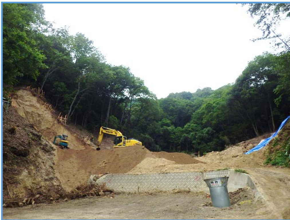
砂防堰堤の本体掘削状況①
