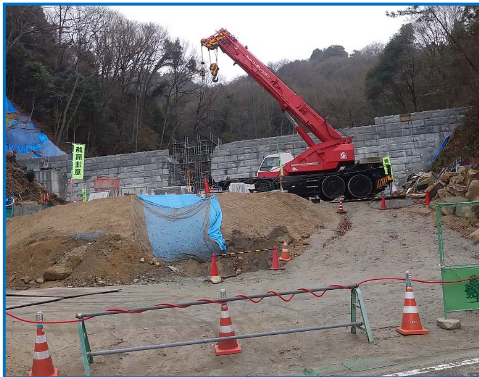
砂防堰堤本体のコンクリート打設状況
