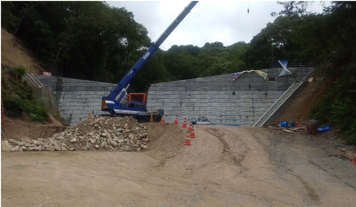
砂防堰堤の階段工実施状況
