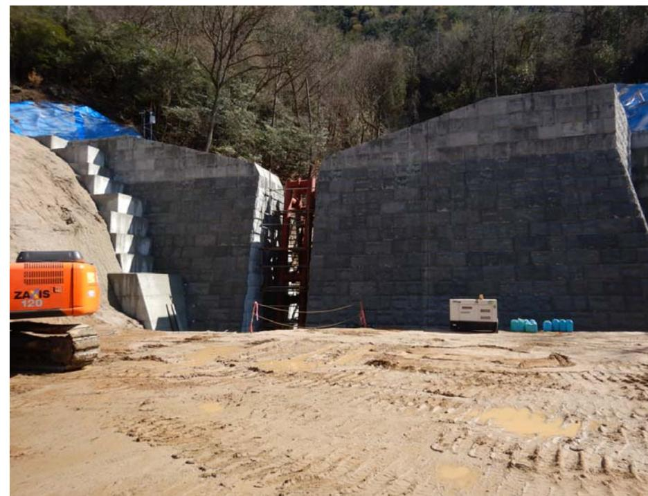
スリット（鋼製杵）設置状況
