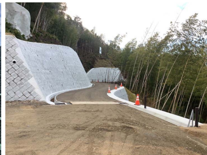
92隣h溪流 管理用道路 施工状況
