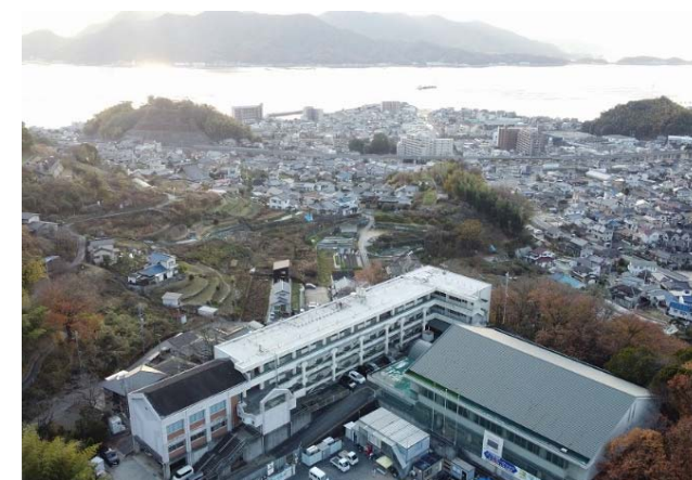
旧天応中学校より瀬戸内海を望む
