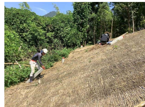
境界杭 施工状況
