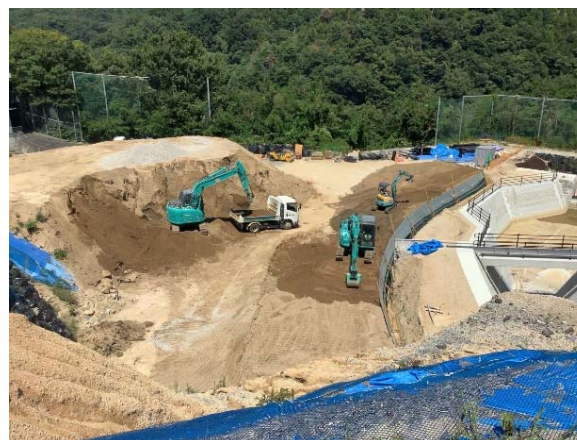
92隣e溪流 管理用道路の施工状況
