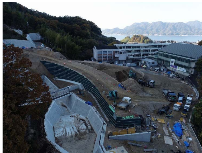
92隣e溪流 管理用道路の施工状況
