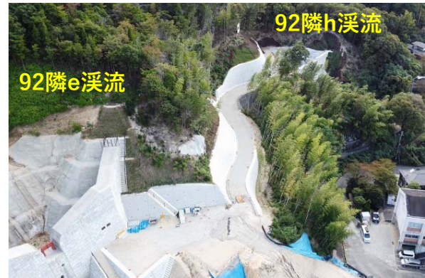
92隣h溪流 管理用道路の施工状況
