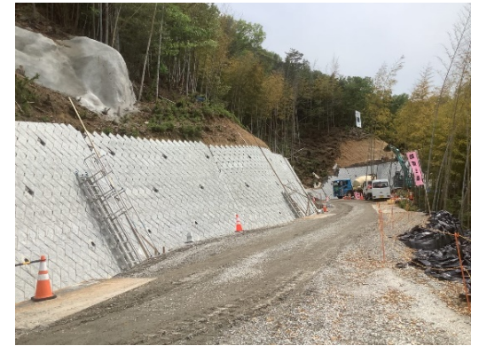
管理用道路 施工状況
