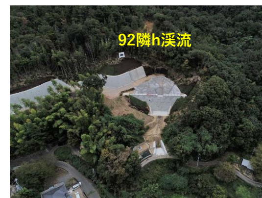
92隣h溪流 施工状況
