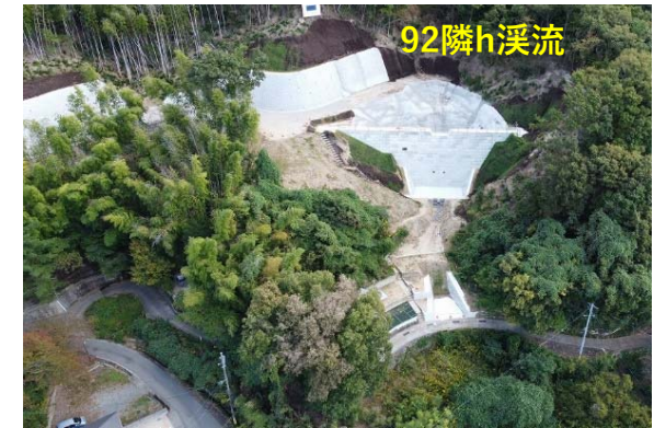
92隣h溪流 施工状況
