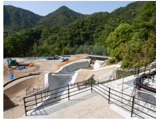
92隣e溪流 施工状況
