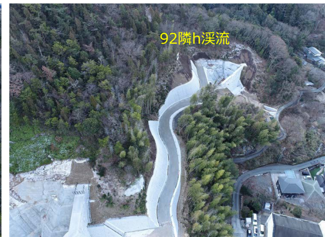
92隣h溪流 管理用道路 施工状況
