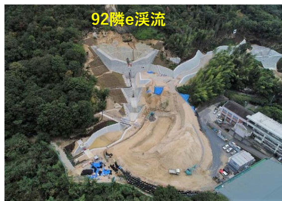
92隣e溪流 管理用道路の施工状況
