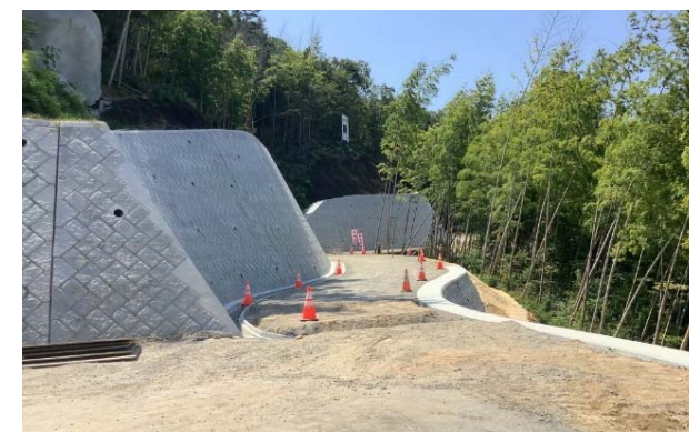
92隣h溪流 管理用道路の施工状況
