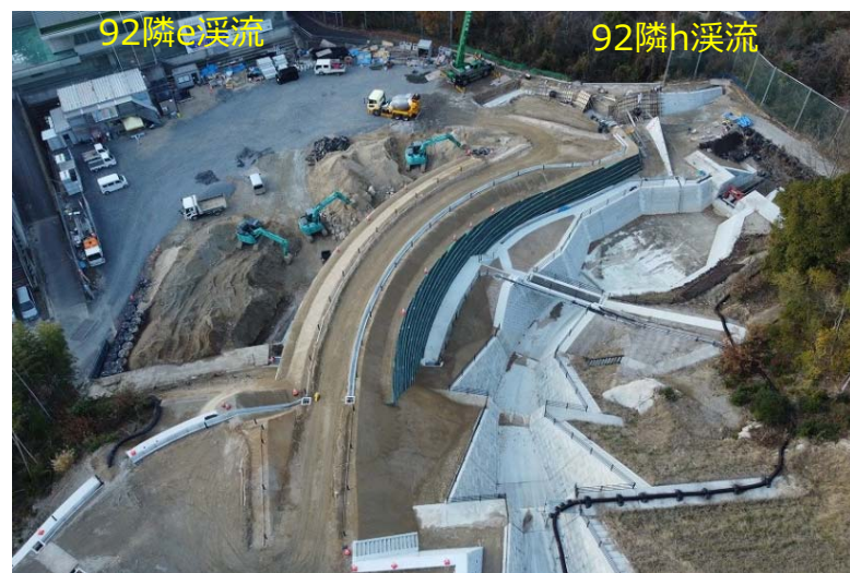
92隣e溪流 管理用道路の施工状況
