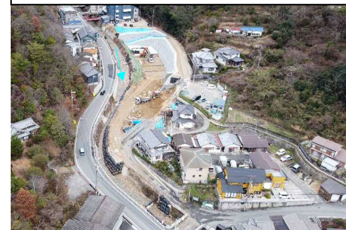
全景 (下流側より)
