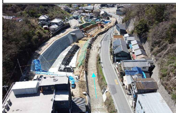
全景 (上流側より)
