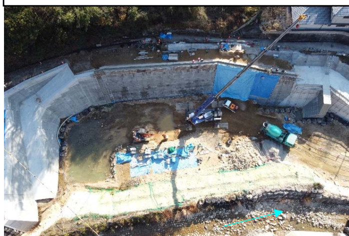
大型ブロック積み (左岸側)
