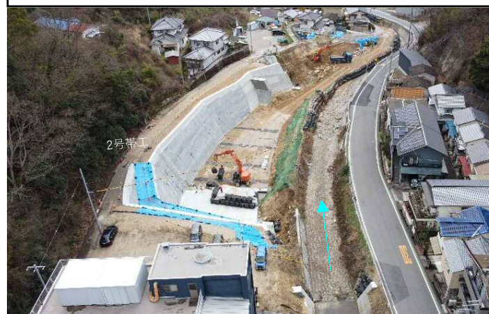
全景 (上流側より)
