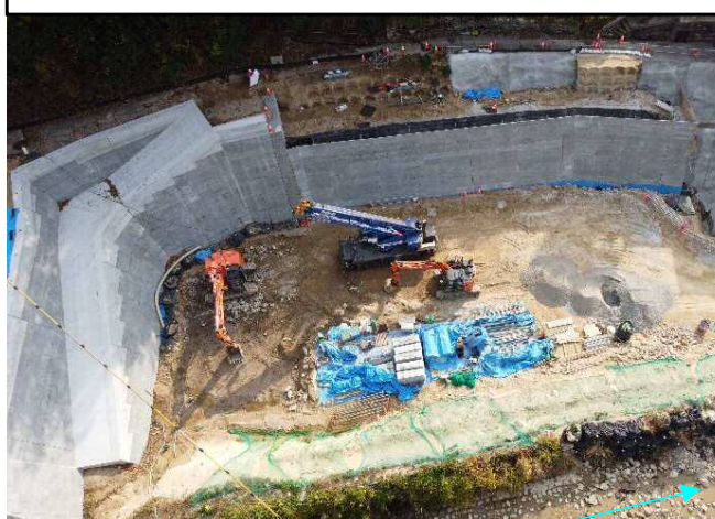
大型ブロック積み(左岸側)
