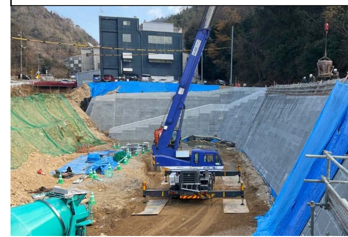
コンクリート打設状況
