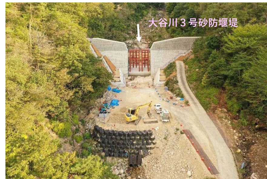
【大谷川 3号砂防堰堤】
