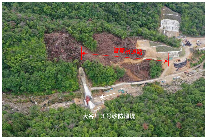
【管理用道路施工状況】
