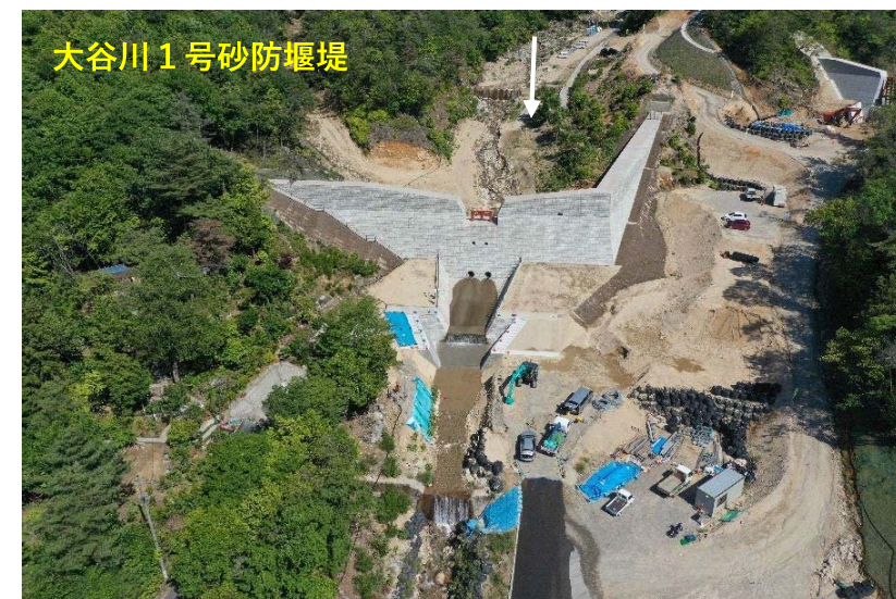
【大谷川1号砂防堰堤・法面整形等施工状況】
