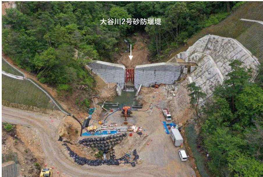
【大谷川 2号砂防堰堤施工状況】
