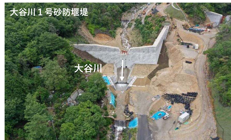
【大谷川1号砂防堰堤】
