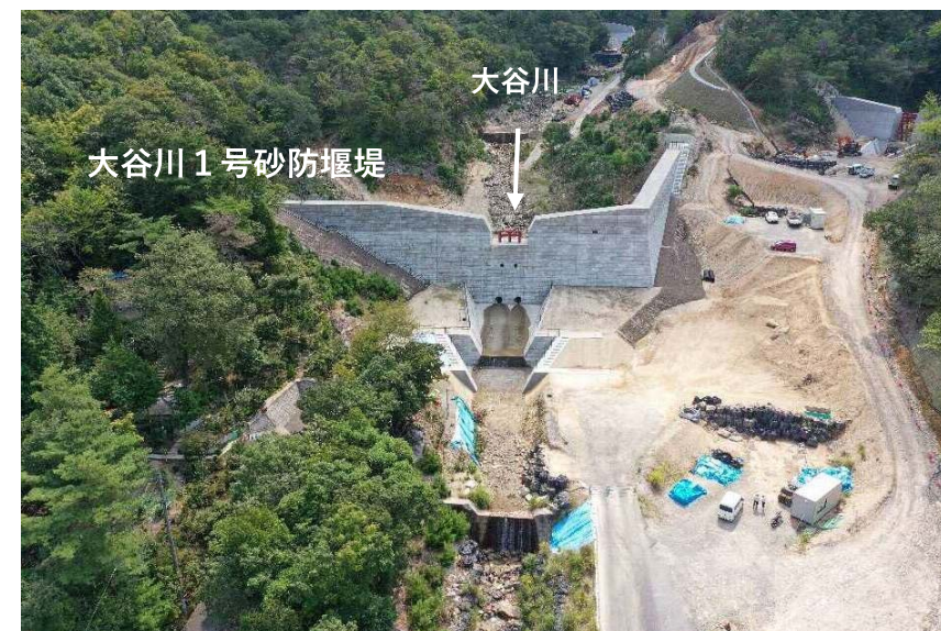
【大谷川1号砂防堰堤】
