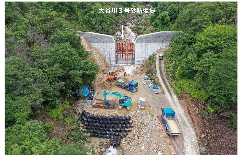
【大谷川 3号砂防堰堤施工状況】
