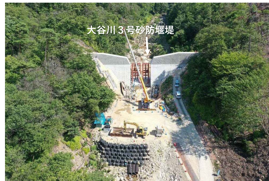
【大谷川 3号砂防堰堤】
