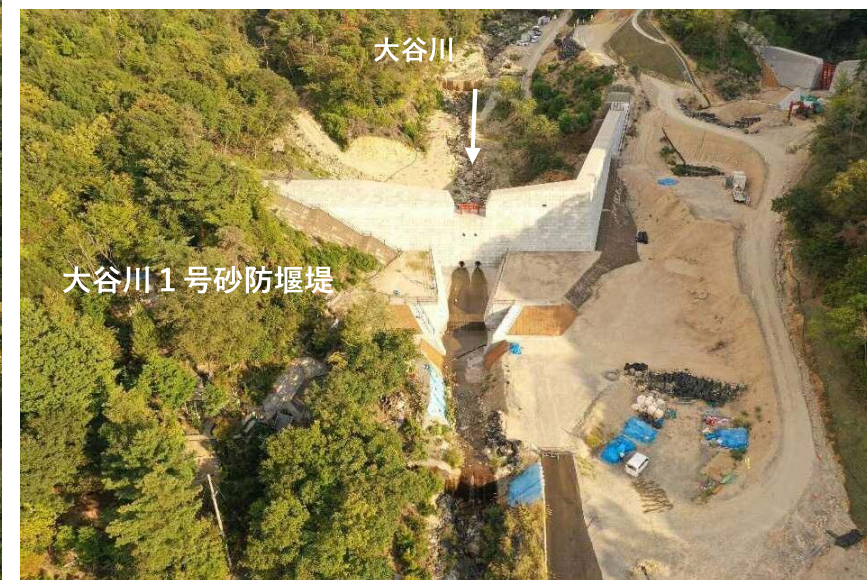
【大谷川1号砂防堰堤】
