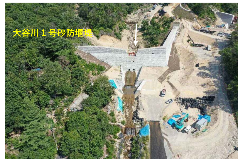
【大谷川1号砂防堰堤】
