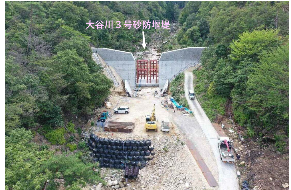
【大谷川 3号砂防堰堤】
