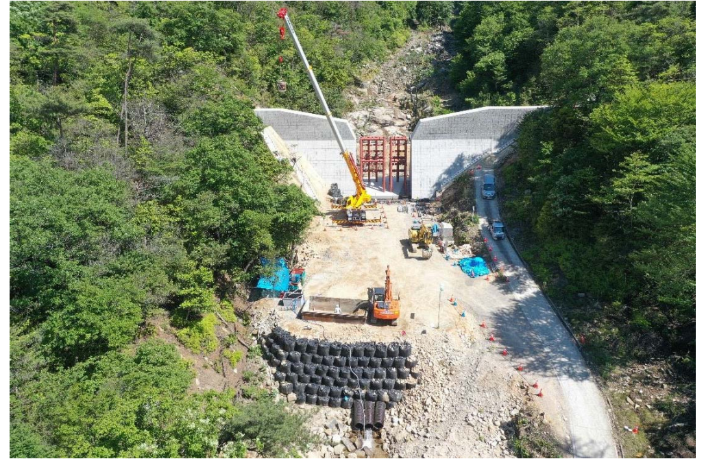
【大谷川 3号砂防堰堤・管理用階段等を施工中】
