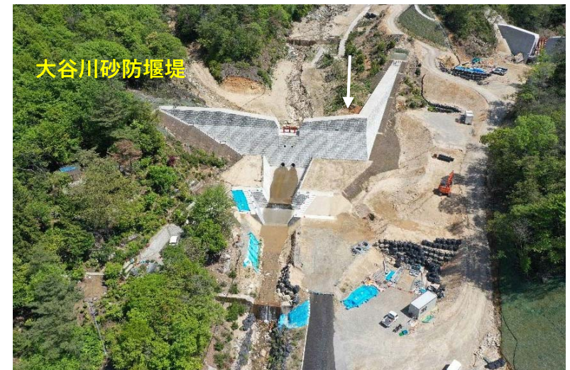
【大谷川砂防堰堤・法面整形等施工状況】
