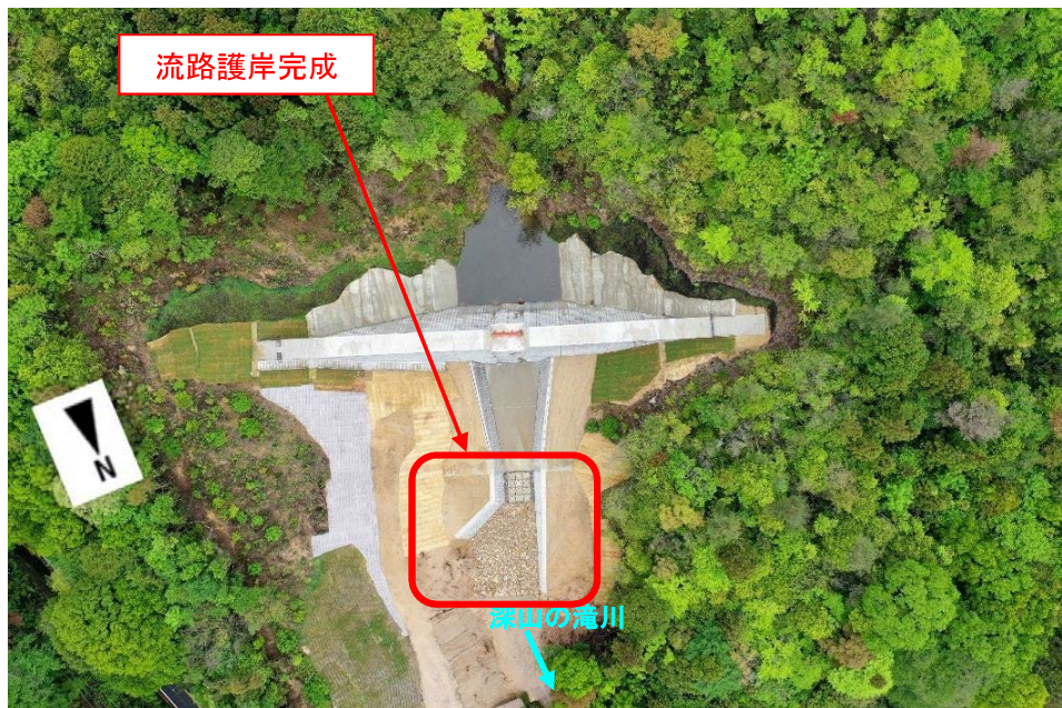
【深山の滝川 1号砂防堰堤状況】
