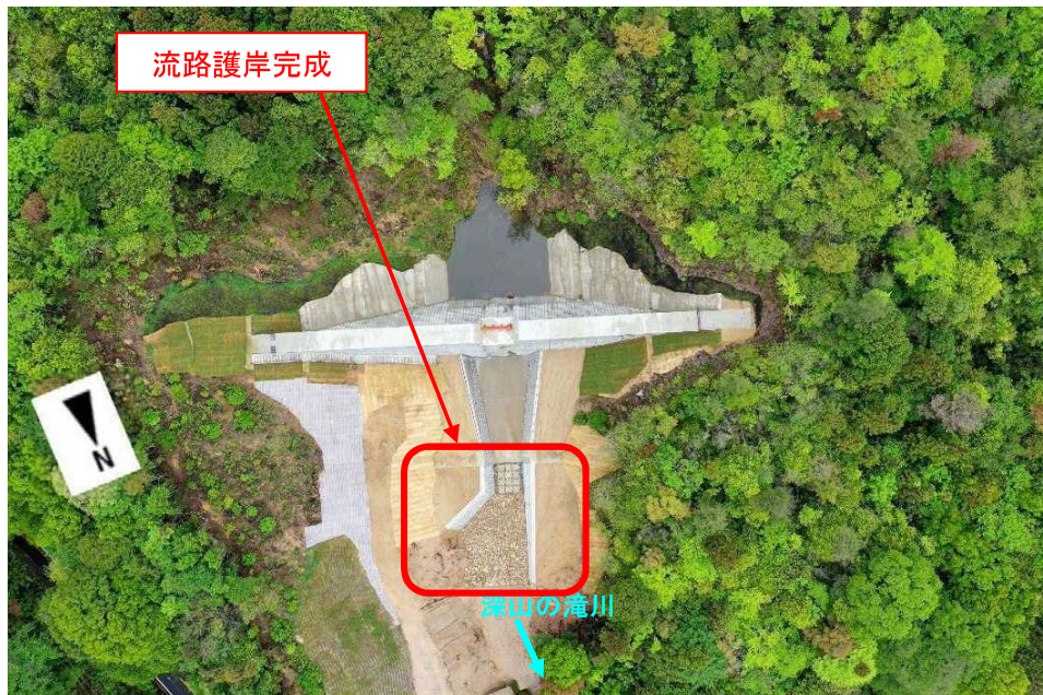
【深山の滝川 1号砂防堰堤状況】
