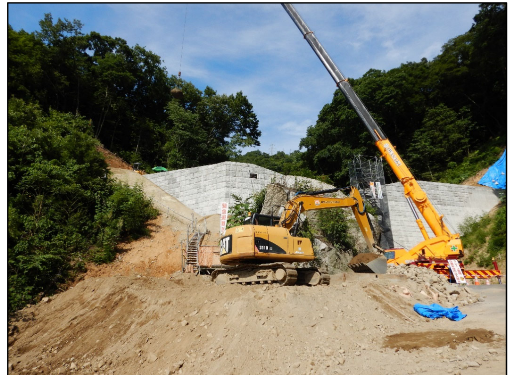
埋戻し施工状況
