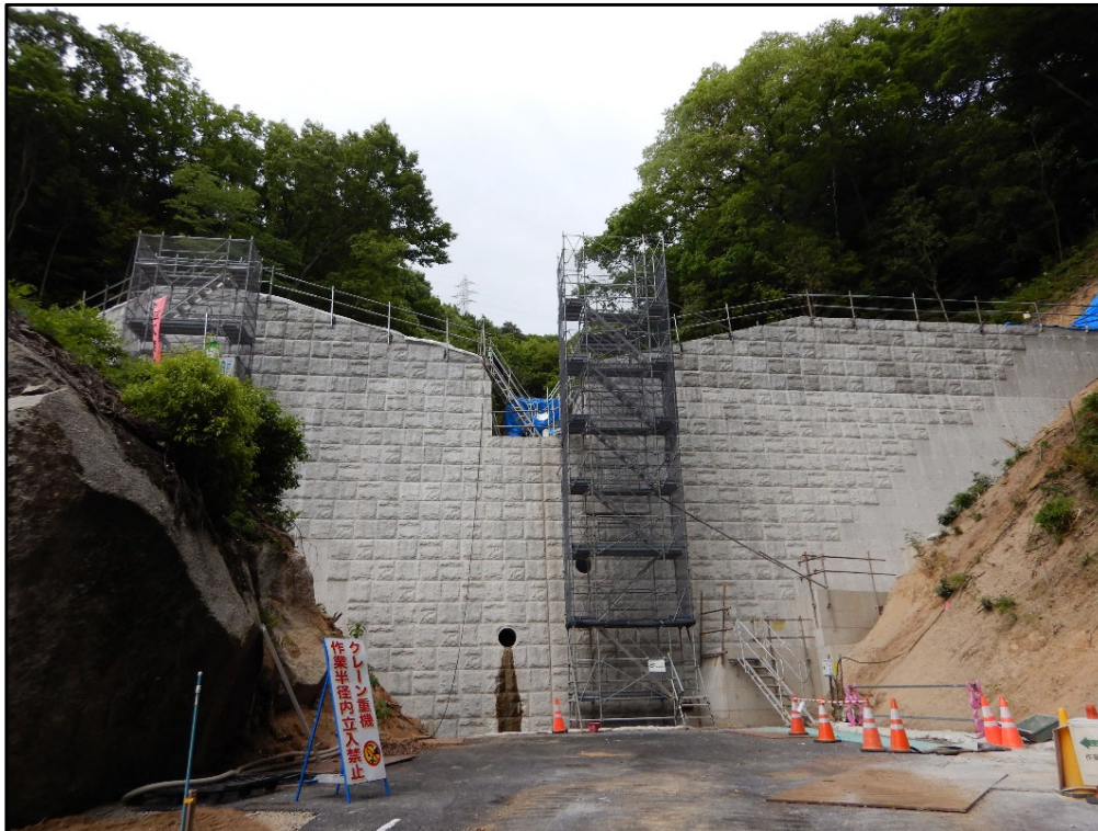
施工状況①
