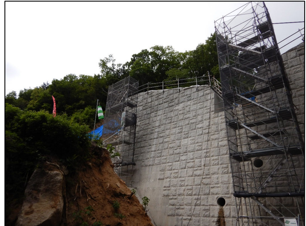
施工状況②
