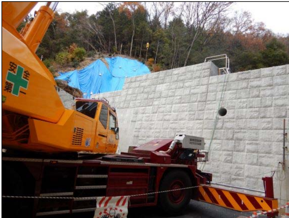
コンクリート打設状況①
