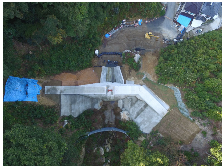
砂防堰堤全景
