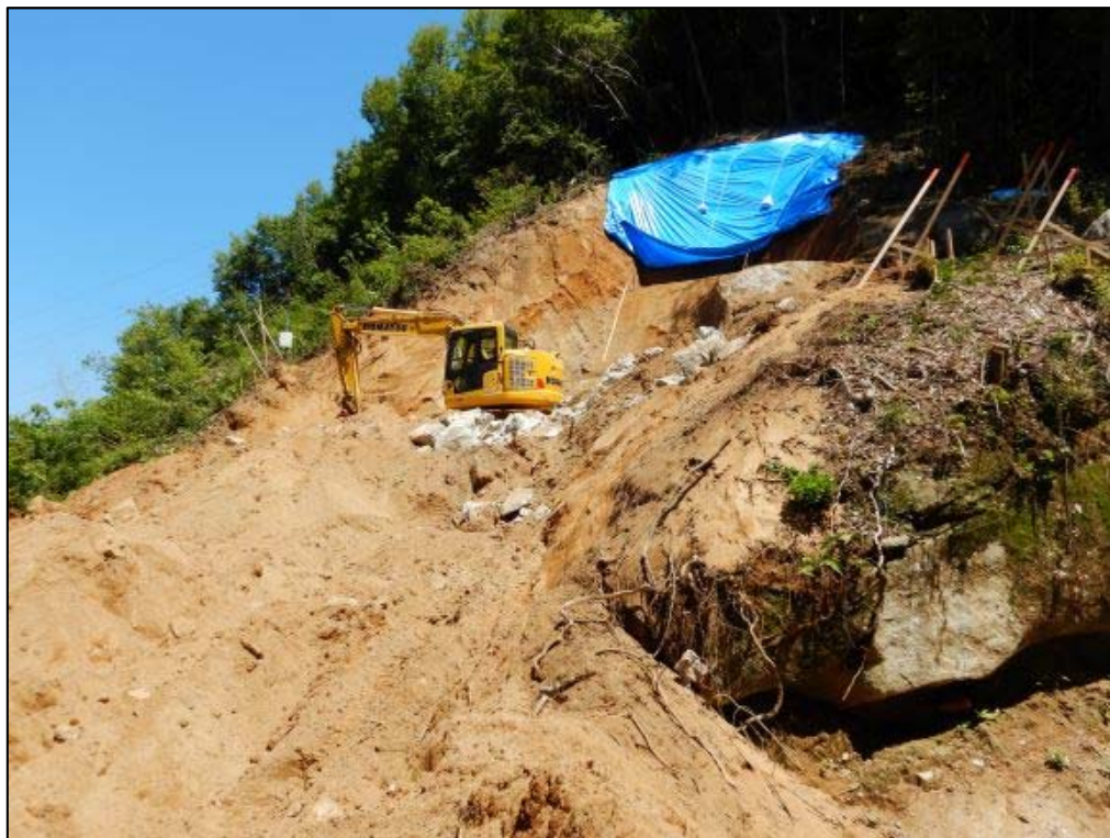
掘削作業状況①
