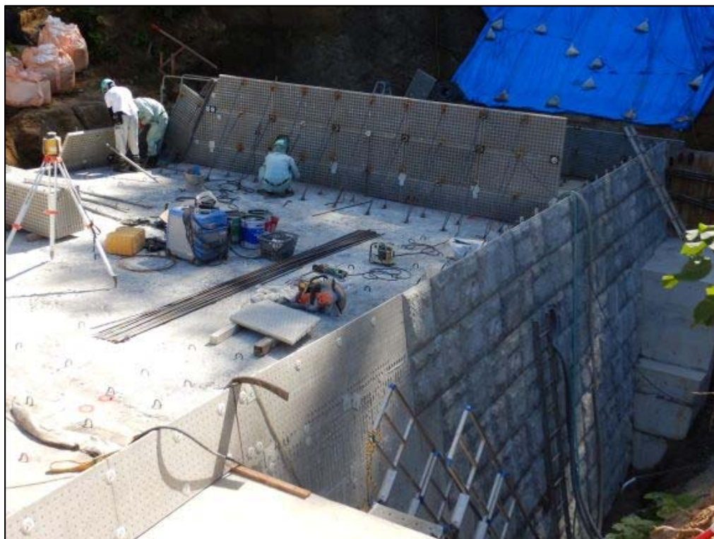
型枠施工状況
