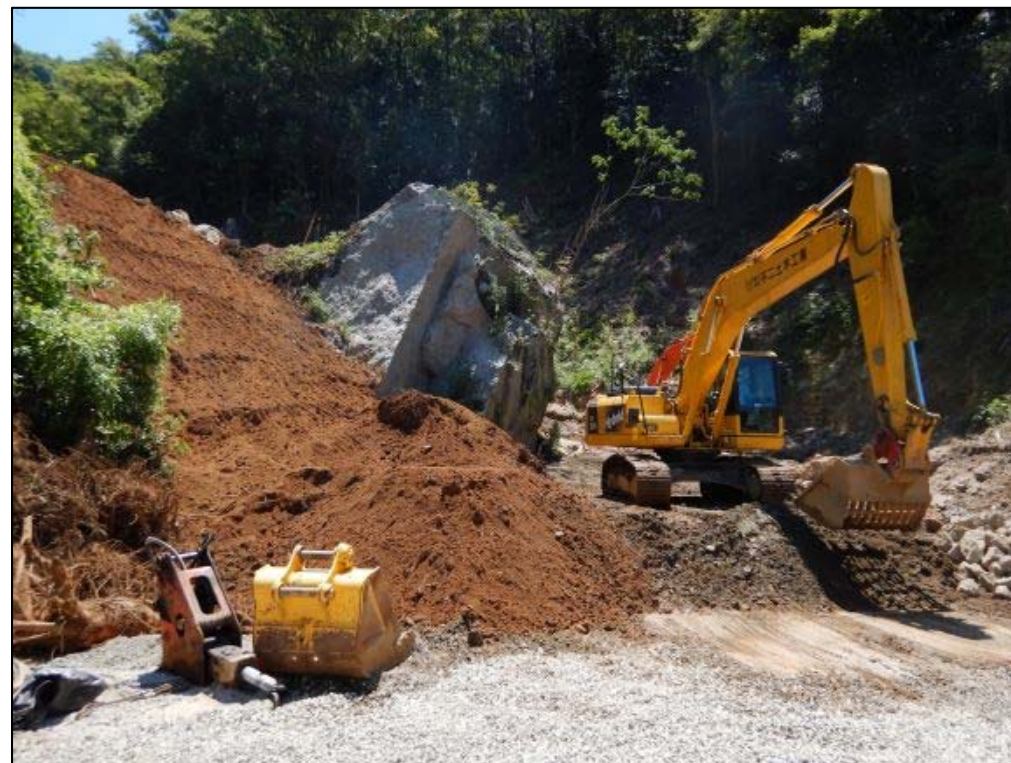
掘削作業状況②
