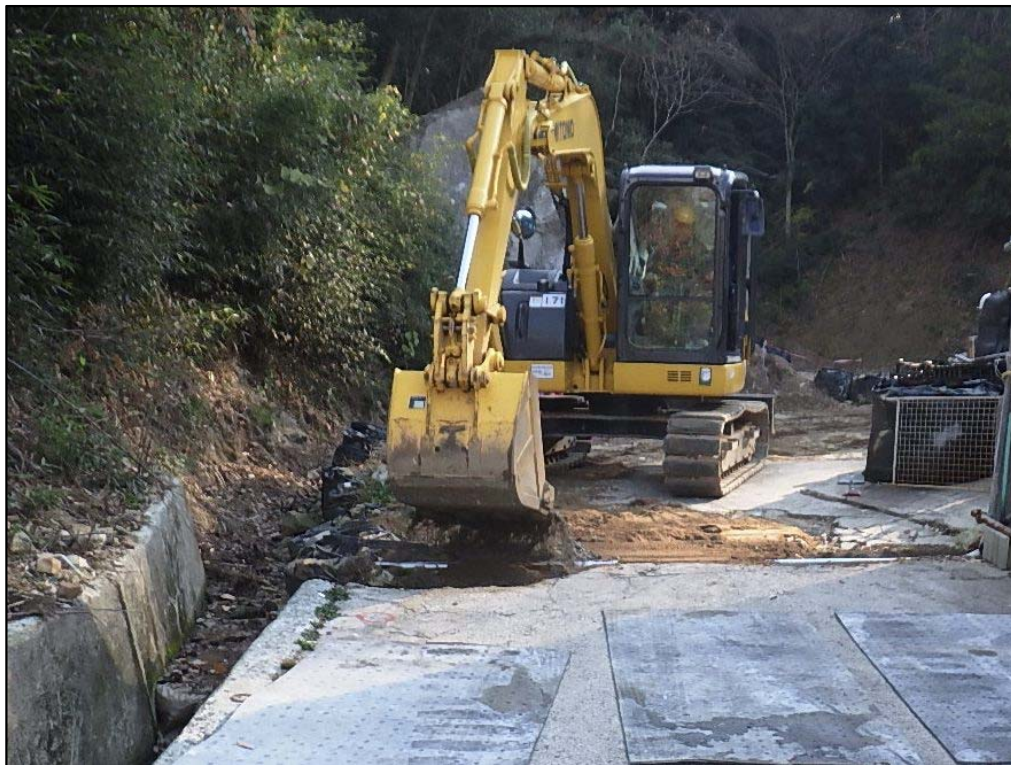
作業状況①
