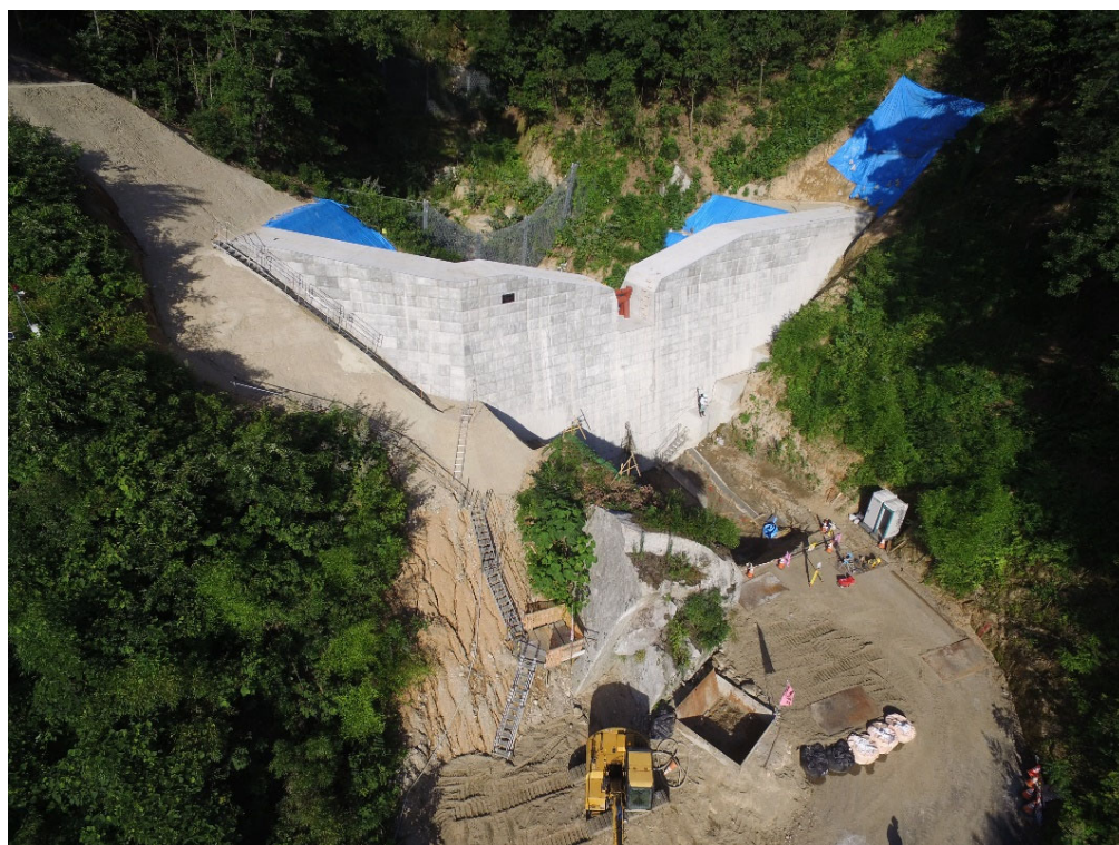
砂防堰堤全景
