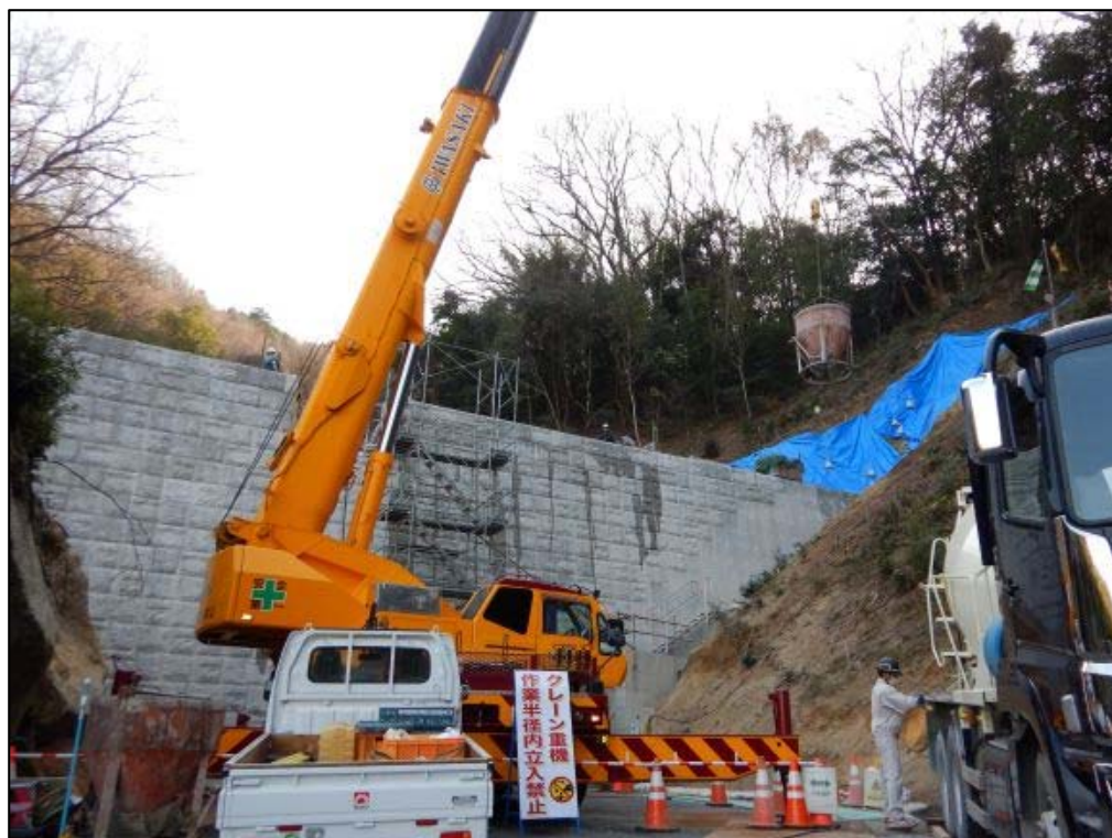
コンクリート打設状況①
