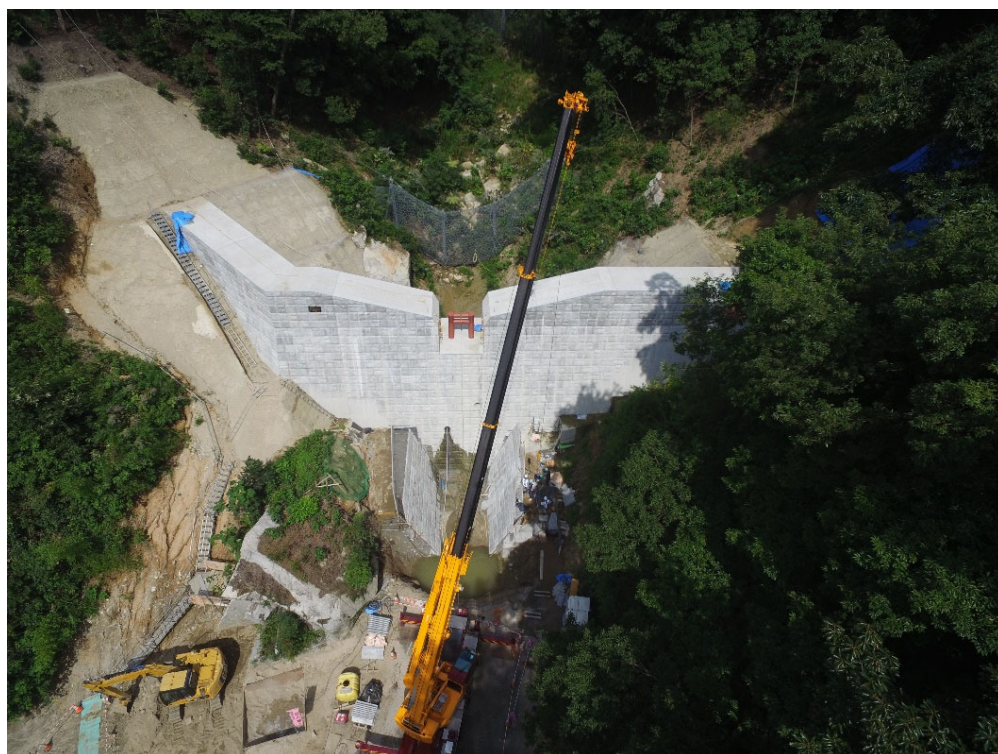
砂防堰堤全景
