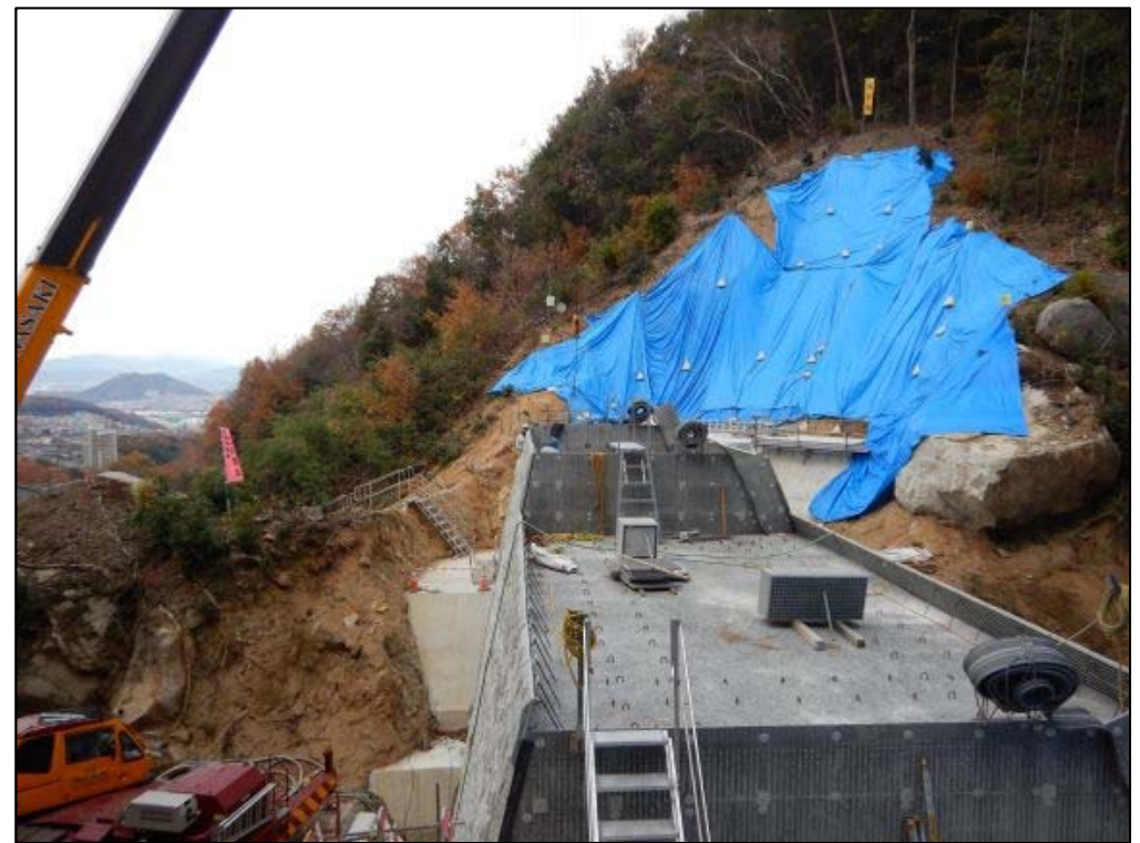
コンクリート打設状況②
