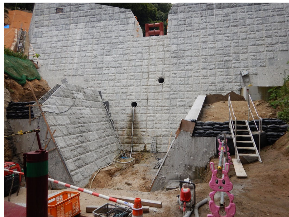
前庭保護工施工状況
