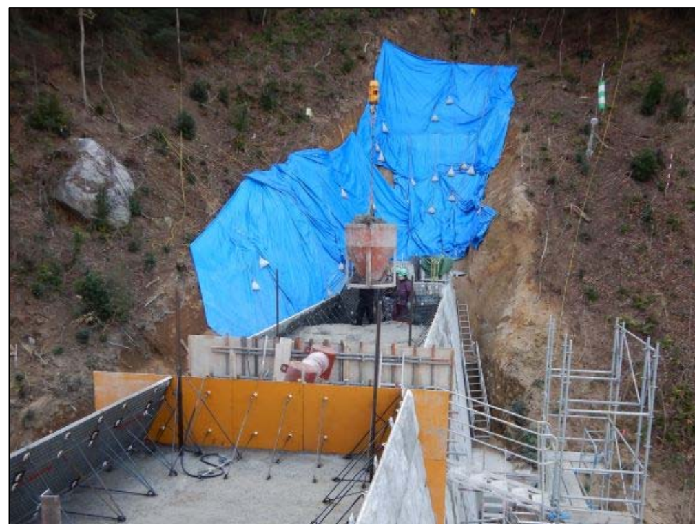
コンクリート打設状況②
