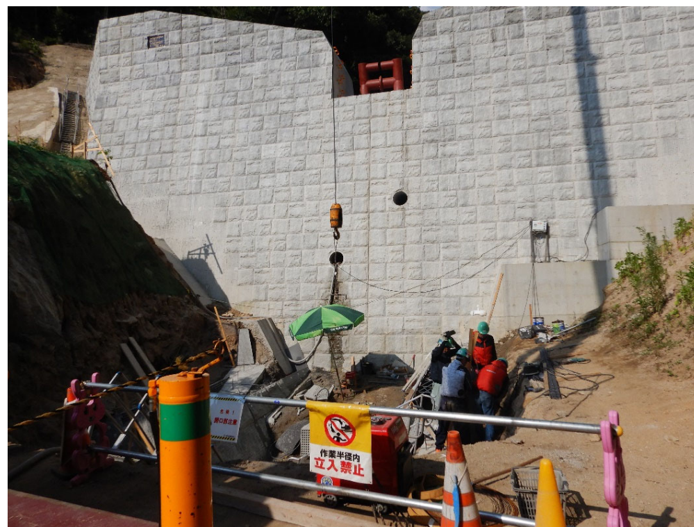
前庭保護工施工状況
