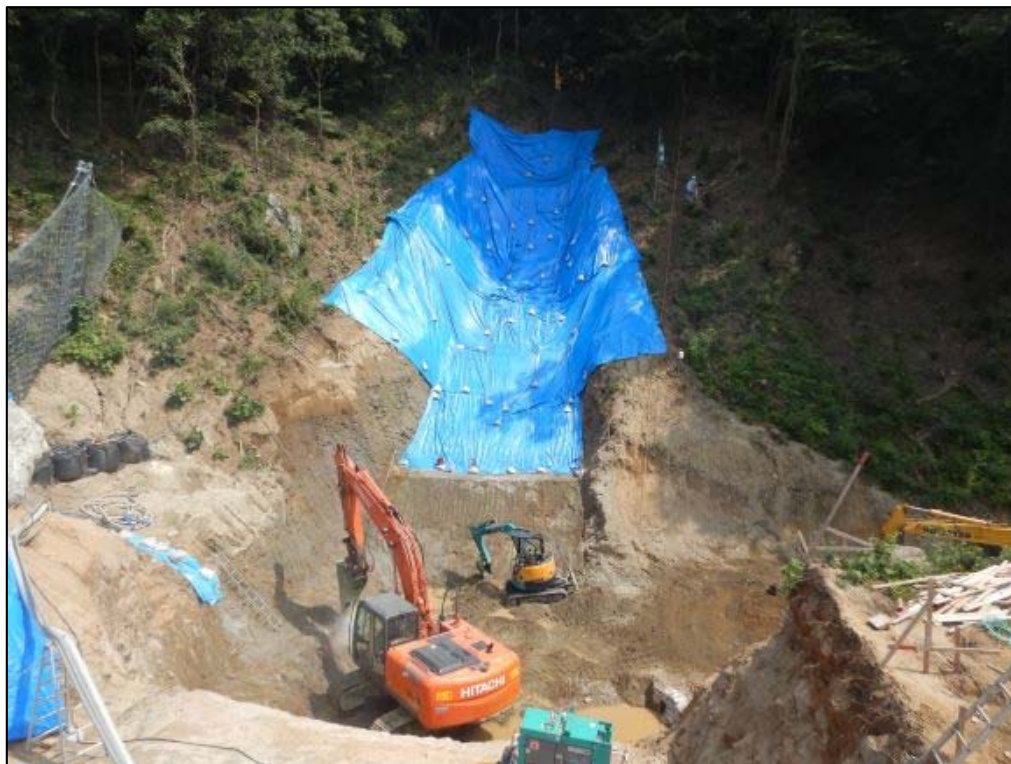
掘削作業状況
