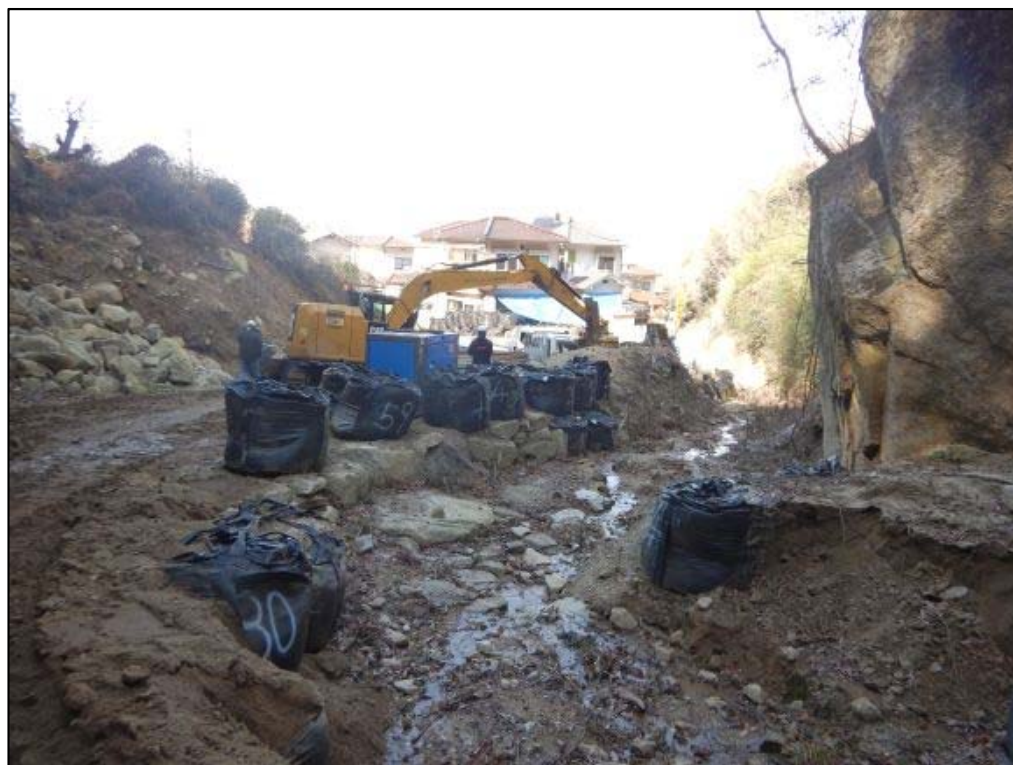
作業状況①
