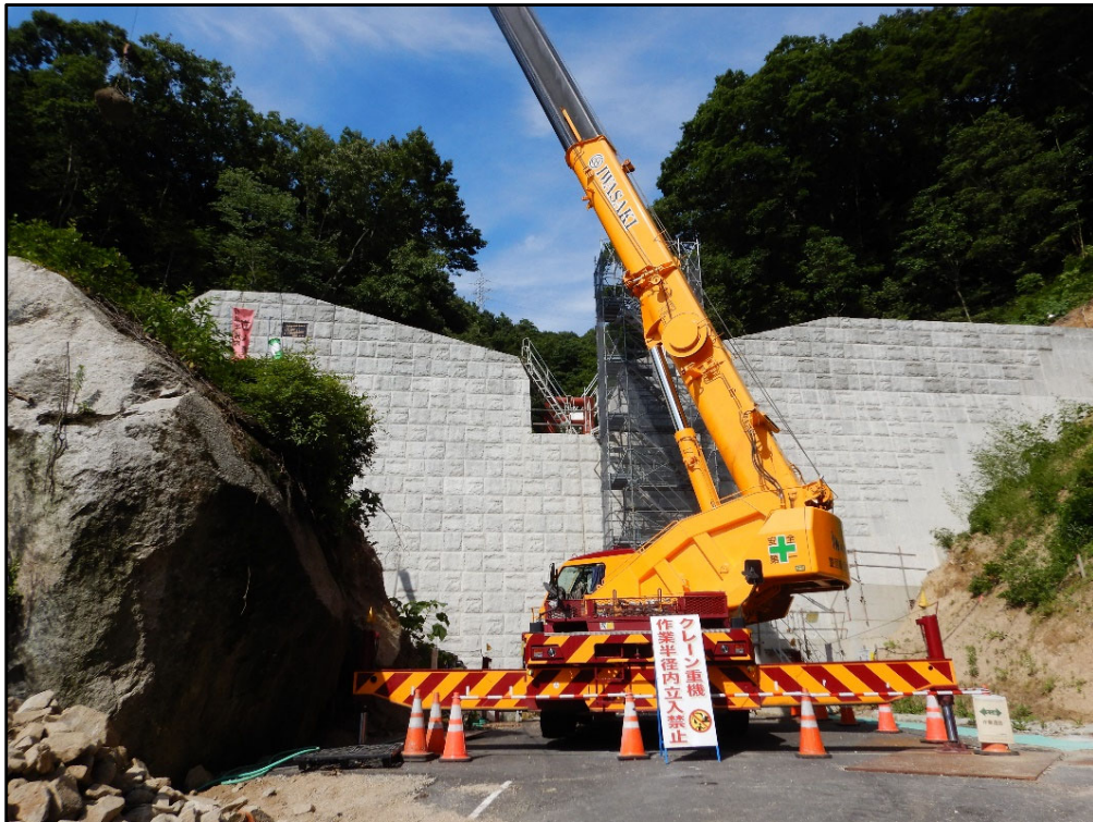
砂防堰堤全景
