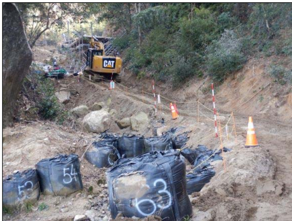
作業状況①
