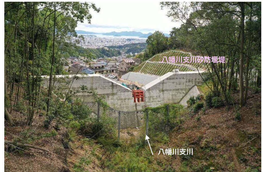
【施工状況（上流側より）】
