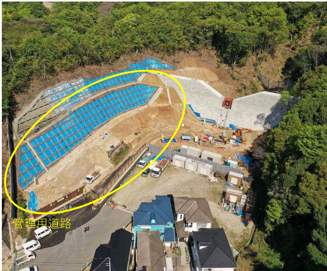
【施工状況（下流側より）】
