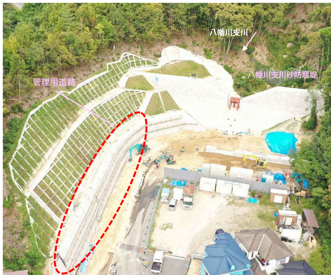
【施工状況（下流側より）】
