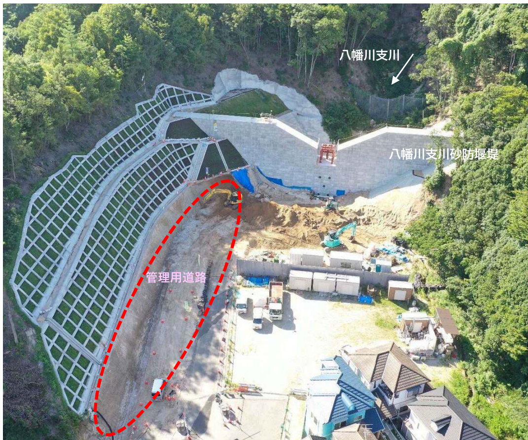
【施工状況（下流側より）】
