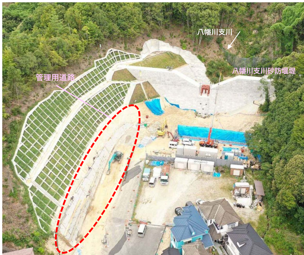
【施工状況（下流側より）】
