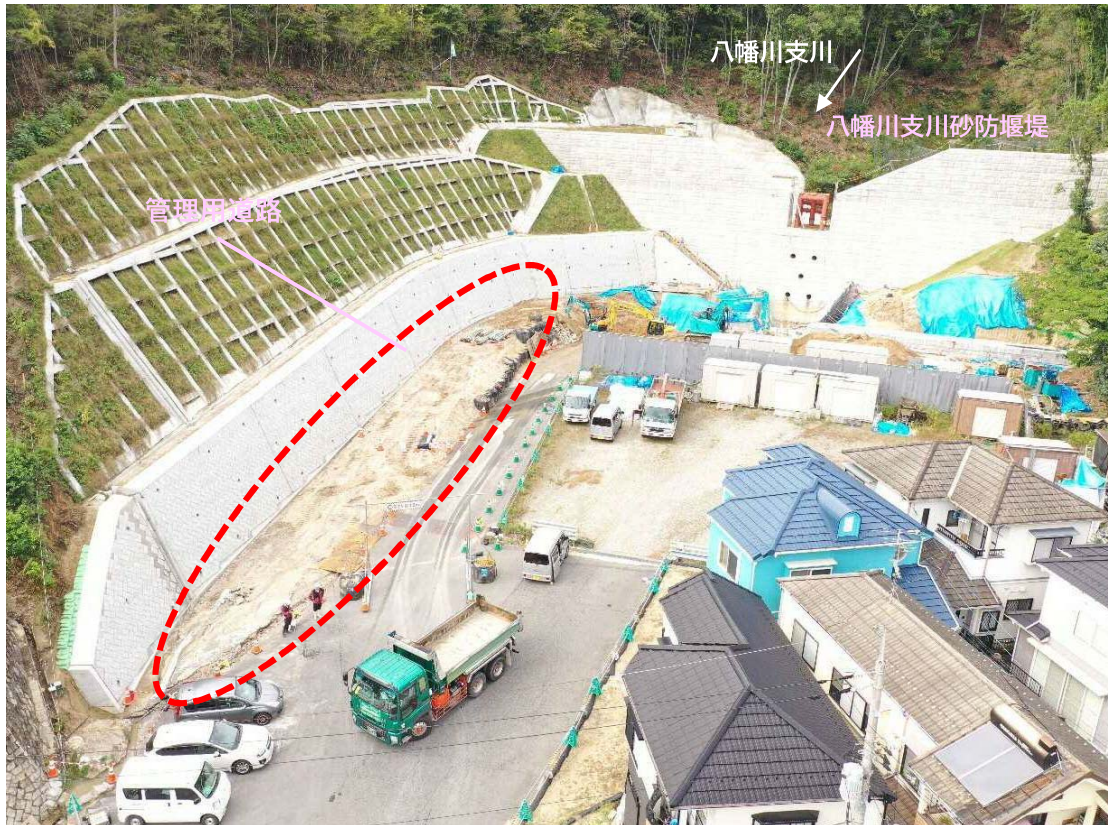
【施工状況（下流側より）】
