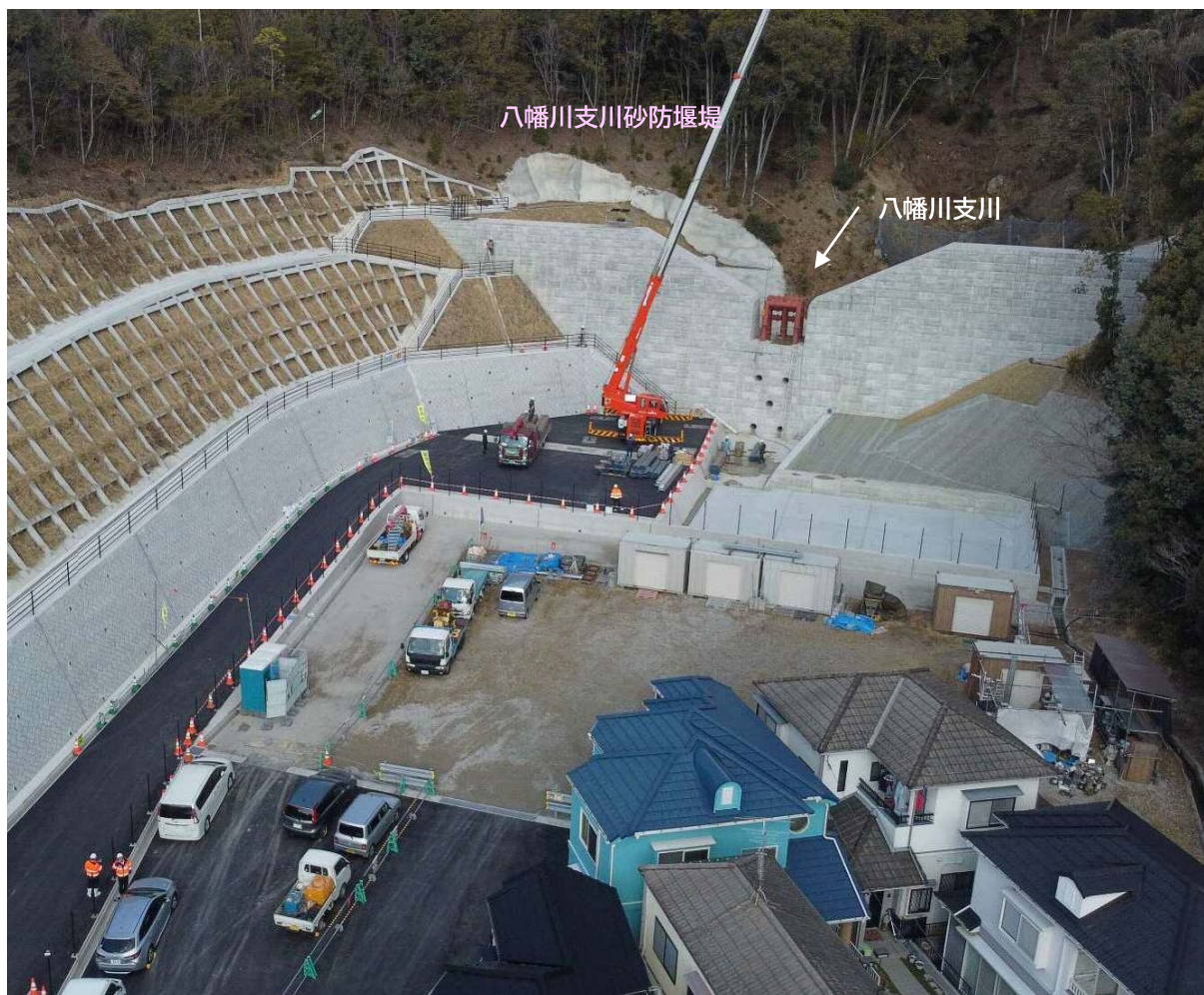
【施工状況（下流側より）】
