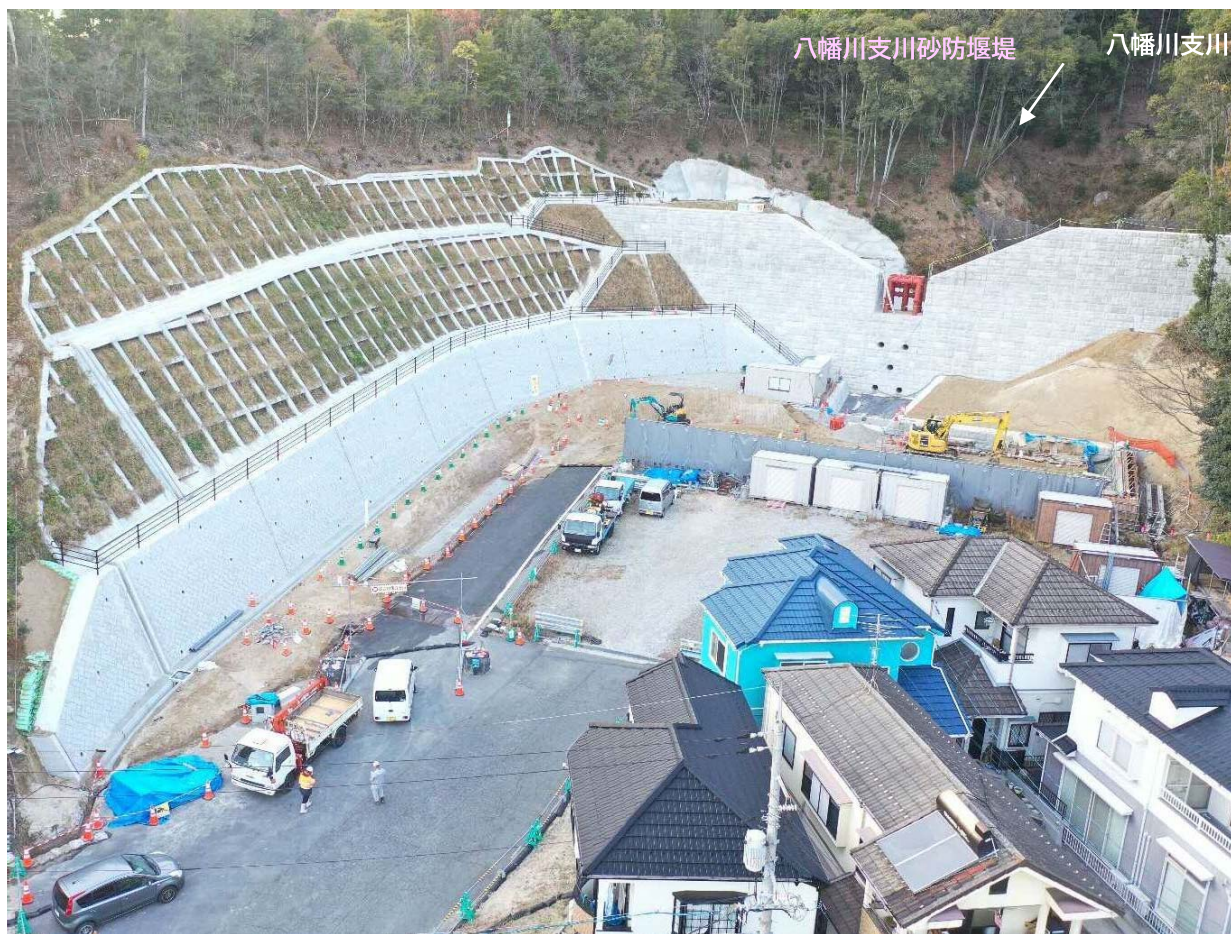
【施工状況（下流側より）】
