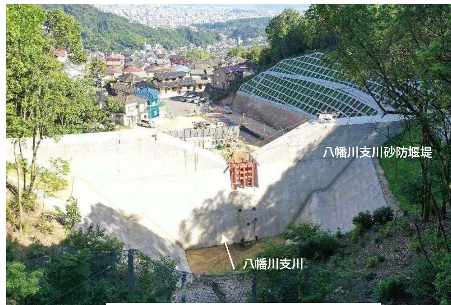
【施工状況（上流側より）】
