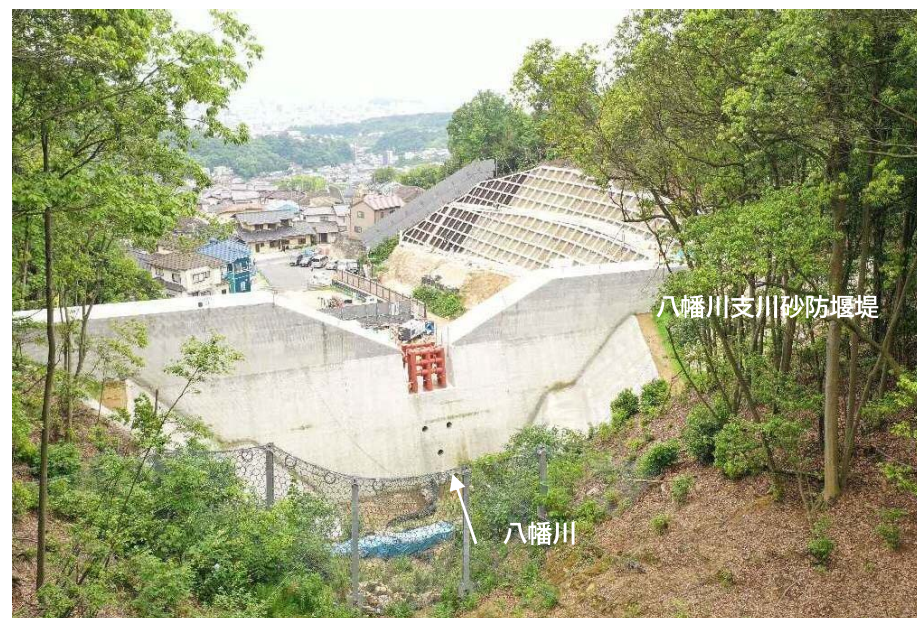
【施工状況（上流側より）】
