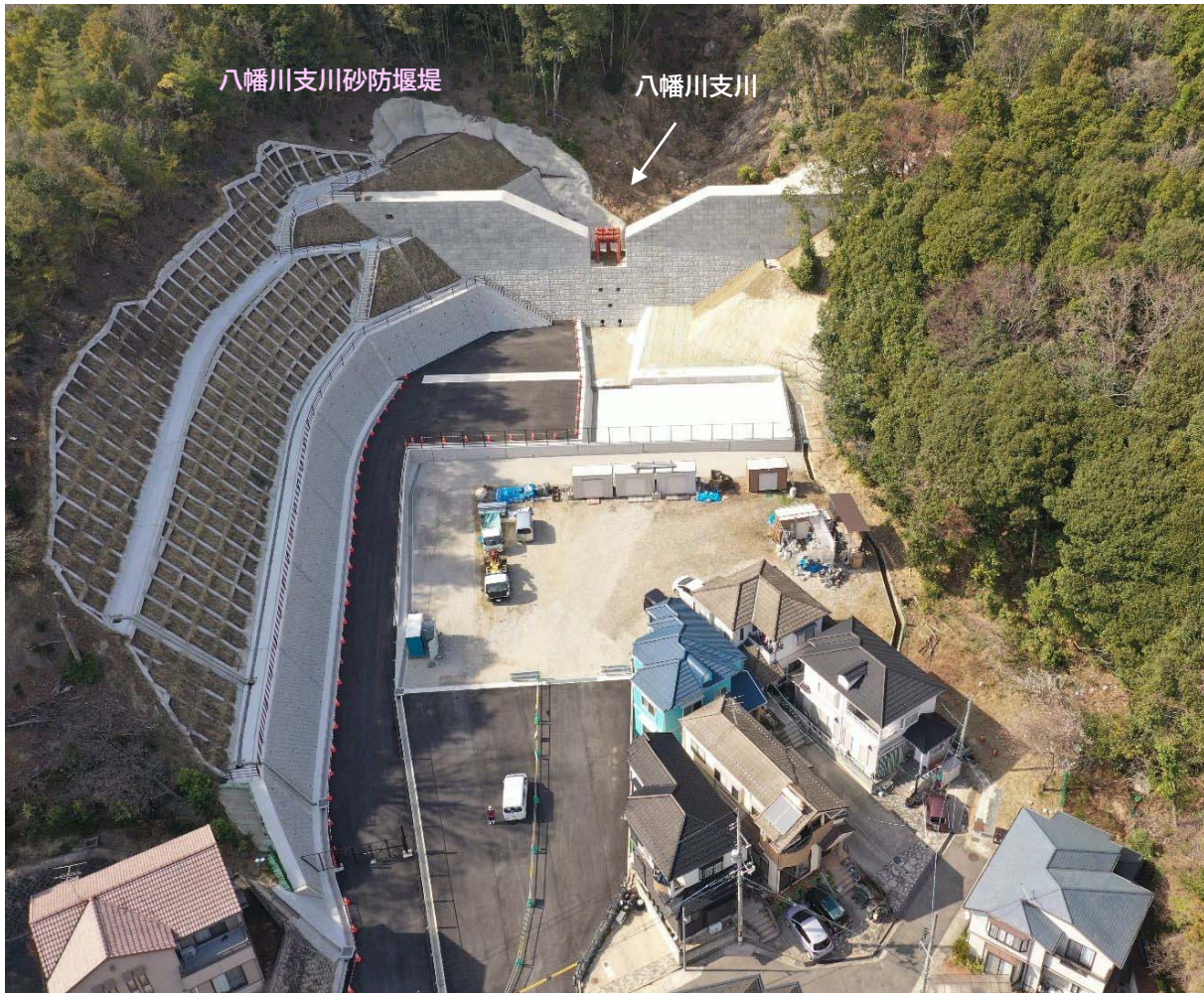
【施工状況（下流側より）】
