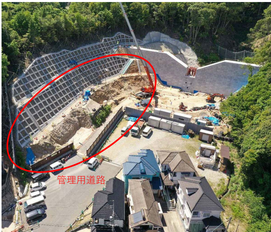
【施工状況（下流側より）】
