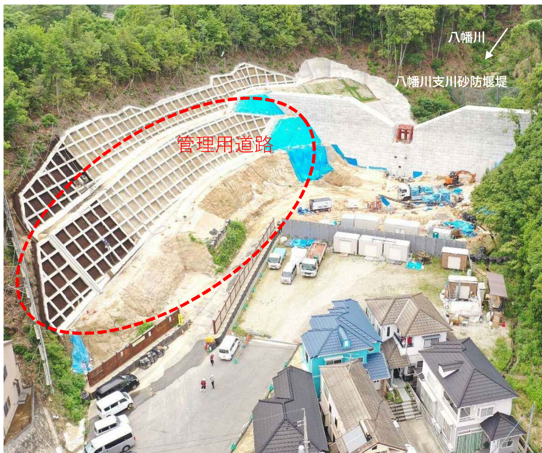
【施工状況（下流側より）】
