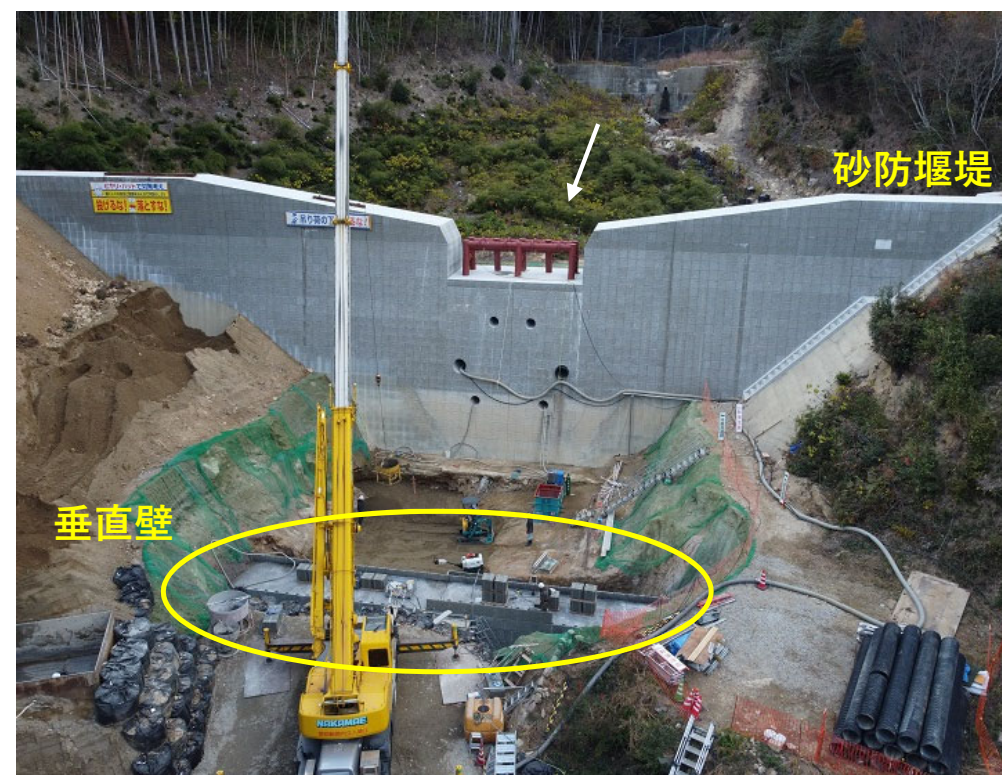
【前庭保護（垂直壁）の施工状況】
