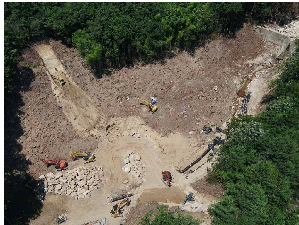
施工状況 (掘削・床堀)
