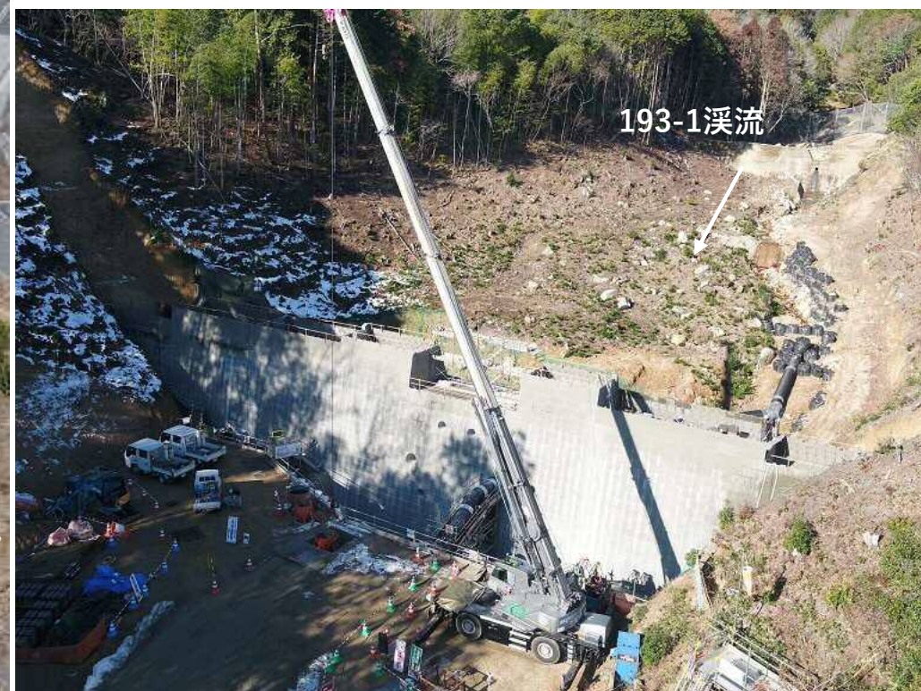
【施工状況 (砂防堰堤)】
