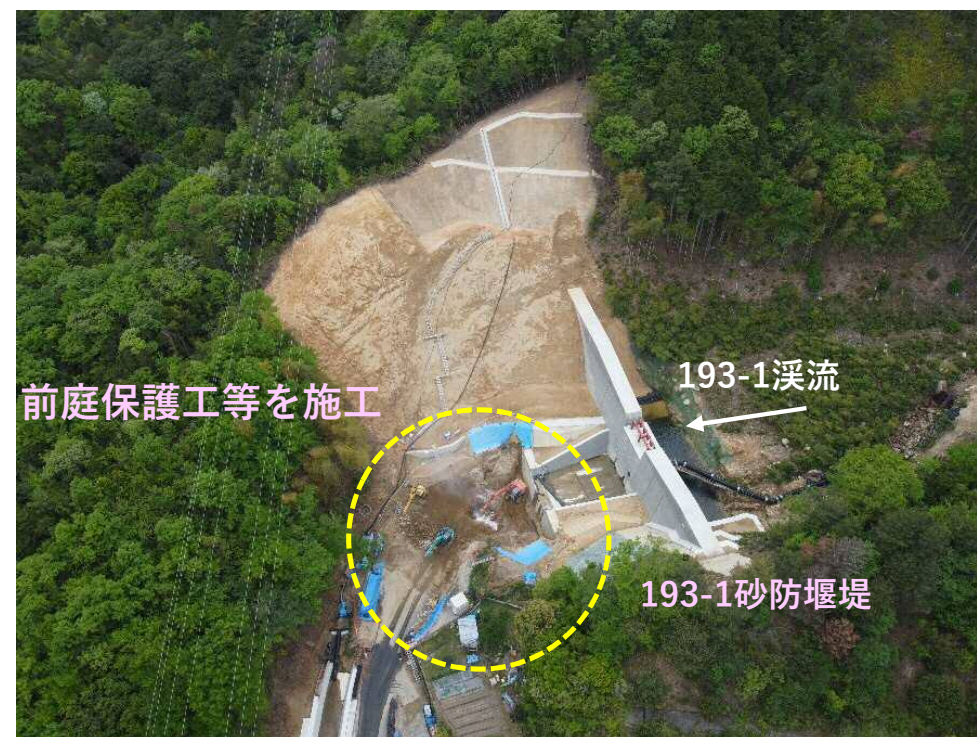
【管理用道路法面掘削の施工状況】
