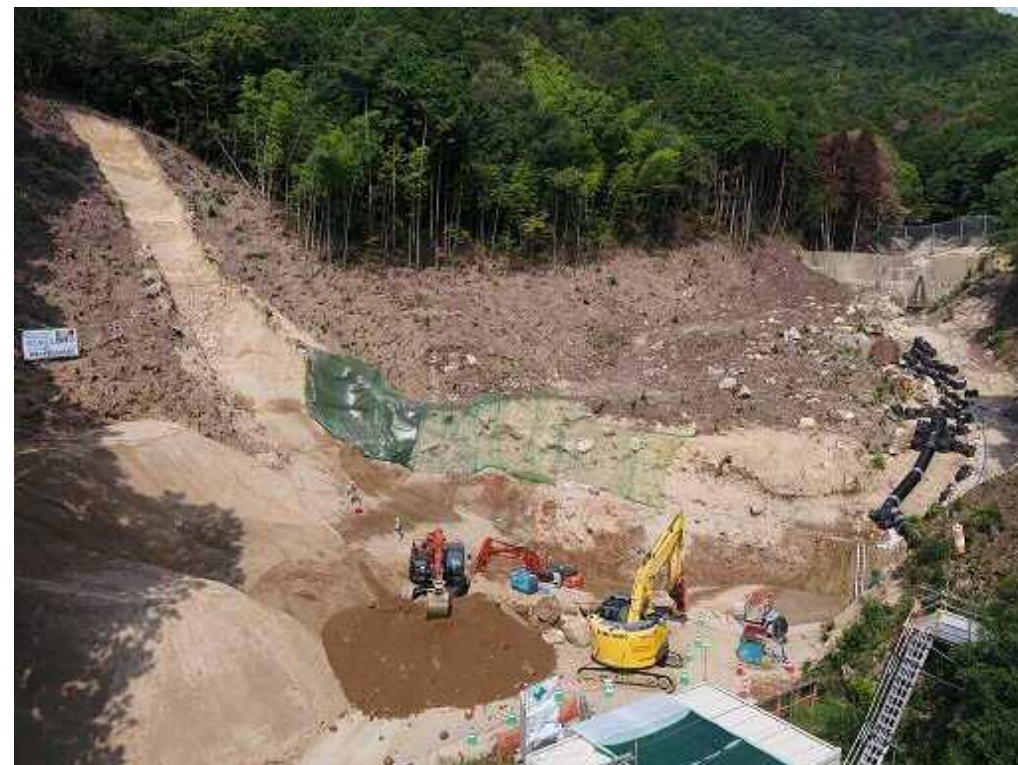
施工状況 (掘削・床堀)
