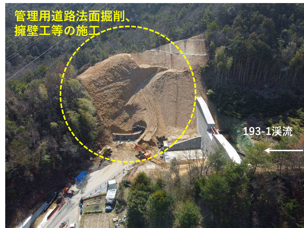
【管理用道路法面掘削の施工状況】
