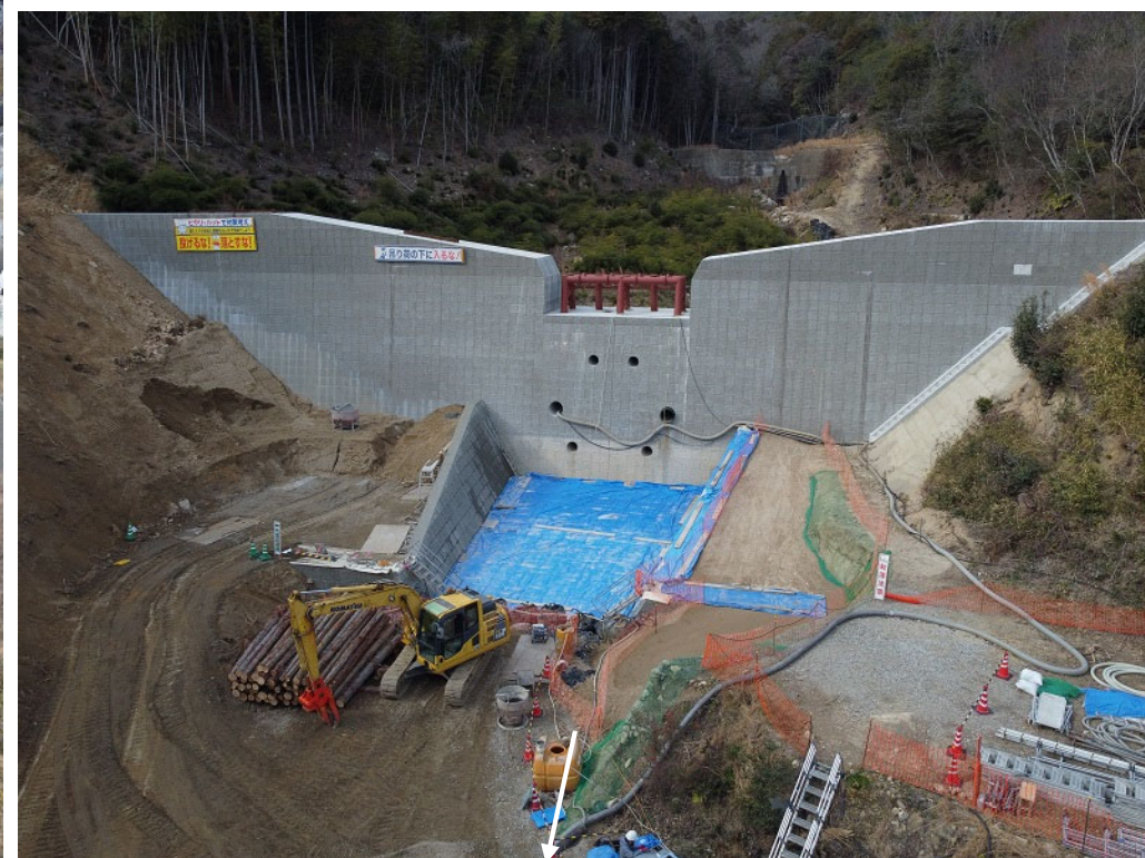
【前庭保護 (側壁・水叩き) の施工状況】
