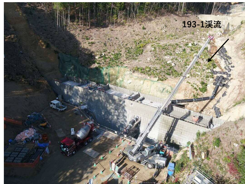
【施工状況 (砂防堰堤)】
