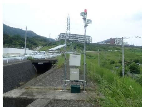
土石流警報装置設置状況
