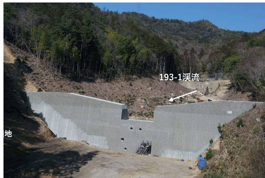
【完成状況(砂防堰堤)】
