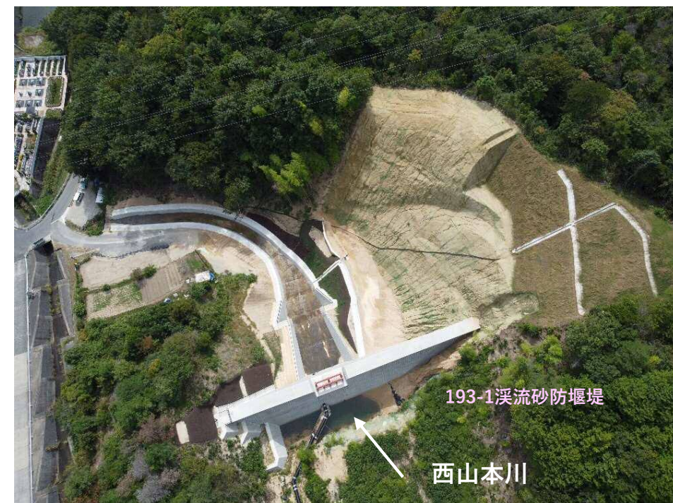
【堰堤上空からの施工状況】
