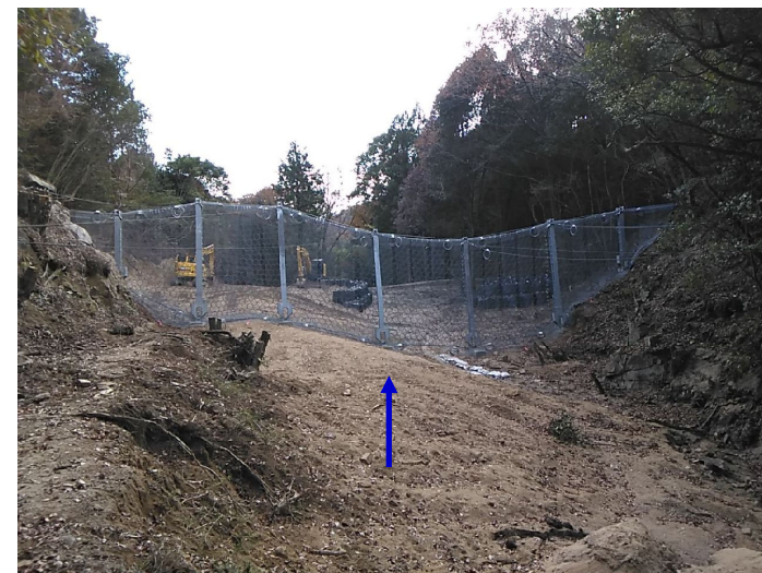
強靱ワイヤーネット設置状況(下流を望む)
