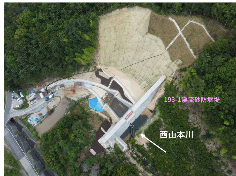
【堰堤上空からの施工状況】
