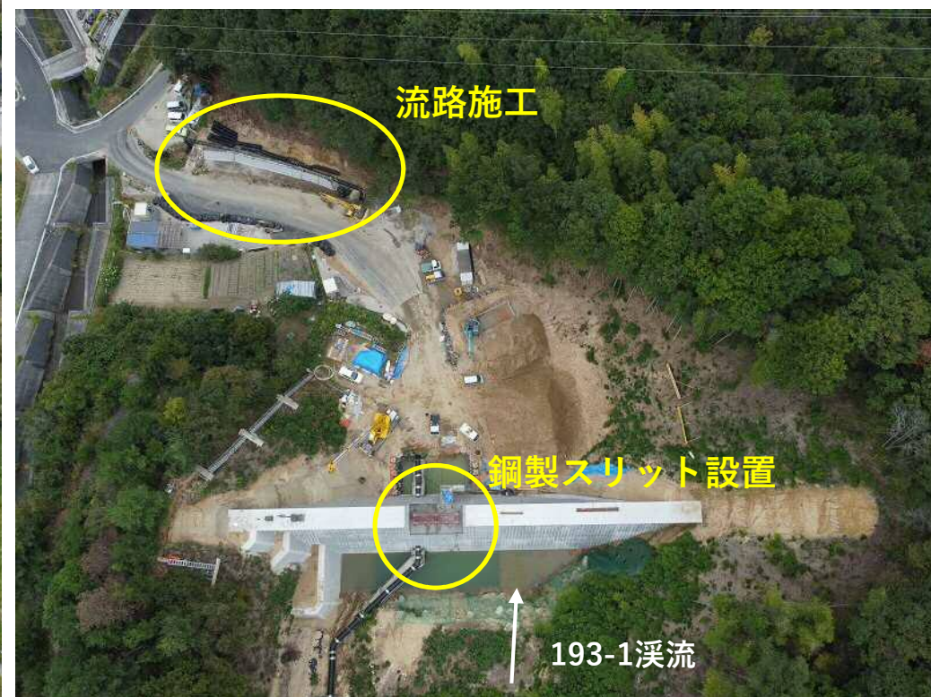
【砂防堰堤及び流路の施工状況】
