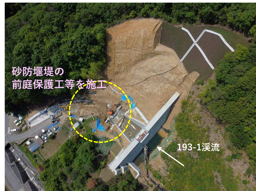
【管理用道路法面掘削の施工状況】
