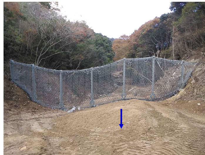
強靱ワイヤーネット設置状況(上流を望む)
