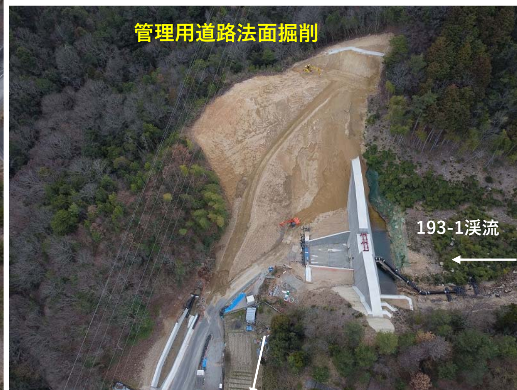
【管理用道路法面掘削の施工状況】
