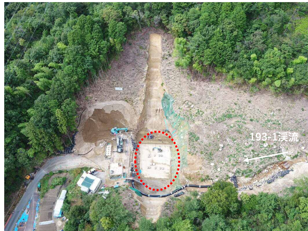
施工状況 (地盤改良工)
