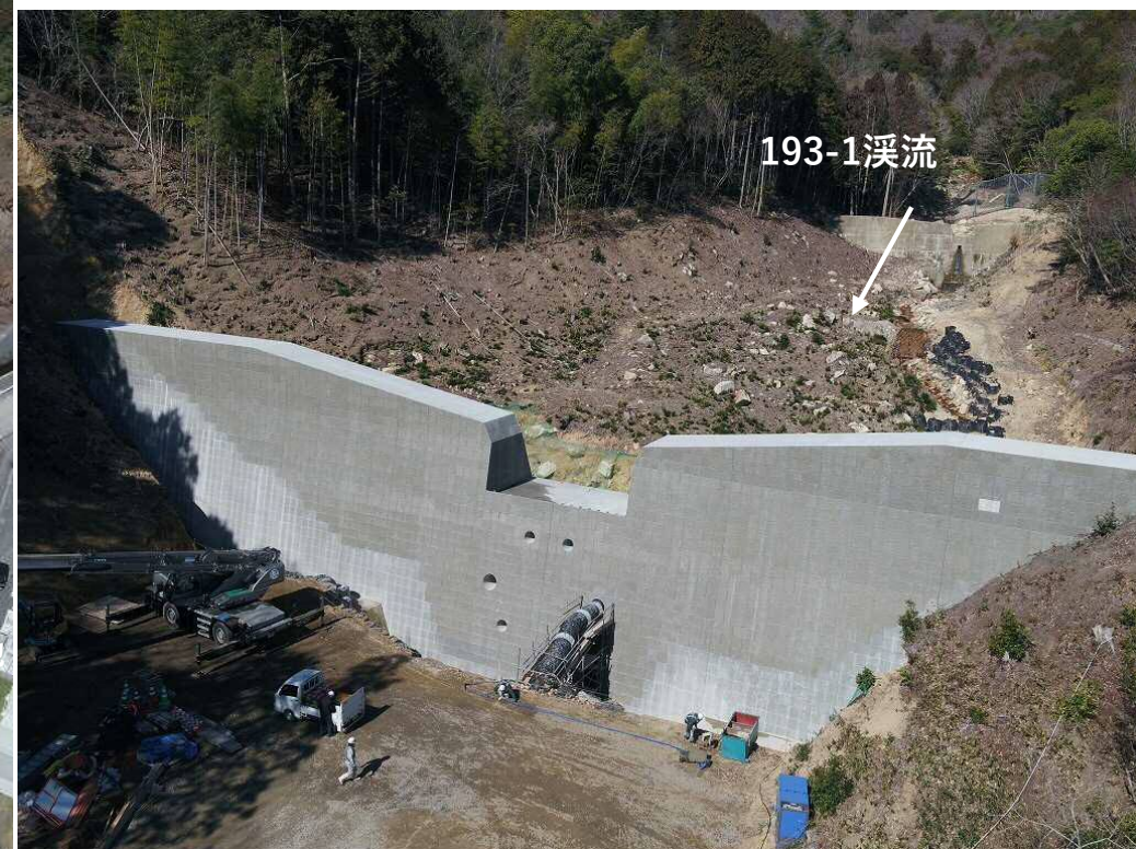
【施工状況 (砂防堰堤)】
