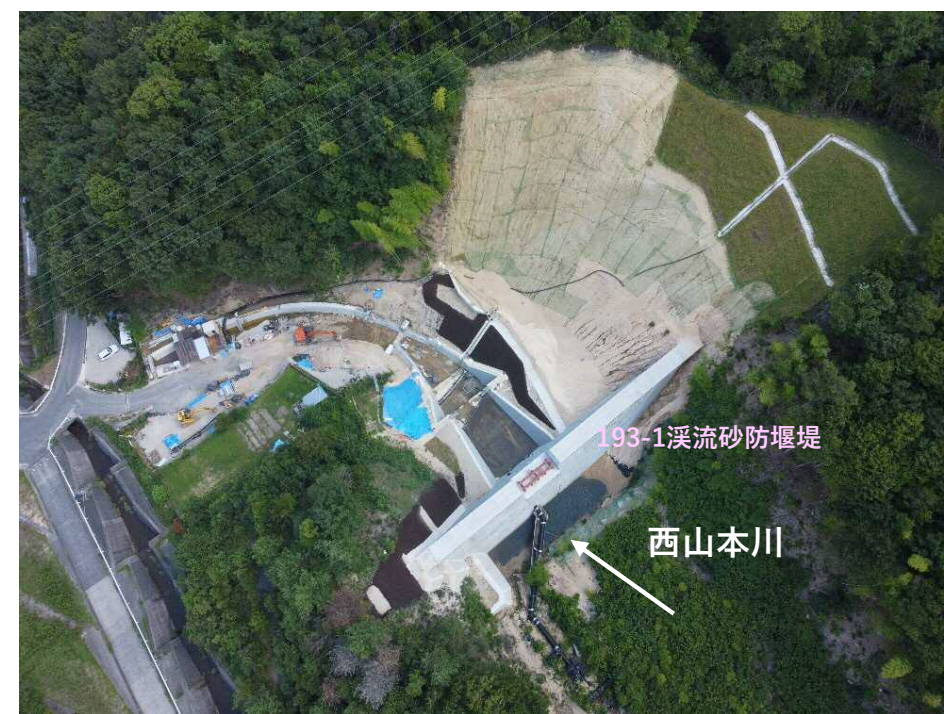
【堰堤上空からの施工状況】
