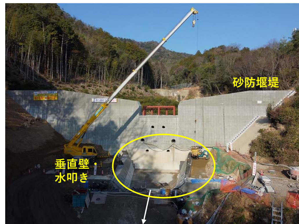
【前庭保護（側壁・水叩き）の施工状況】
