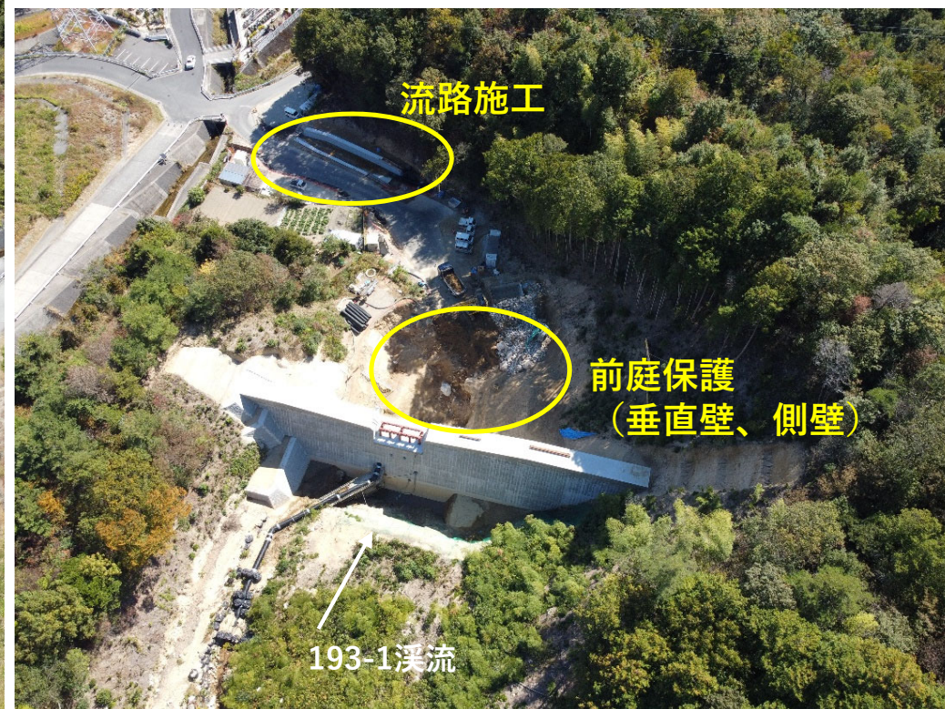
【砂防堰堤及び流路の施工状況】
