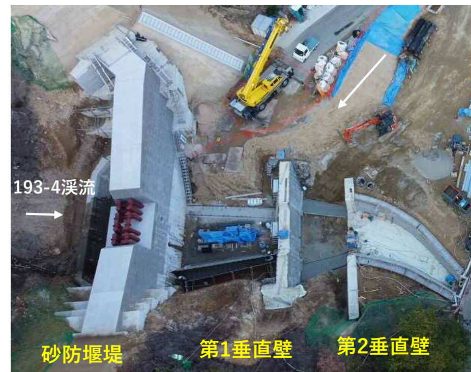
【施工状況（砂防堰堤、第1、2垂直壁）】
