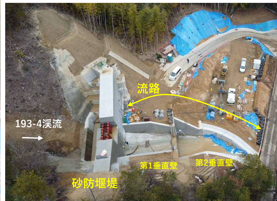
【施工状況（砂防堰堤、第1、2垂直壁）】
