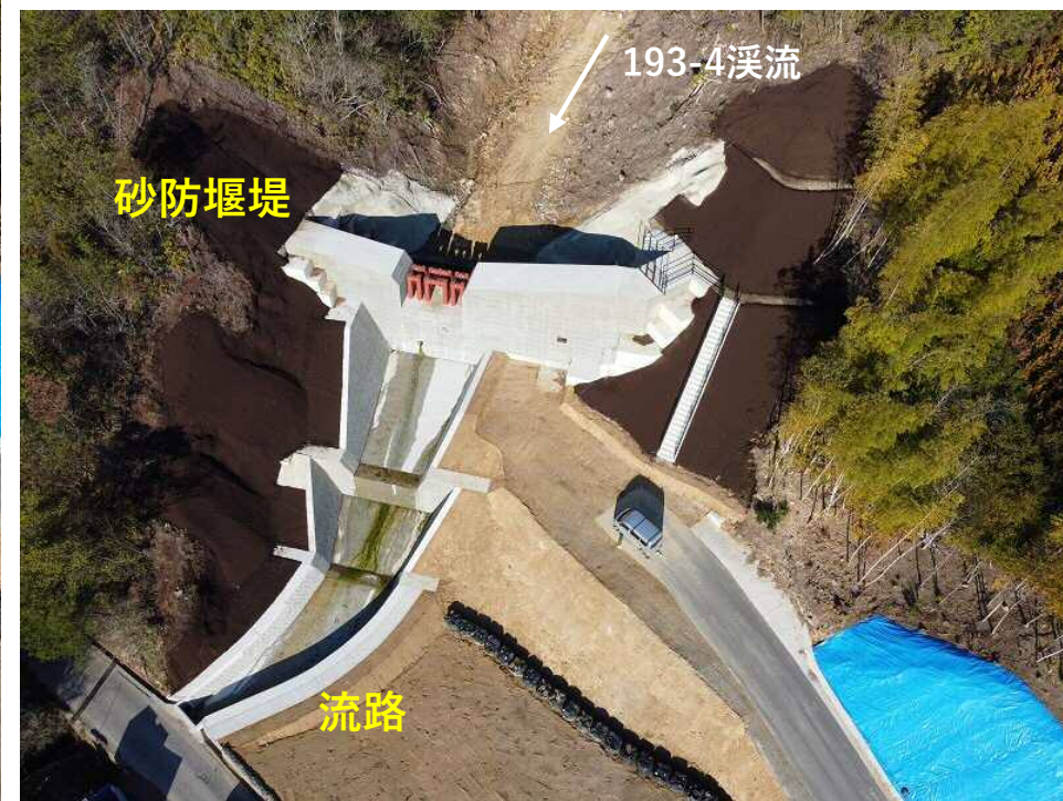
【施工状況(砂防堰堤、流路)】
