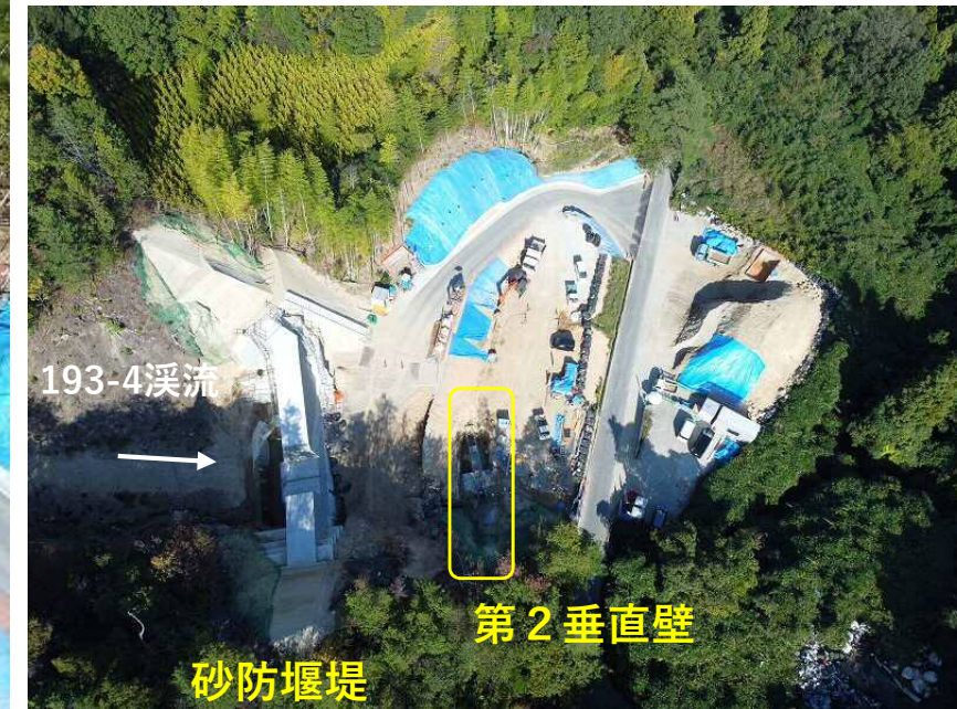
施工状況（砂防堰堤、第2垂直壁）
