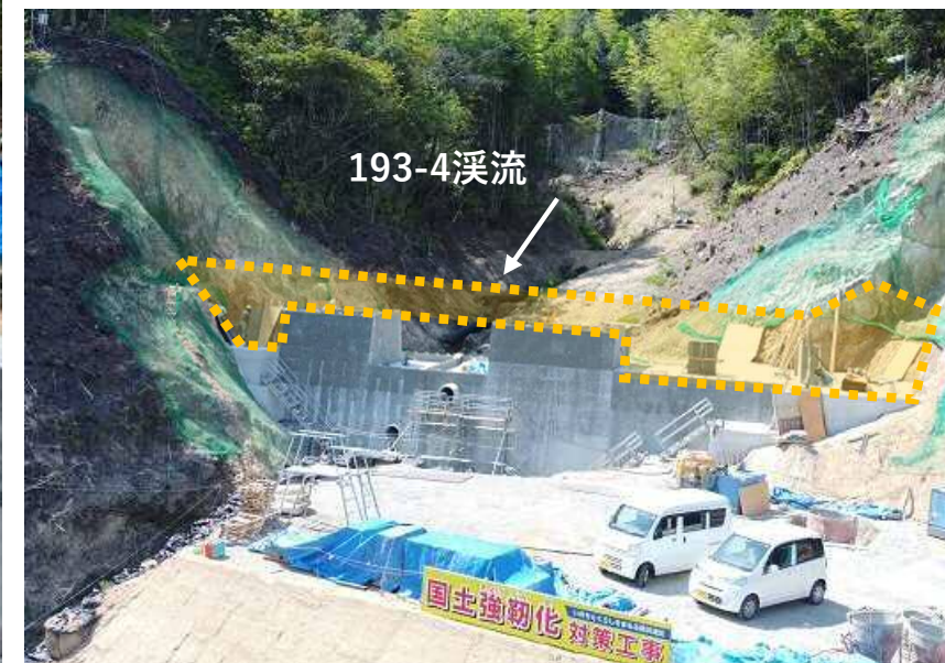
施工状況（砂防堰堤）
