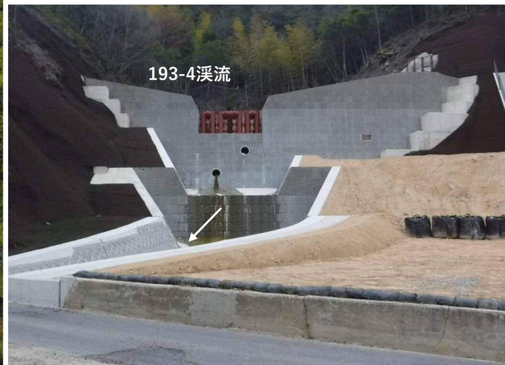
【施工状況(砂防堰堤、流路)】
