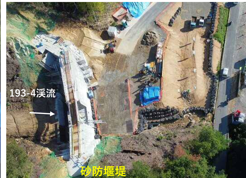
施工状況(砂防堰堤)
