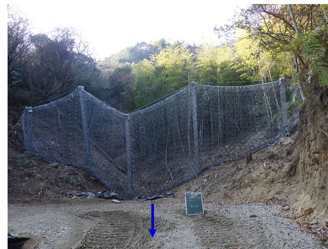
強靱ワイヤーネット設置状況(上流を望む)
