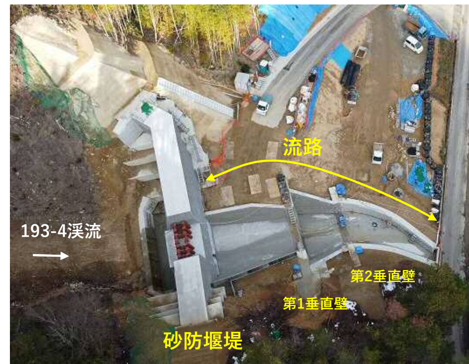
【施工状況（砂防堰堤、第1、2垂直壁）】
