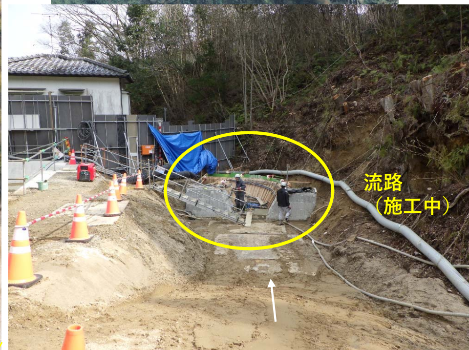
【施工状況 (床固・流路護岸)】
