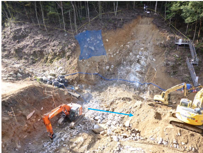
砂防堰堤（中心付近） 掘削状況
