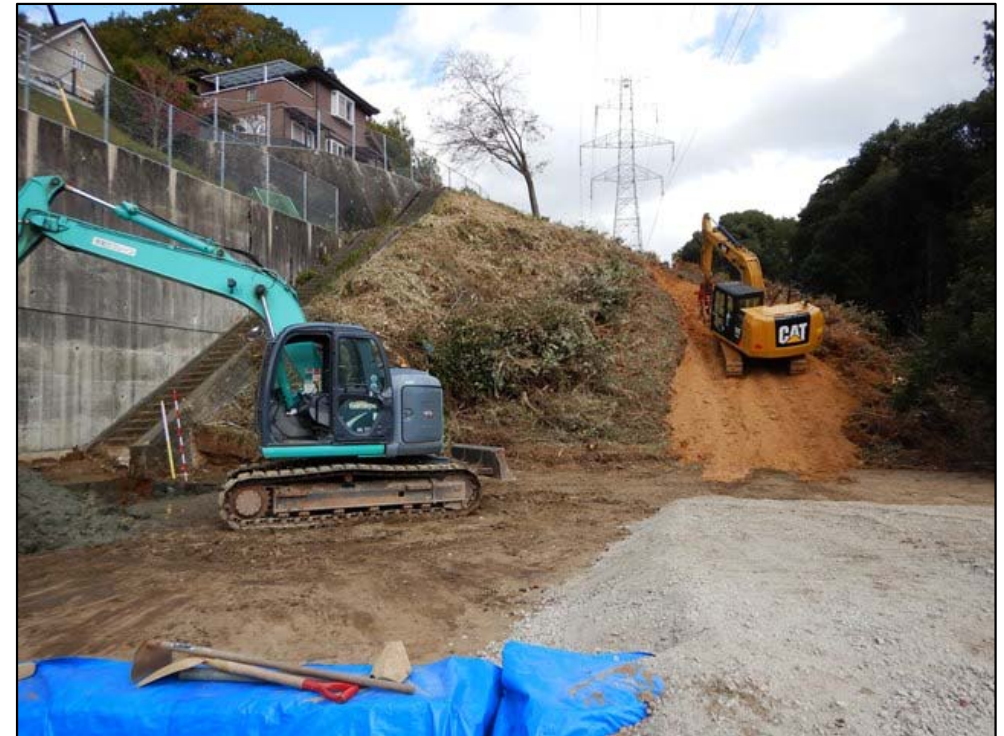
進入路施工状況
