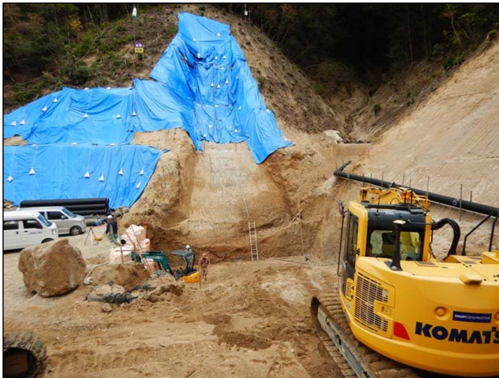
砂防堰堤の右岸掘削状況
