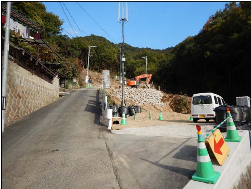
施工状況①
