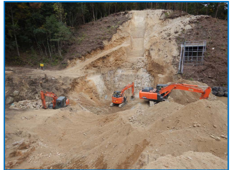
本体掘削の状況
