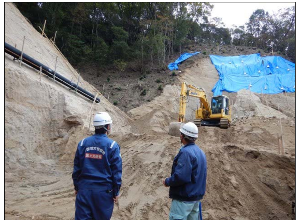
砂防堰堤の左岸掘削状況
