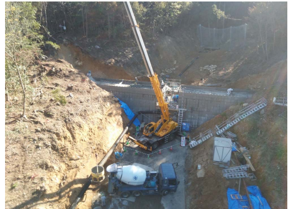
コンクリート打設状況
