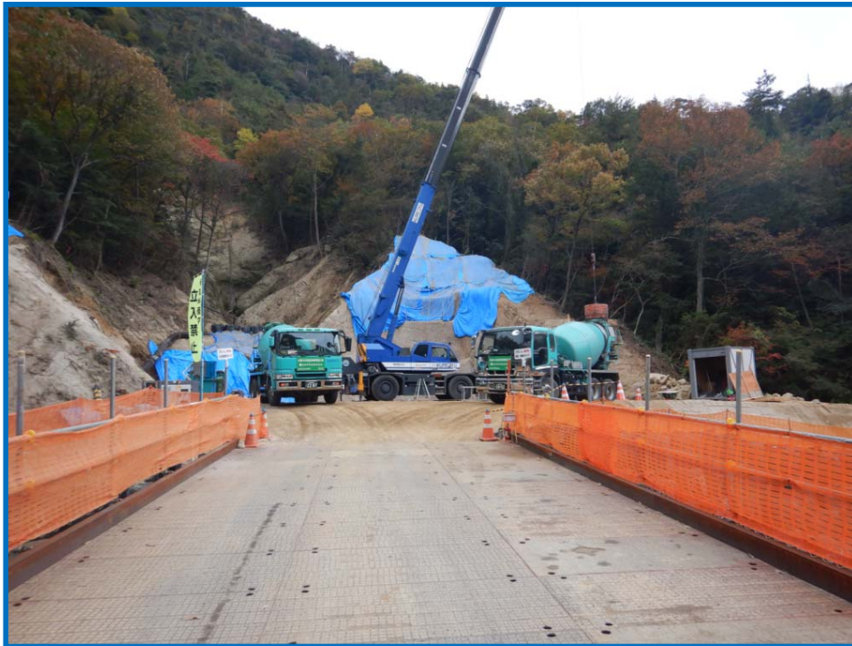
本体コンクリート打設状況
