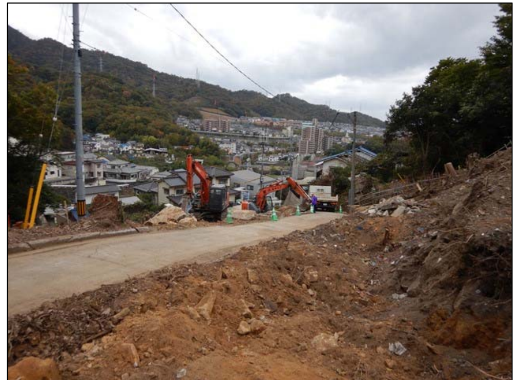
施工状況②
