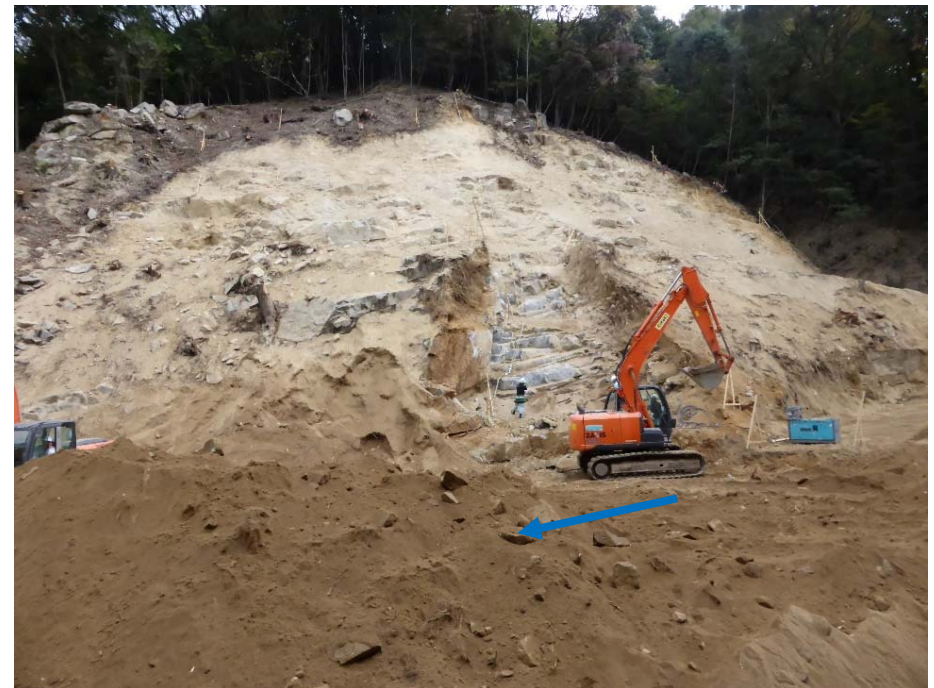
右岸側掘削状況
