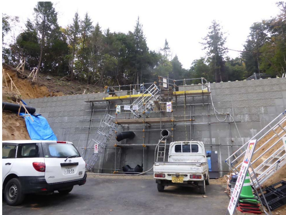
型枠設置状況(11月18日)
