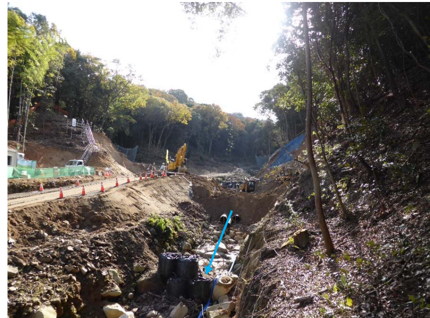
砂防堰堤施工状況（全景）
