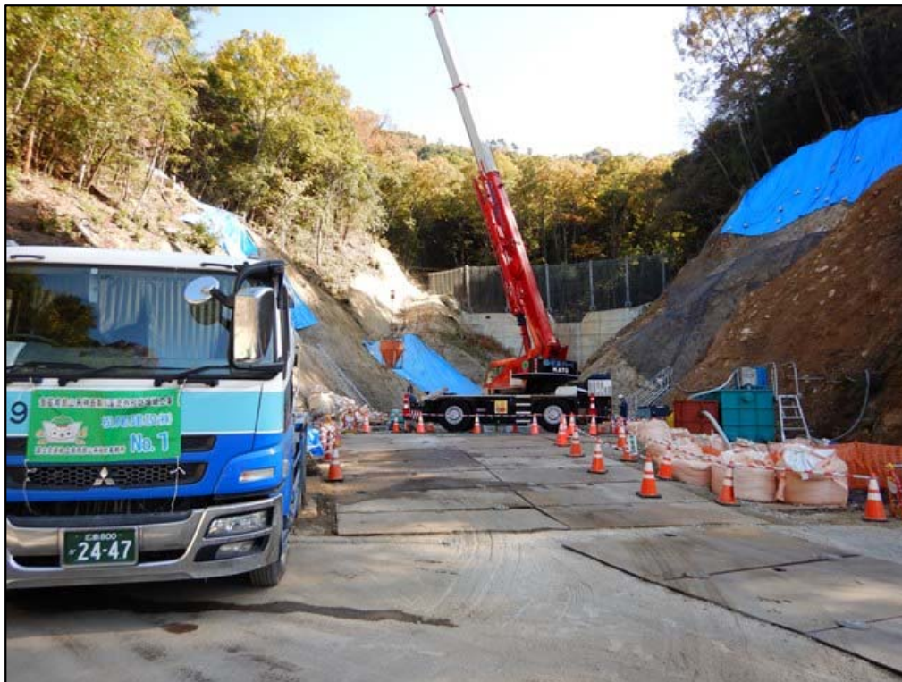
コンクリート打設状況①
