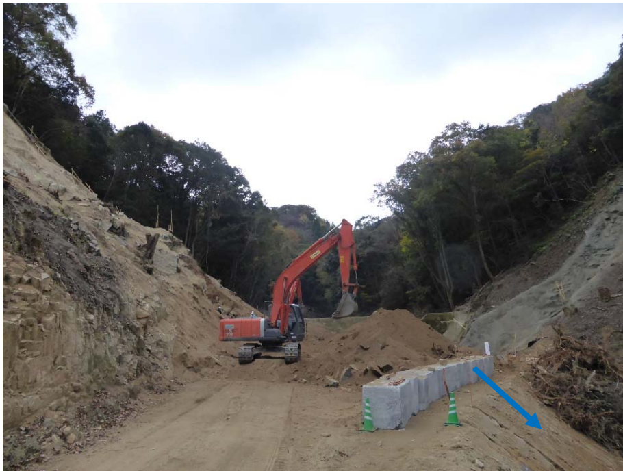
砂防堰堤施工状況 (全景)
