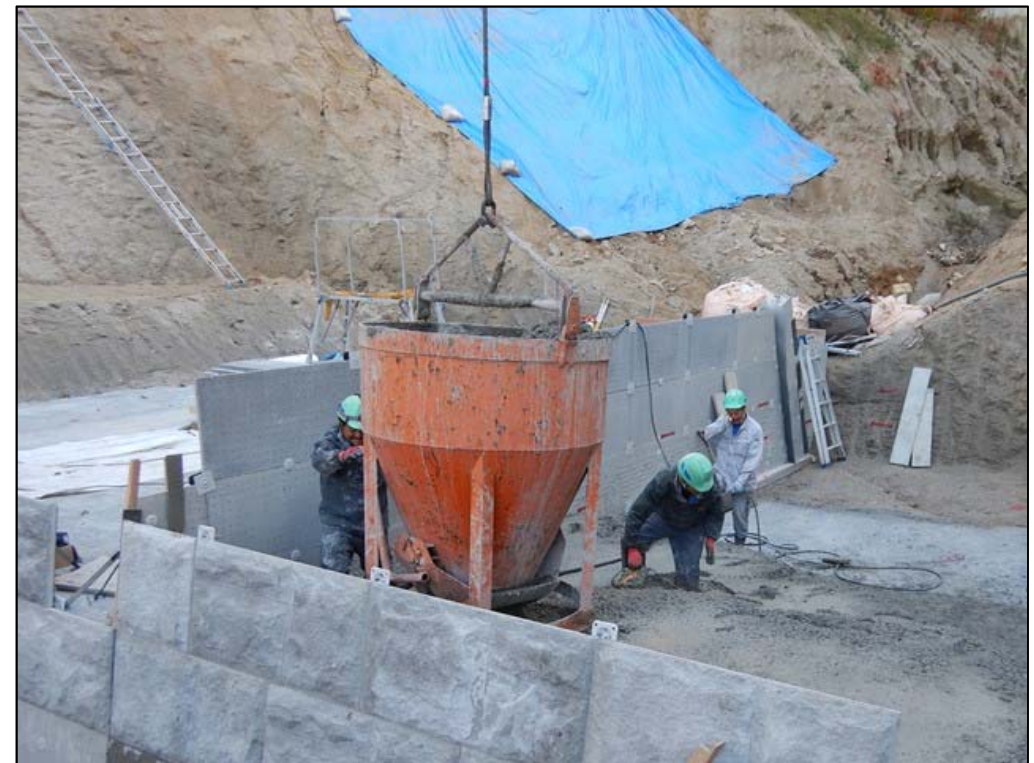
コンクリート打設状況②
