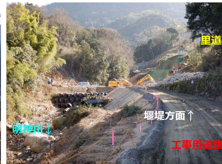
工事用道路（堰堤下流）
