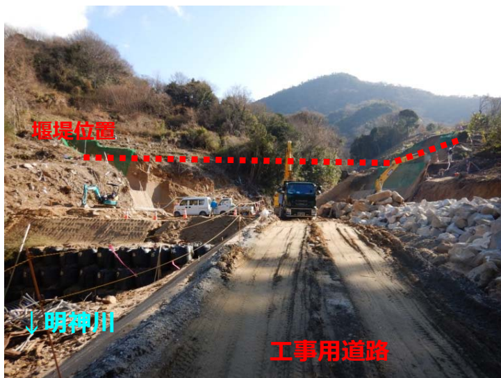
堰堤掘削状況(下流より)
