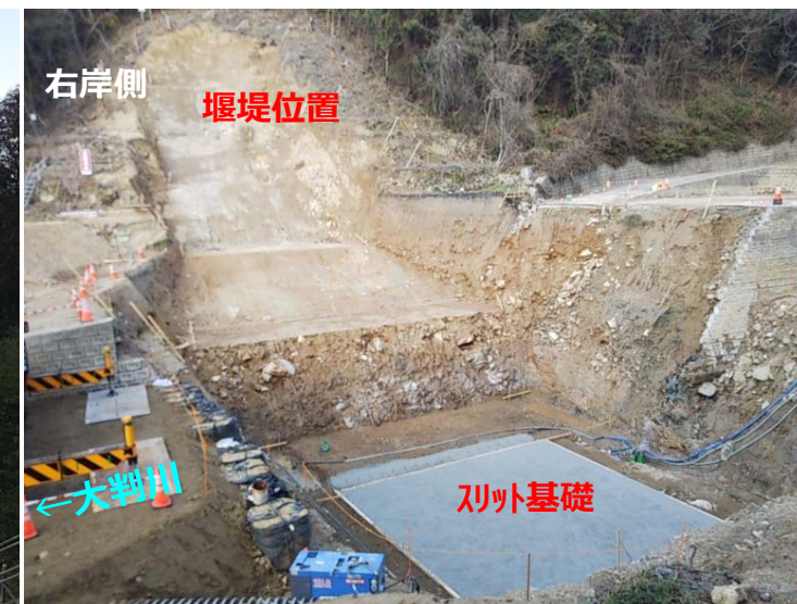
大判川掘削状況（右岸側）
