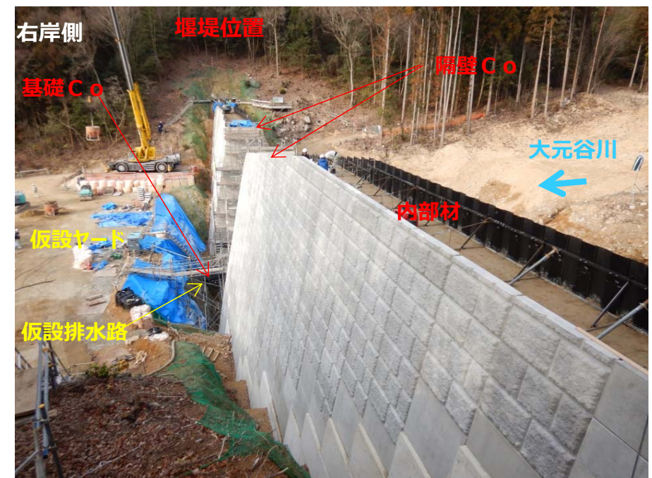
堰堤コンクリート施工②
