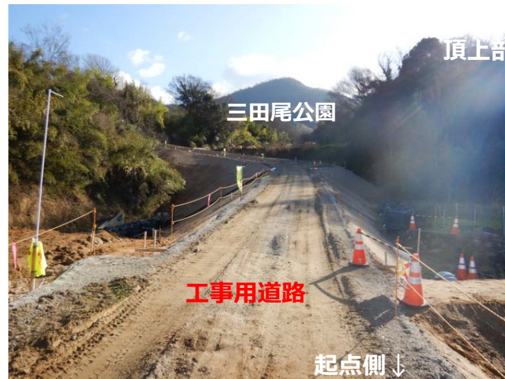
工事用道路（三田尾公園手前）
