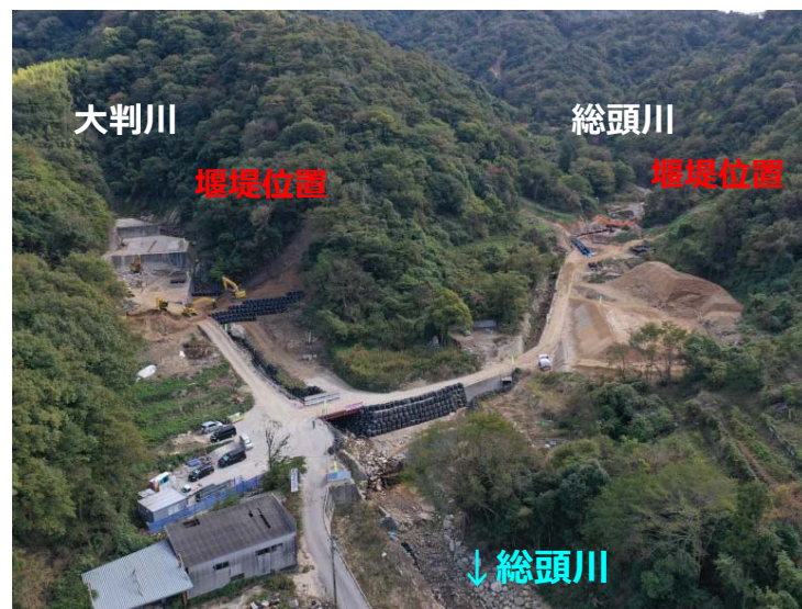
総頭川掘削状況（下流より）
