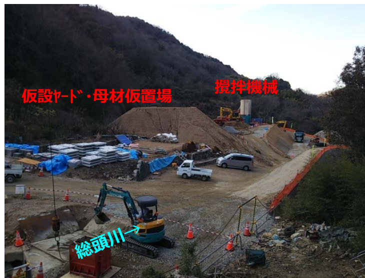
総頭川仮設ヤード施工状況
