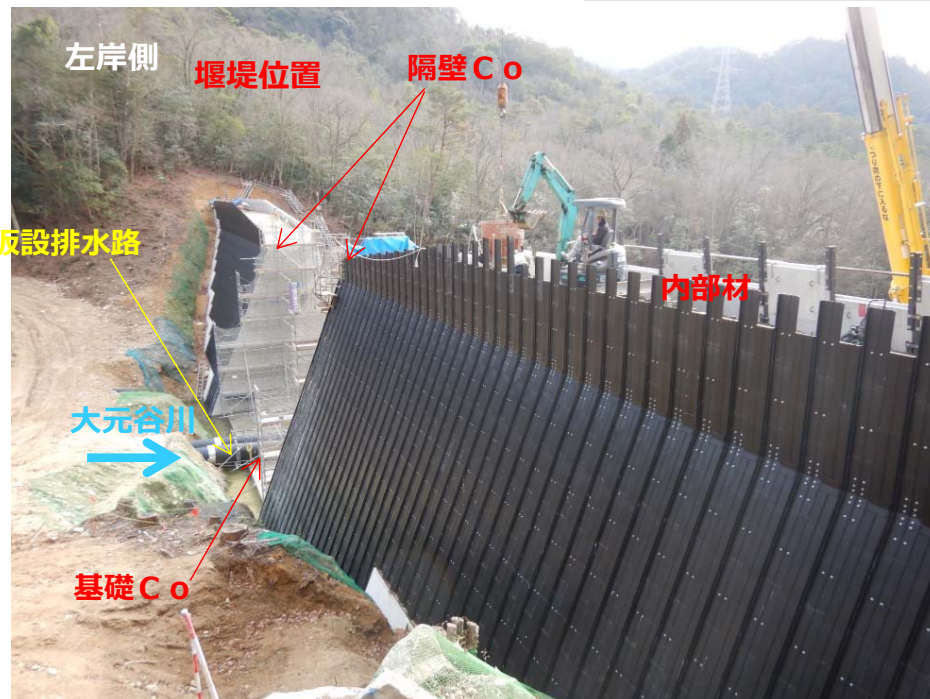
堰堤コンクリート施工①
