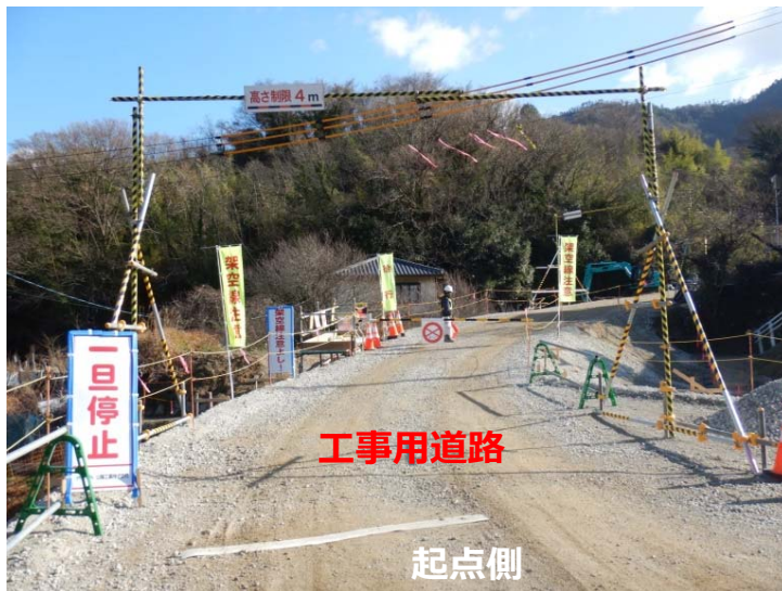
工事用道路起点部
