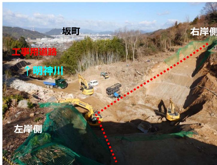
堰堤左岸掘削状況
