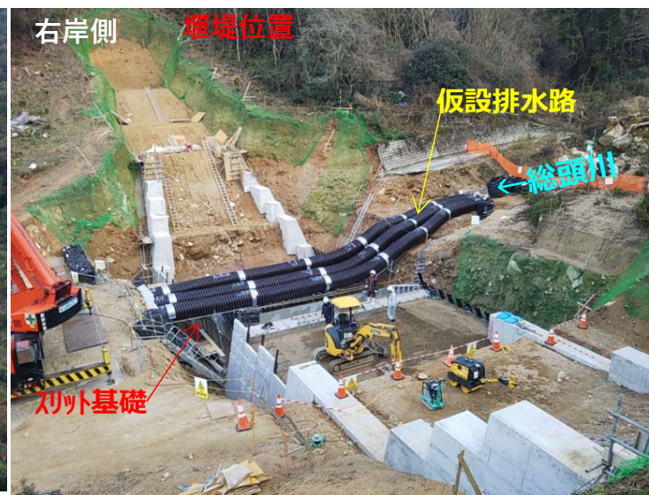
総頭川打設状況（右岸側）
