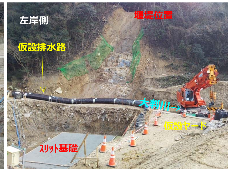
大判川掘削状況（左岸側）
