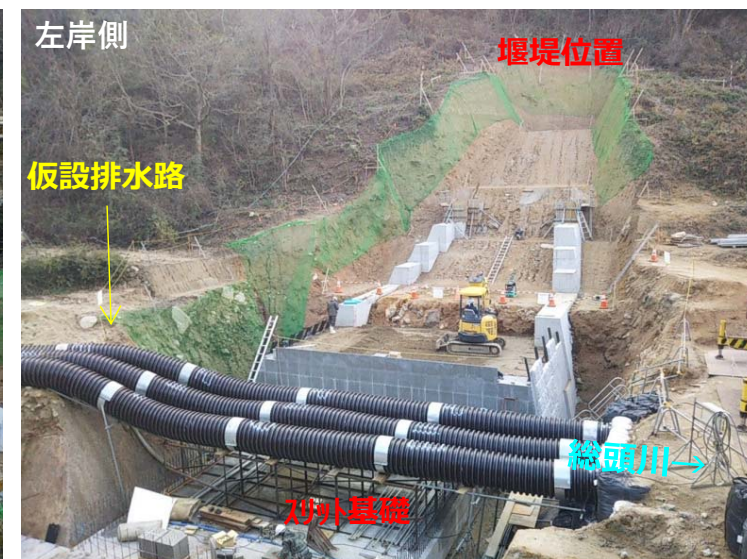
総頭川打設状況（左岸側）
