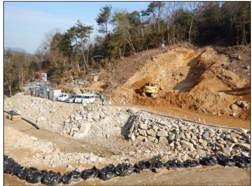
施工状況②
