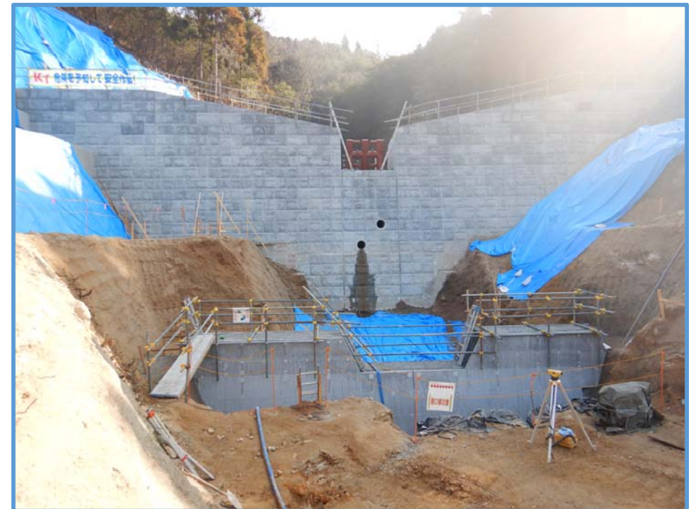
前庭保護工の整備状況
