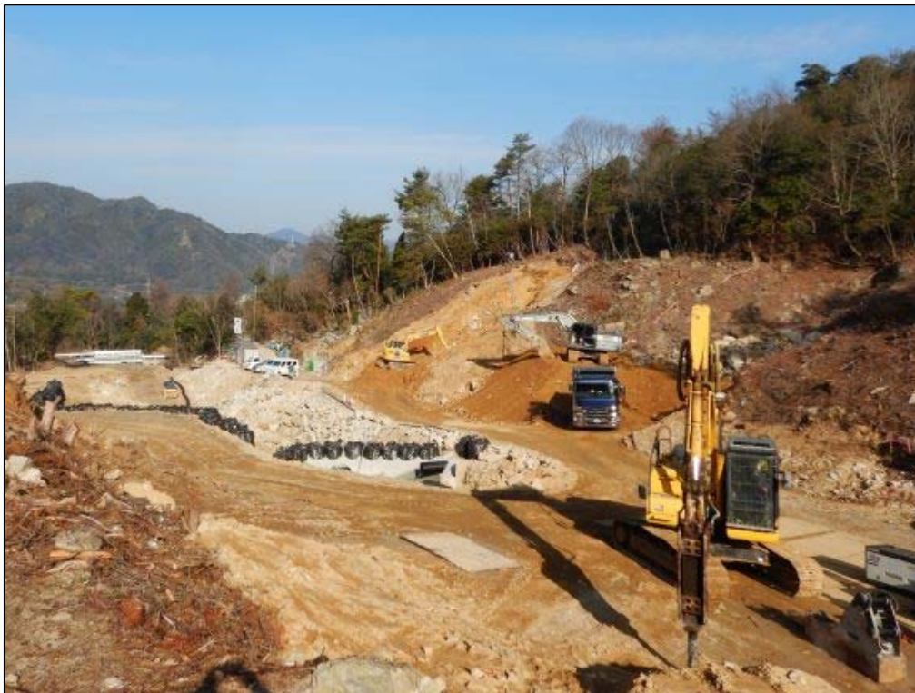
施工状況①
