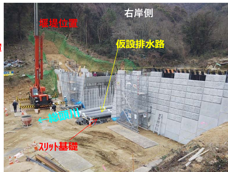
総頭川打設状況（右岸側）
