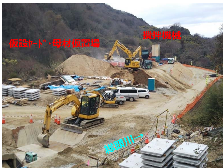
総頭川仮設ヤード施工状況
