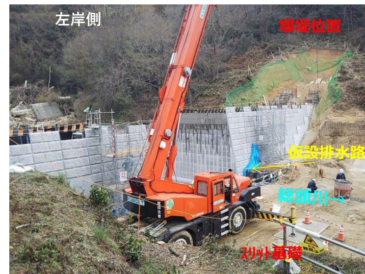
総頭川打設状況（左岸側）
