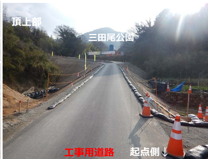
工事用道路（三田尾公園手前）
