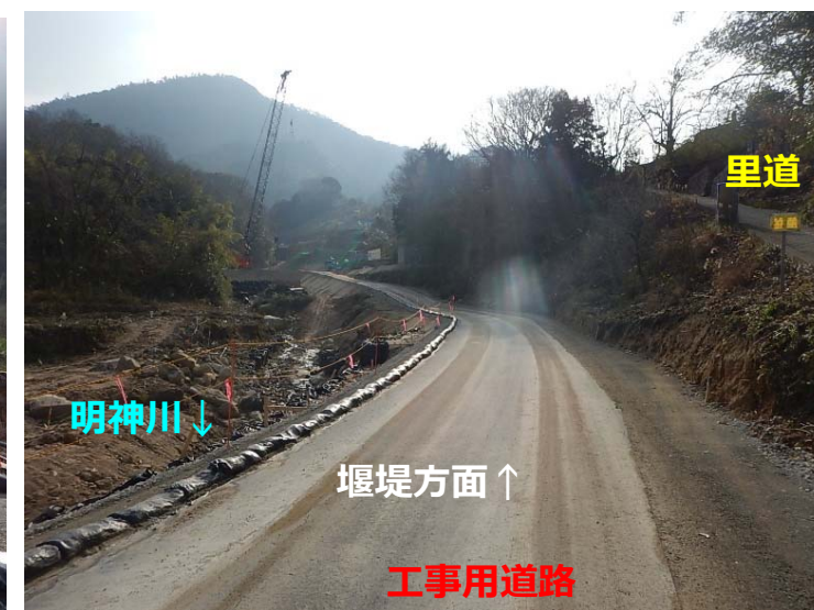
工事用道路（堰堤下流）
