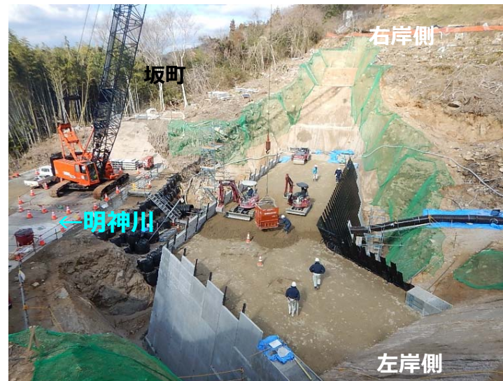
堰堤打設状況(左岸側より)
