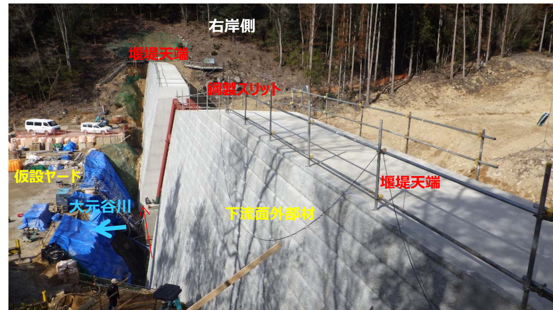
堰堤施工状況(下流側より)
