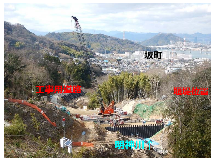
堰堤打設状況(上流より)
