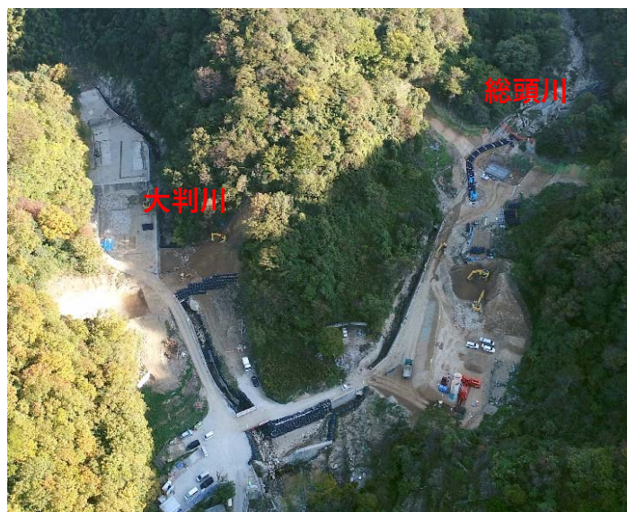
総頭川掘削状況（下流より）
