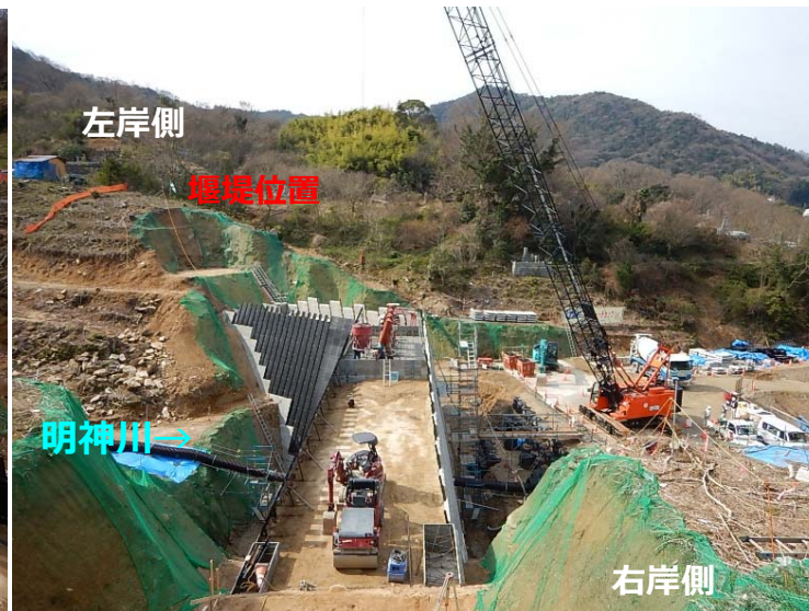
堰堤施工状況(右岸側より)
