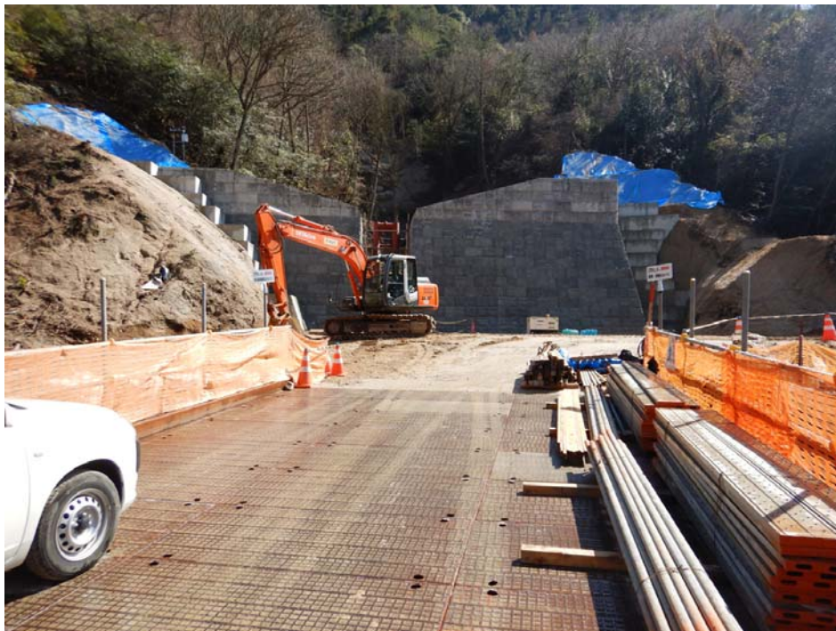
スリット（鋼製杵）設置状況
