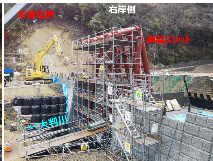
大判川施工状況（右岸側）
