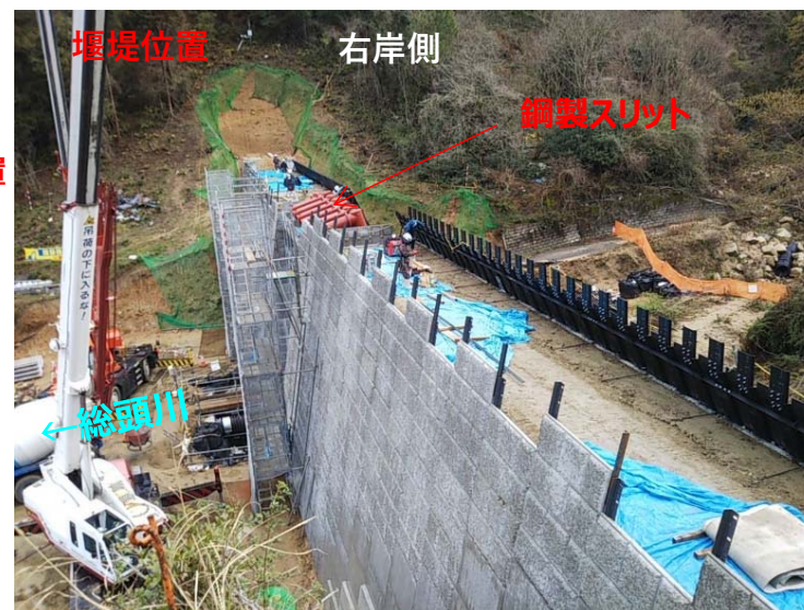
総頭川施工状況（右岸側）
