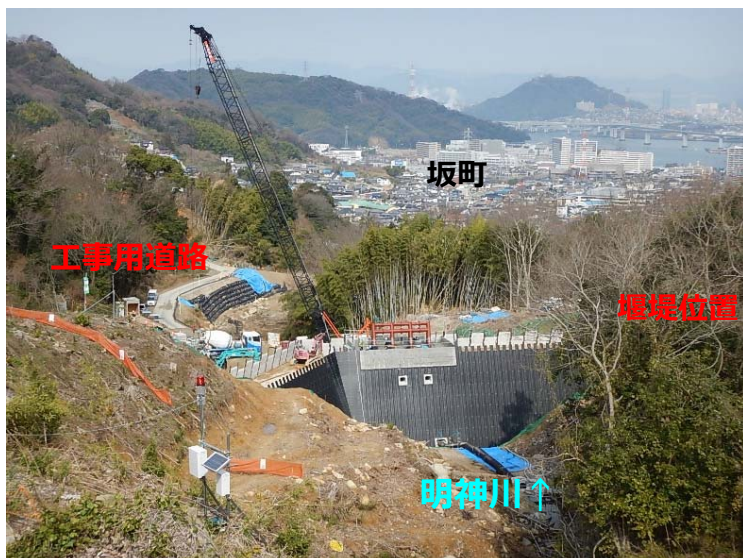
堰堤施工状況(上流より)
