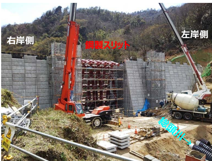
総頭川施工状況（下流側より）
