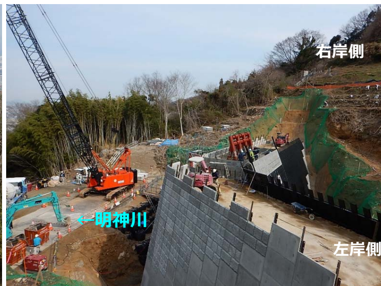
堰堤施工状況(左岸側より)
