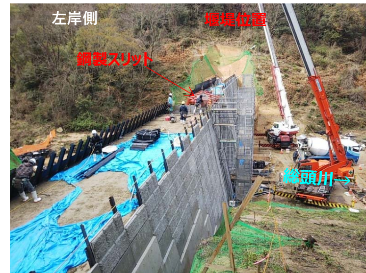
総頭川施工状況（左岸側）
