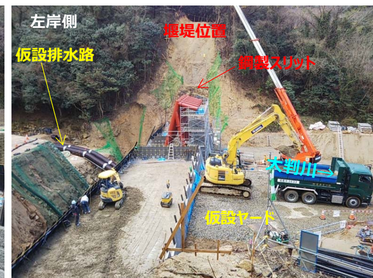
大判川施工状況（左岸側）
