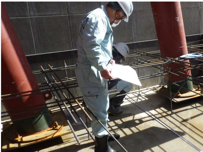
コンクリート打設前確認
