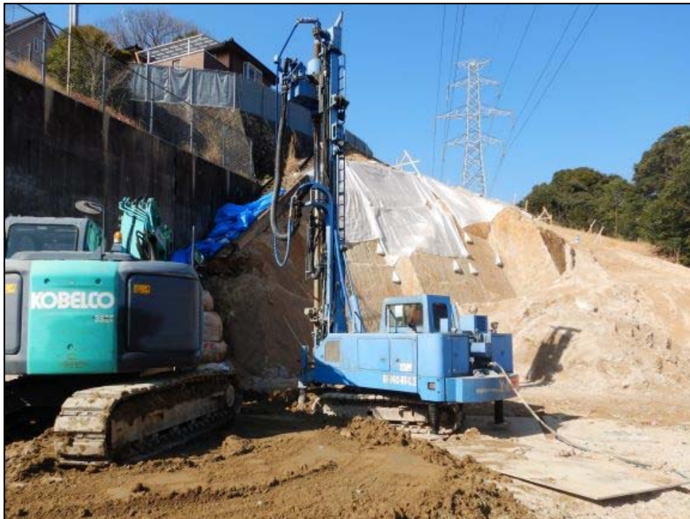
地盤改良施工状況①
