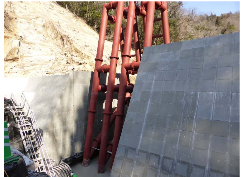
コンクリート打設完了
