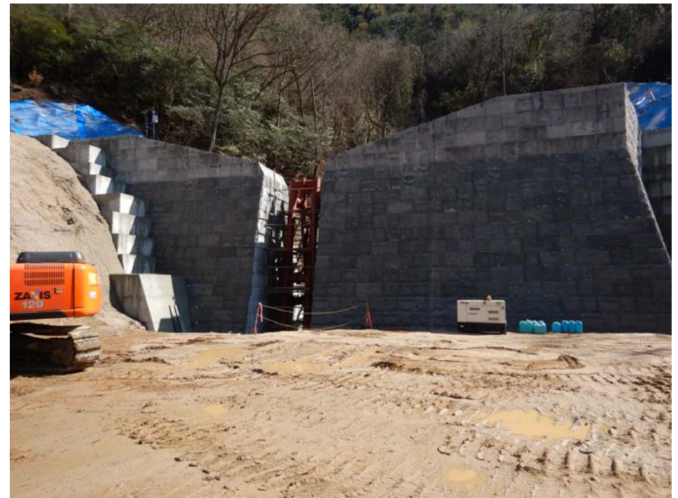
スリット（鋼製杵）設置状況
