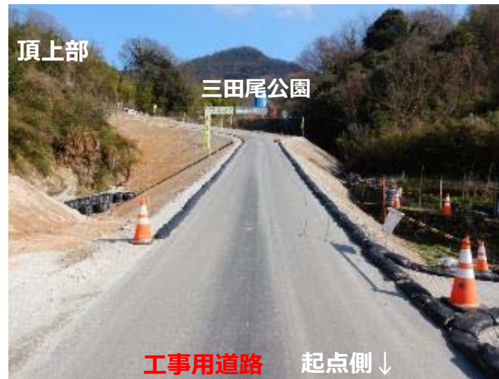
工事用道路（三田尾公園手前）
