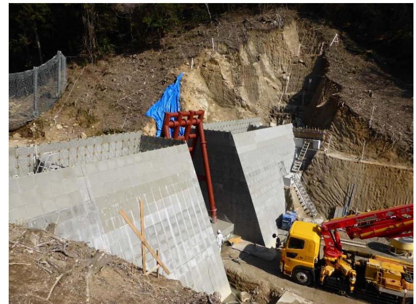
コンクリート打設完了
