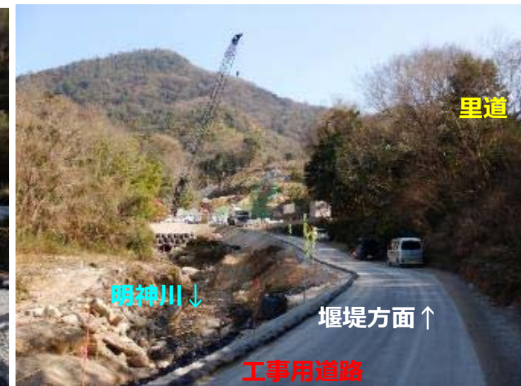
工事用道路（堰堤下流）
