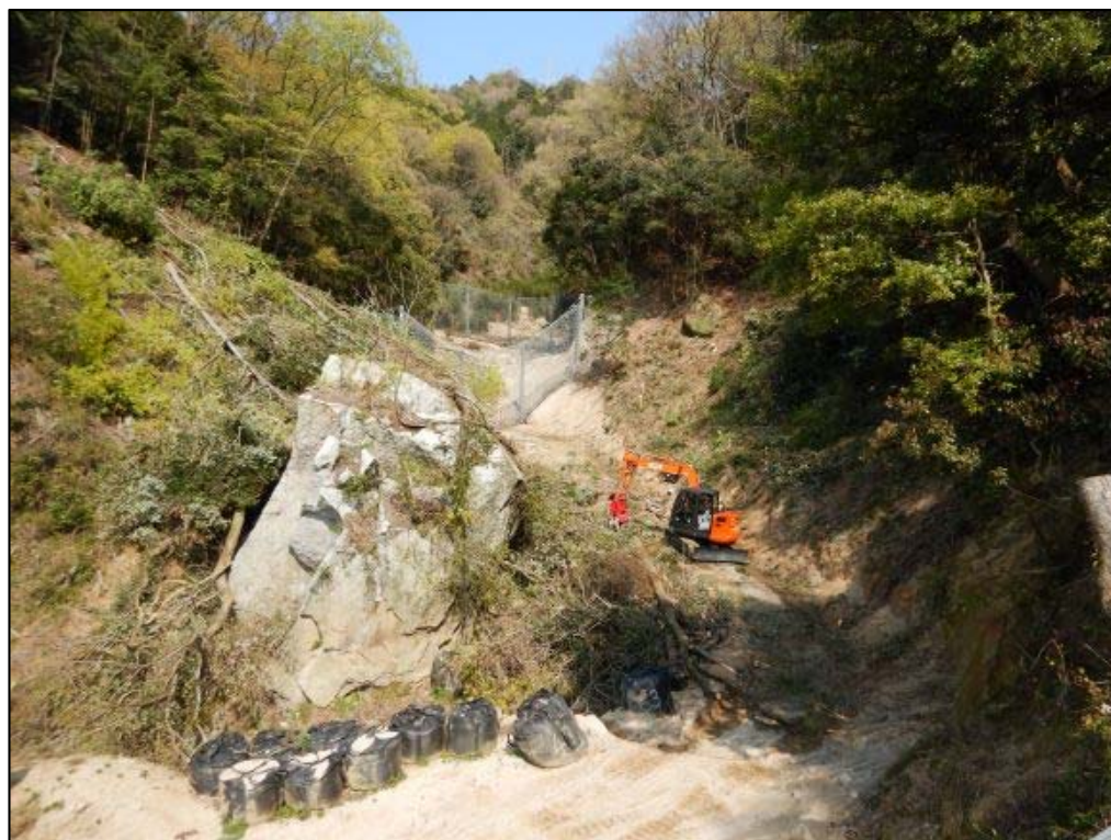
伐採作業状況①
