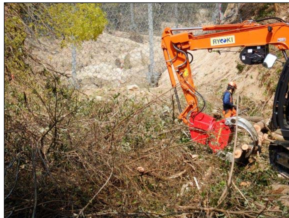
伐採作業状況②
