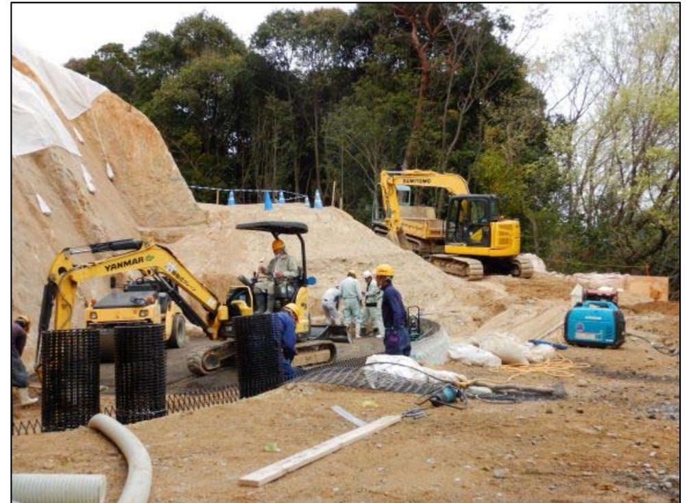
施工状況②
