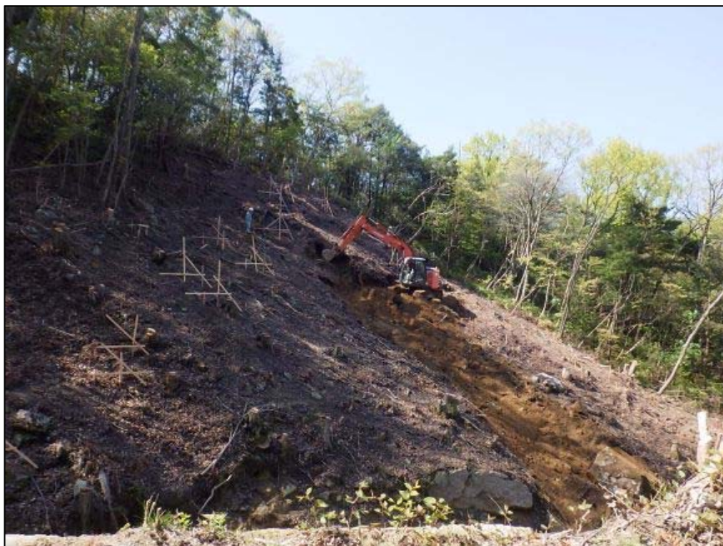
掘削作業状況
