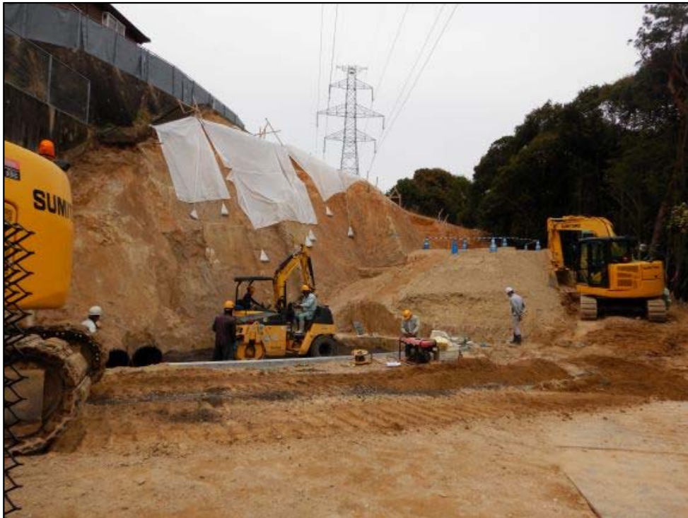
施工状況①
