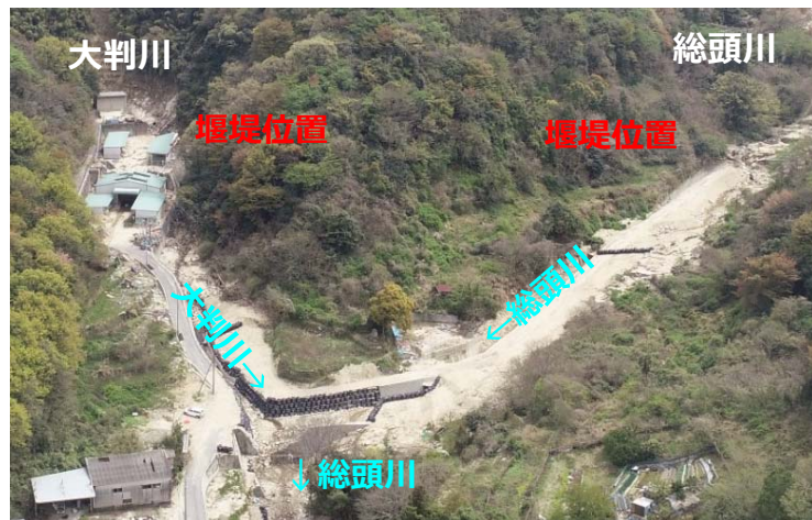
総頭川・大判川施工状況 (着手前H31.4時点)
