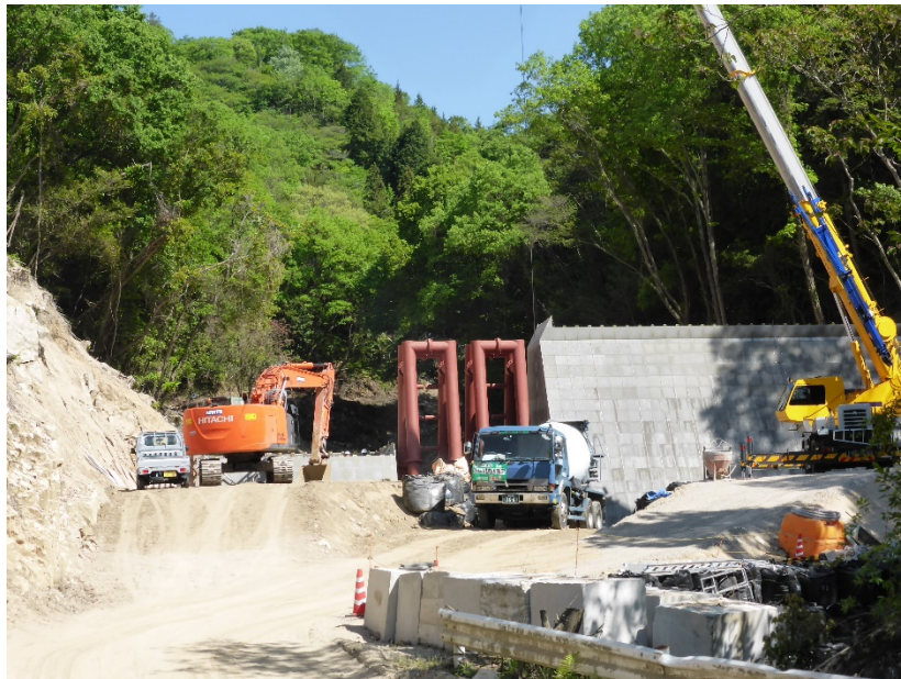
コンクリート打設状況
