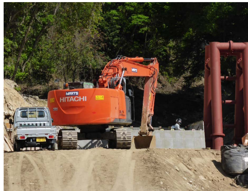
型枠設置状況
