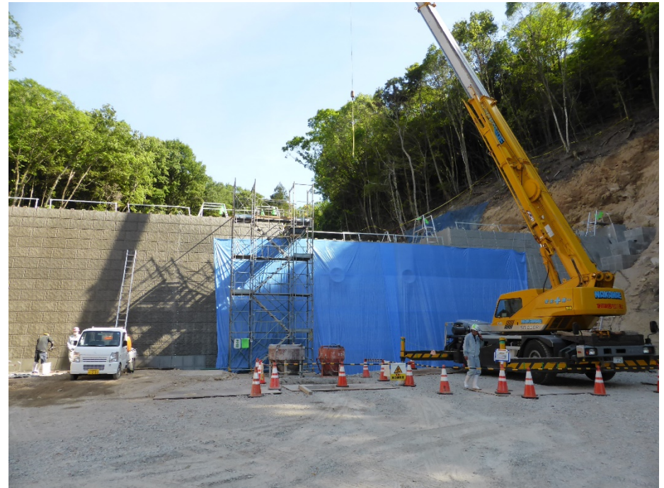
下流側より(全景)
