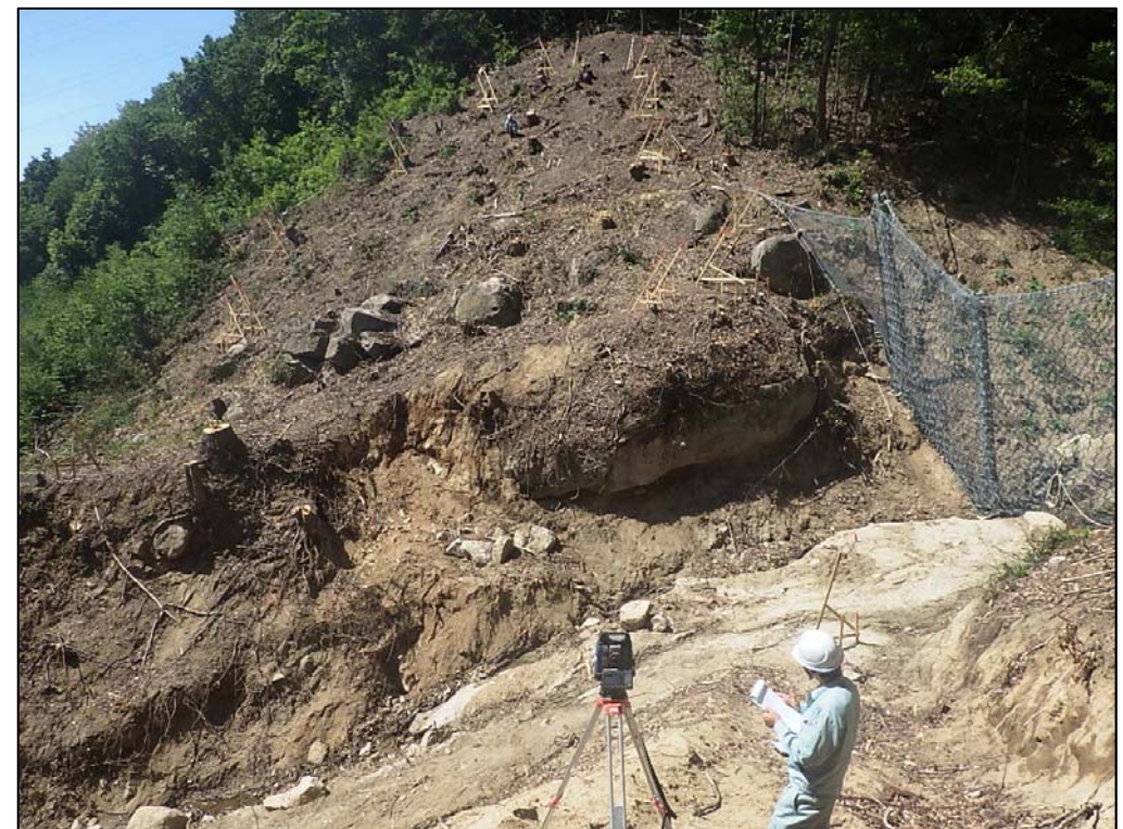
施工状況②
