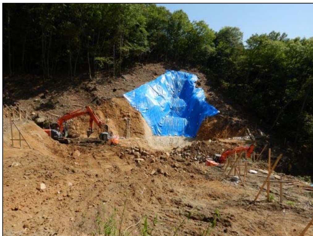
掘削作業状況
