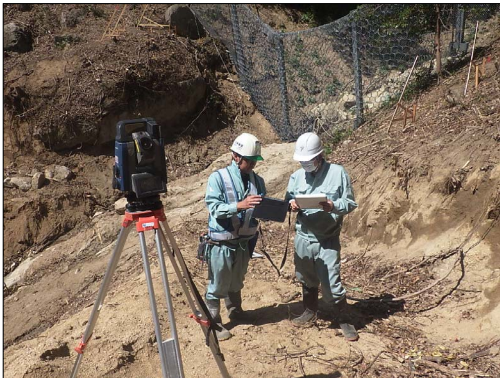
施工状況①
