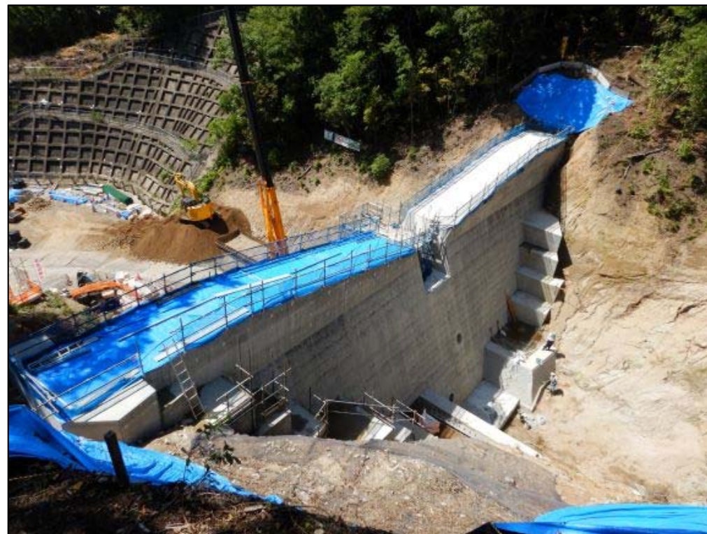
左岸上流側より
