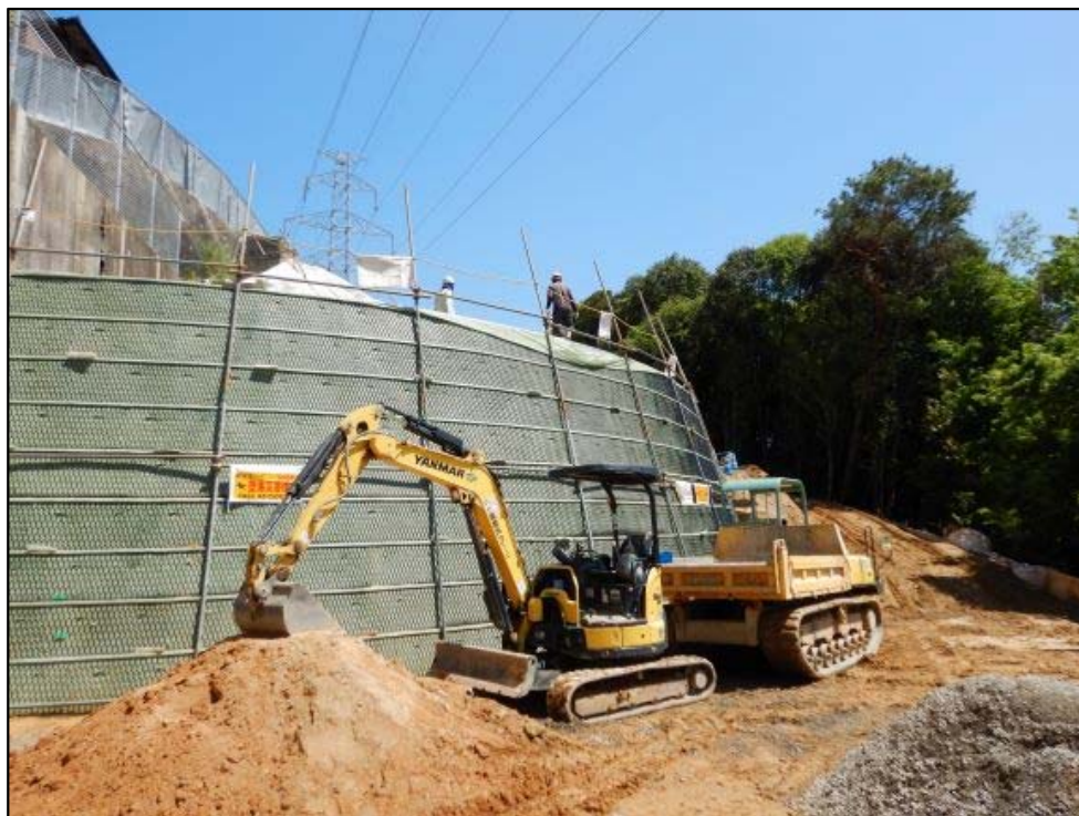
施工状況①
