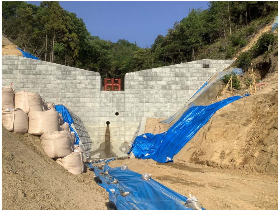
砂防堰堤の埋戻し施工状況
