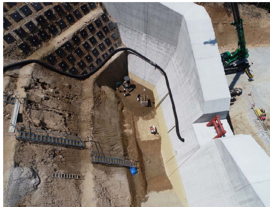
砂防堰堤の埋戻し施工状況
