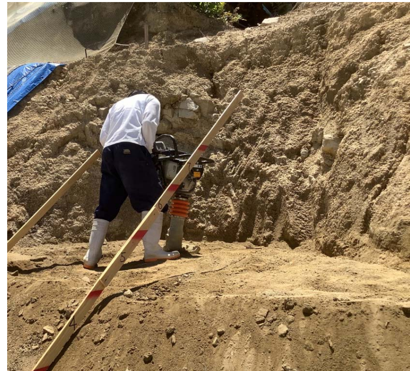
砂防堰堤の埋戻し施工状況
