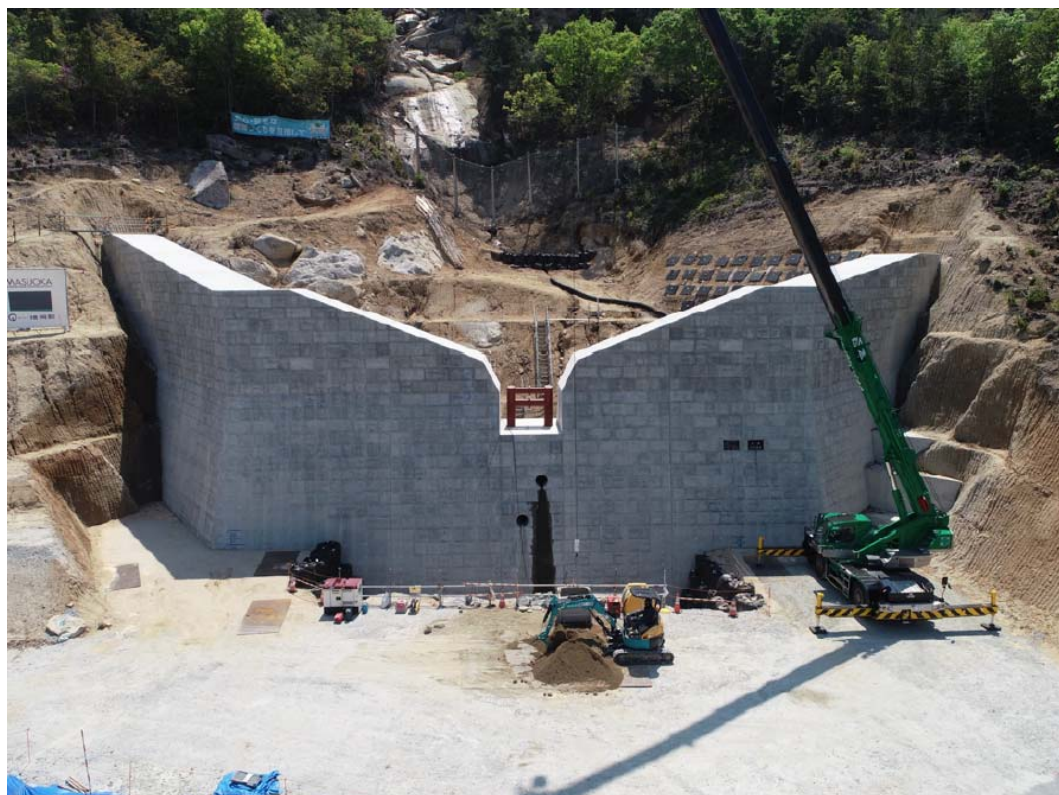
砂防堰堤の埋戻し施工状況
