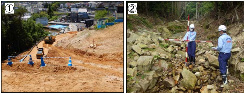
① 進入路施工状況 (1-9-486溪流)
