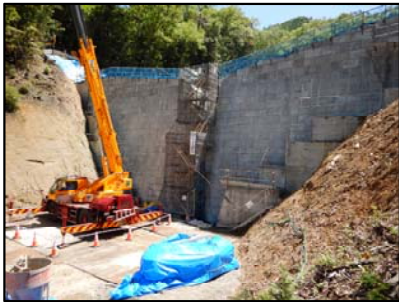
コンクリート打設（嵩上げ）状況 （2-23-13溪流）
