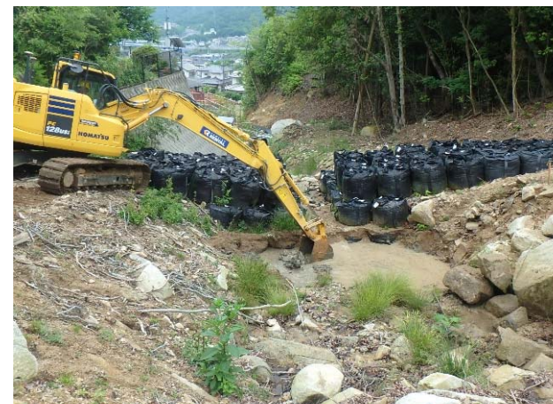
導流工土砂撤去状況(福田地区)
