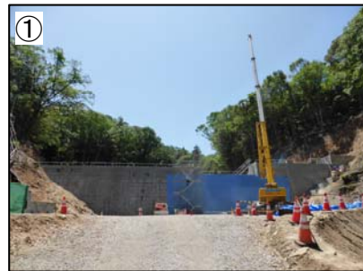
砂防堰堤施工状況（全景） （1-9-33溪流）
