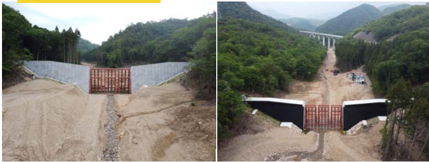
堰堤整備状況（下流側） (2-2-74溪流)
