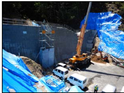
コンクリート打設（嵩上げ）状況 （2-23-20溪流）
