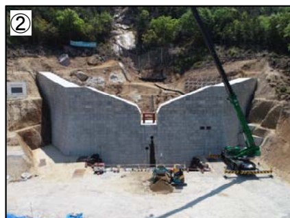
コンクリート打設(嵩上げ)状況 (3-91-92隣e溪流)
