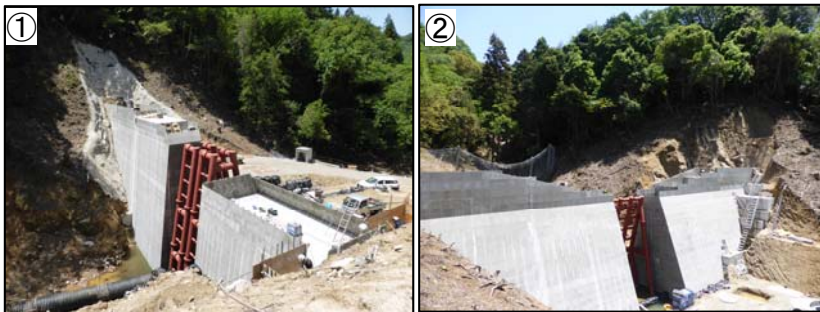
① コンクリート打設（嵩上げ）状況 (1-9-279-1溪流)
