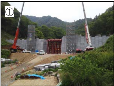
堰堤の施工(高上げ)状況 (2-24-7溪流)
