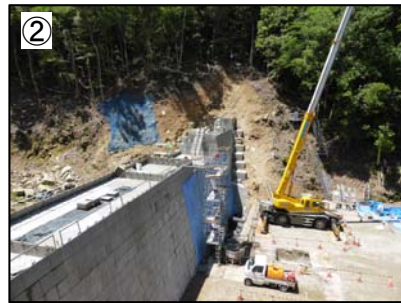
コンクリート打設（嵩上げ）状況 （1-9-33溪流）
