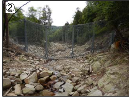
② ワイヤーネットの応急対策施工状況 (1-9-226溪流)
