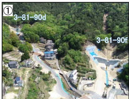
堰堤施工状況(背戸の川全景) (3-91-90d・f溪流)
