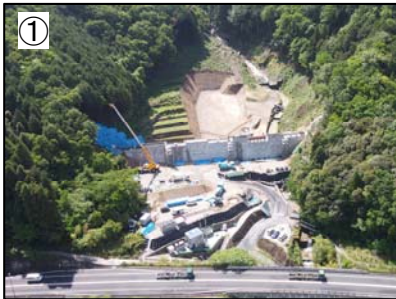
① コンクリート打設状況（全景） （2-2-97溪流）
