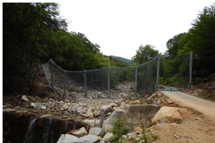
ワイヤーネットによる応急対策の追加(馬木地区)
