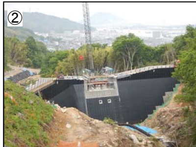
堰堤の施工(高上げ)状況 (2-24-6溪流)
