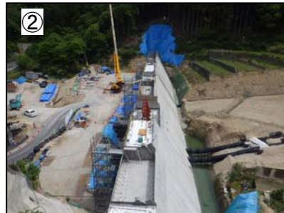
② コンクリート打設（高上げ）状況 （2-2-97溪流）
