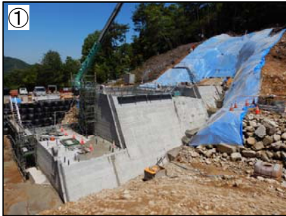
① 本堤施工状況 (1-9-226溪流)
