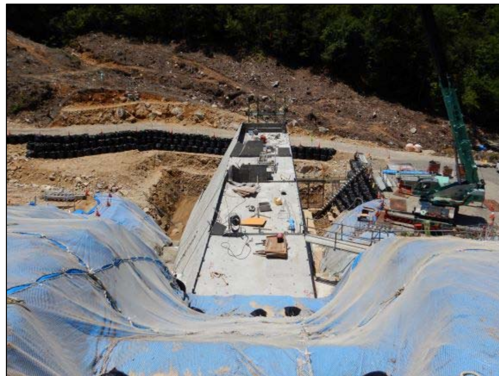
コンクリート打設状況②
