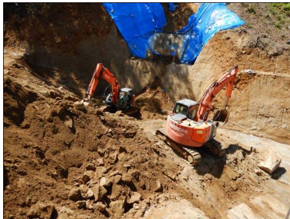
掘削作業状況②
