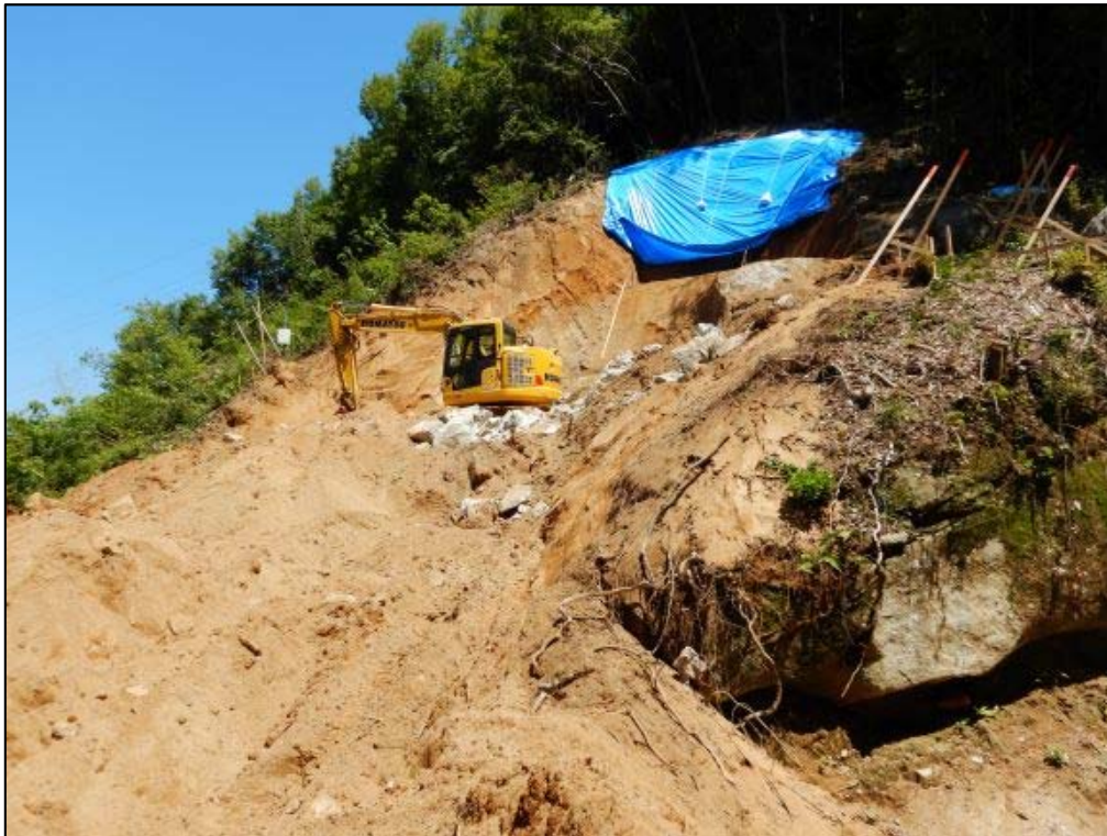
掘削作業状況①
