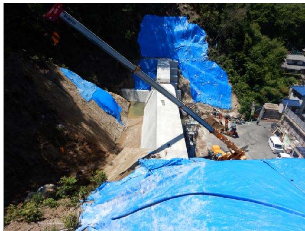
施工状況（右岸側より）
