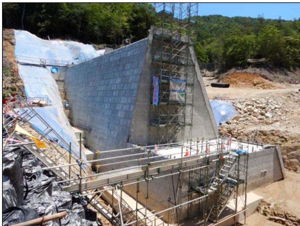
コンクリート打設状況①
