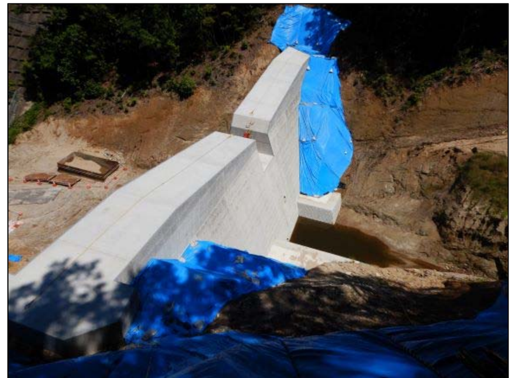
現地状況（左岸上流側より）
