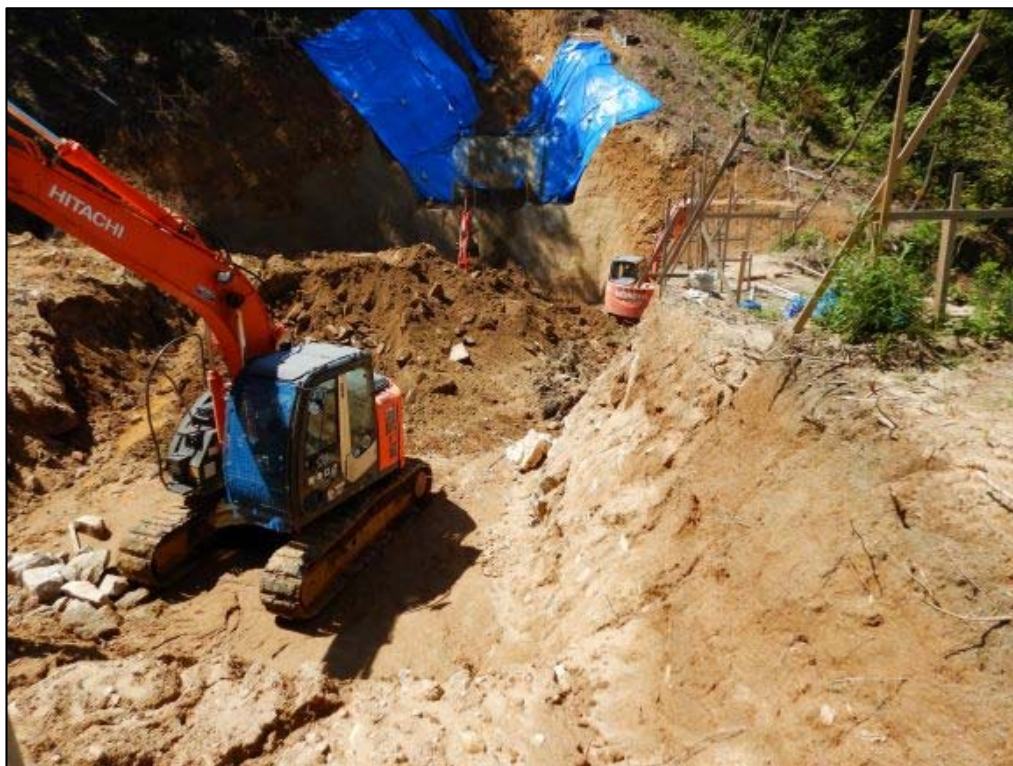
掘削作業状況①
