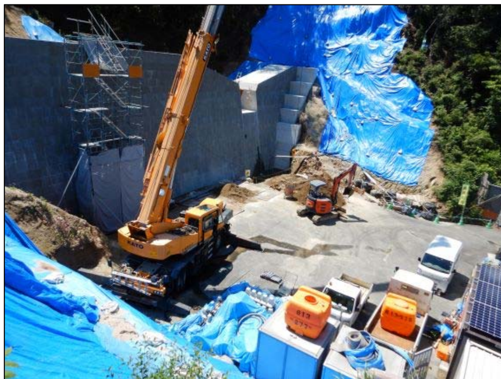
施工状況（下流側より）
