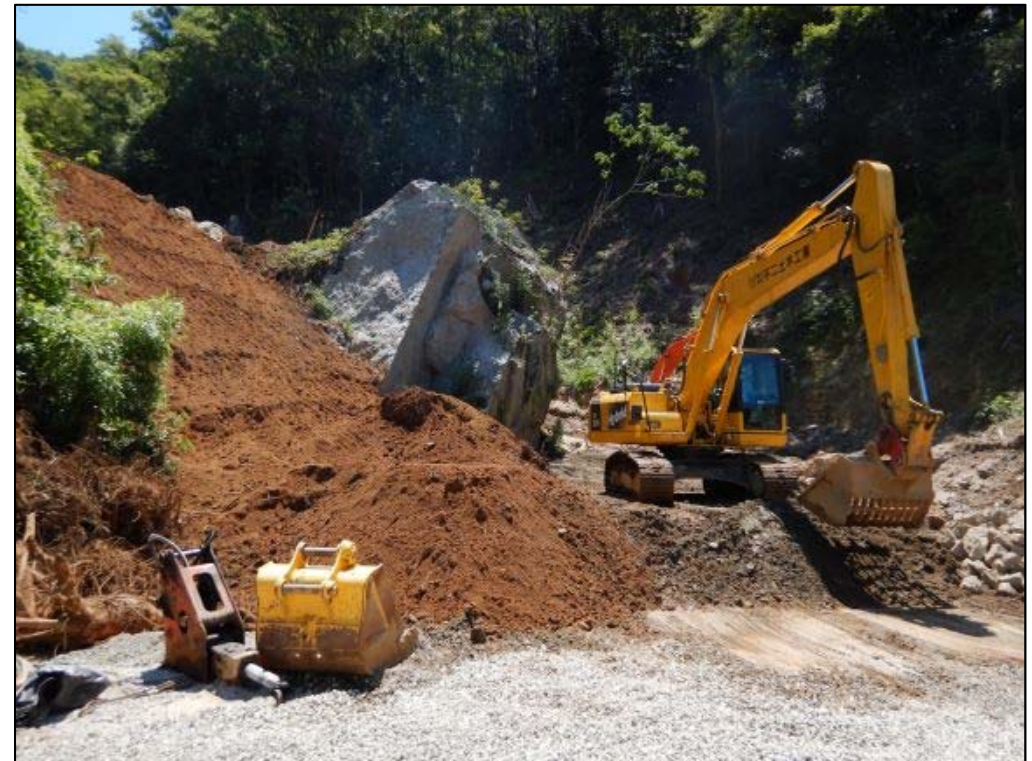
掘削作業状況②
