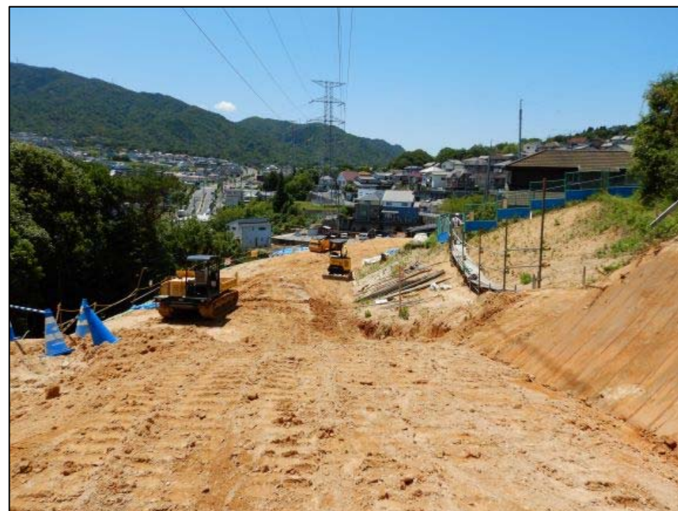
施工状況②
