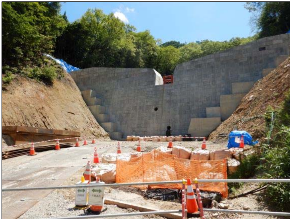
現地状況（下流側より）
