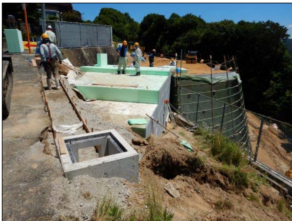
施工状況①
