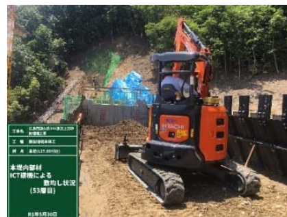
【ICT建機による本堤内部材敷均し】
