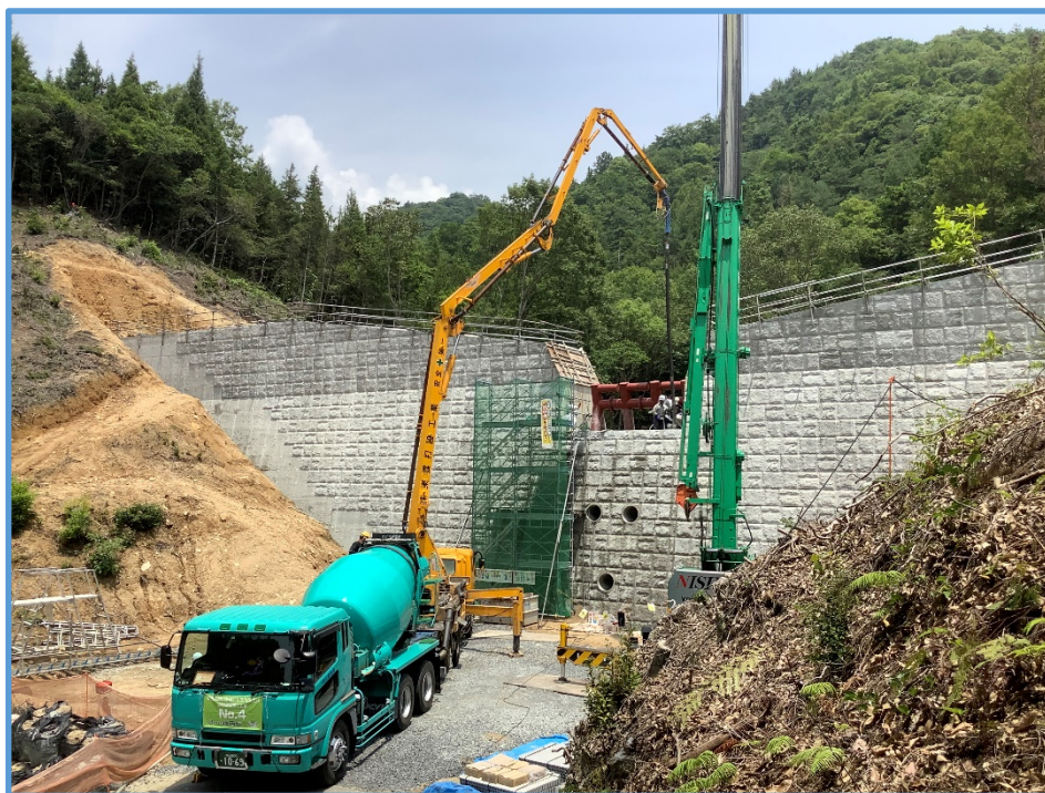
砂防堰堤の本体コンクリート打設状況
