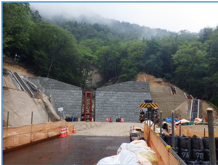
砂防堰堤の階段工実施状況
