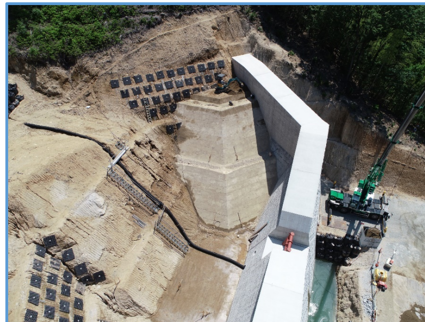
砂防堰堤の埋戻し施工状況
