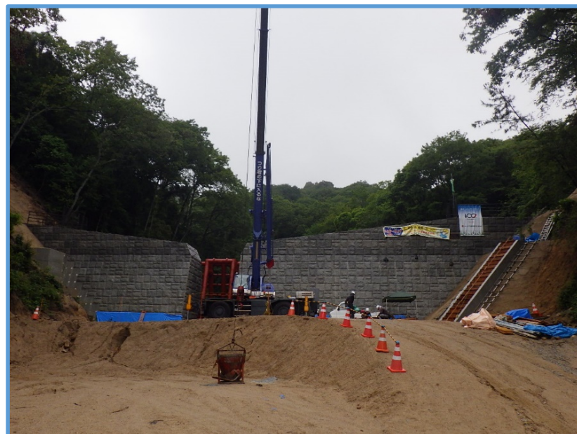
砂防堰堤の階段工実施状況
