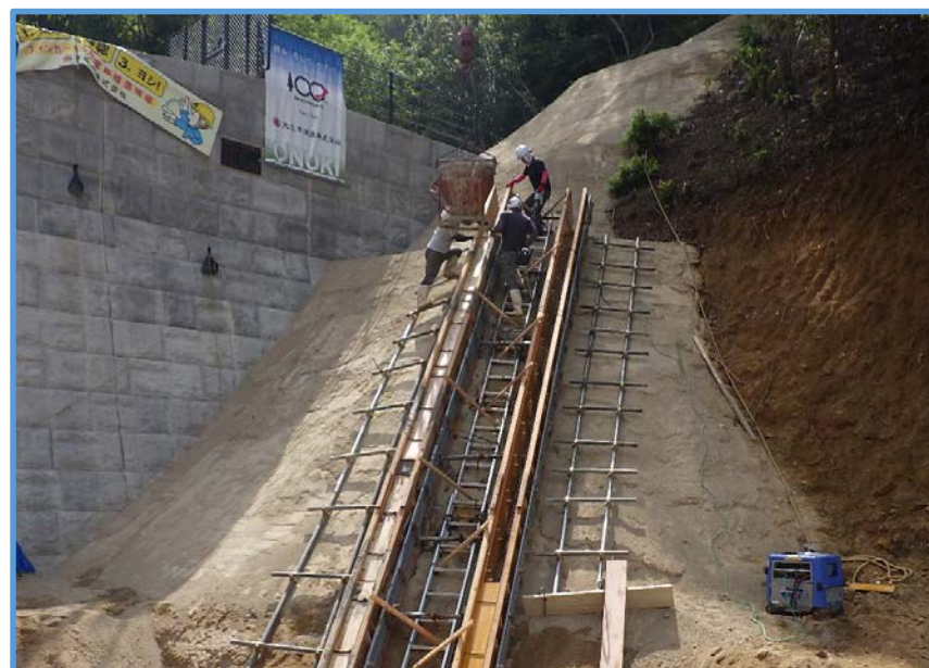
砂防堰堤の階段工実施状況
