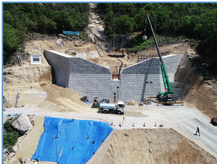
砂防堰堤の埋戻し施工状況
