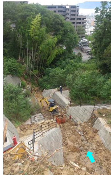
←砂防堰堤下流の 土砂撤去状況
