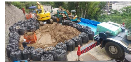
←砂防堰堤下流の 土砂撤去状況
