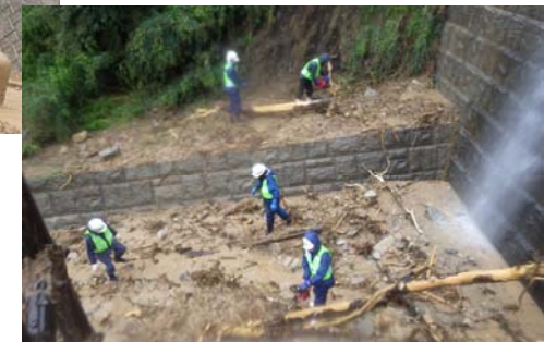
砂防ダム下流の土砂撤去状況
