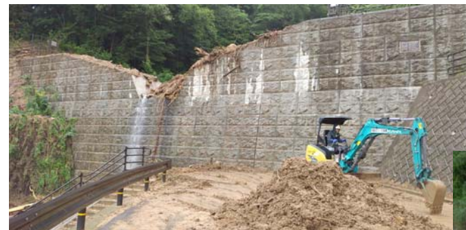
クレーンヤードの土砂撤去状況
