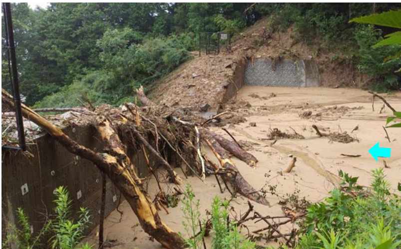
砂防堰堤上流 土砂堆積状況
