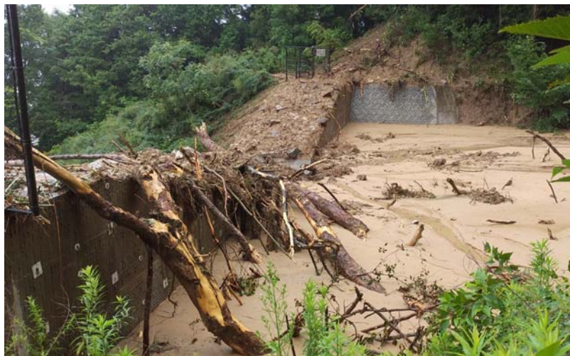
砂防堰堤上流 土砂堆積状況
