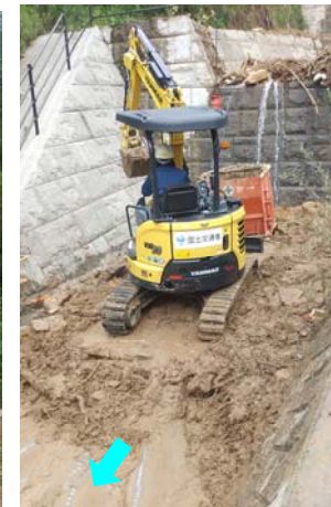
←ミニバックホウによる 砂防堰堤下流の土砂撤去状況
