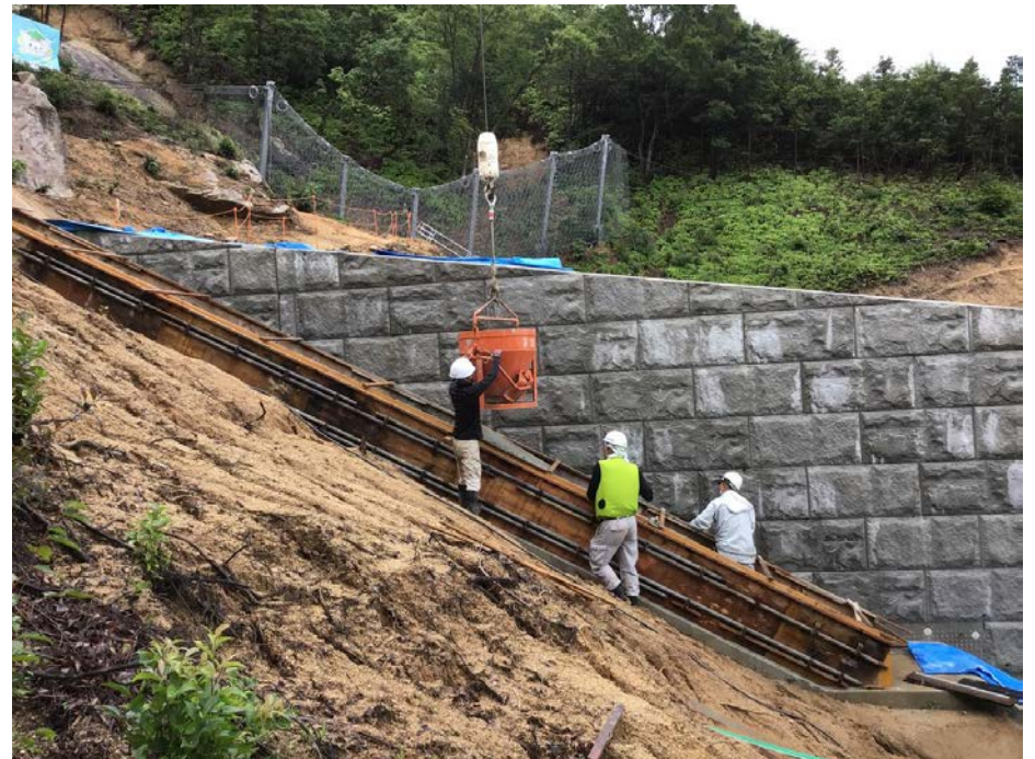
砂防堰堤の階段工施工状況
