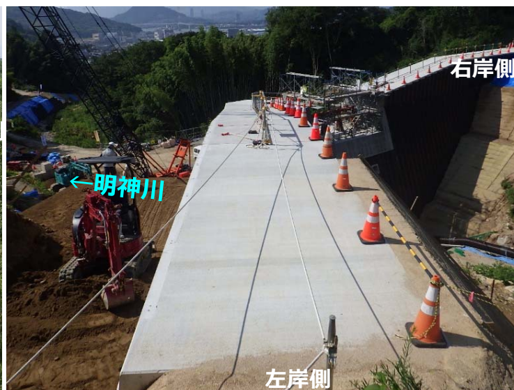
堰堤施工状況(左岸側より)
