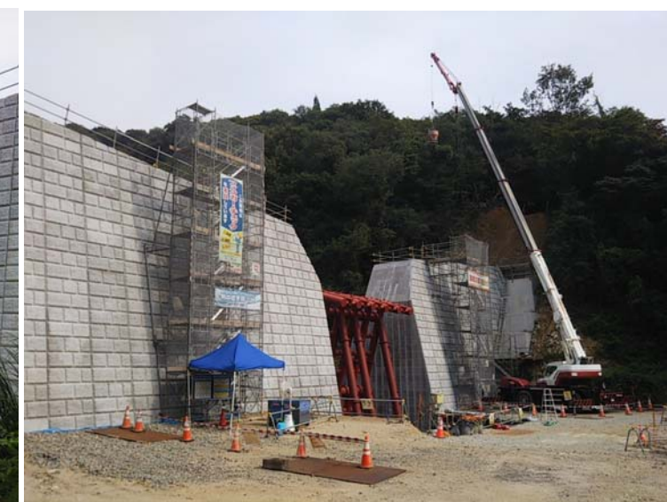
大判川施工状況（右岸側より）
