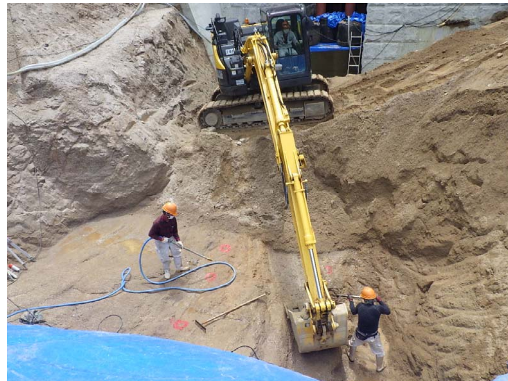
前庭保護工の床堀実施状況
