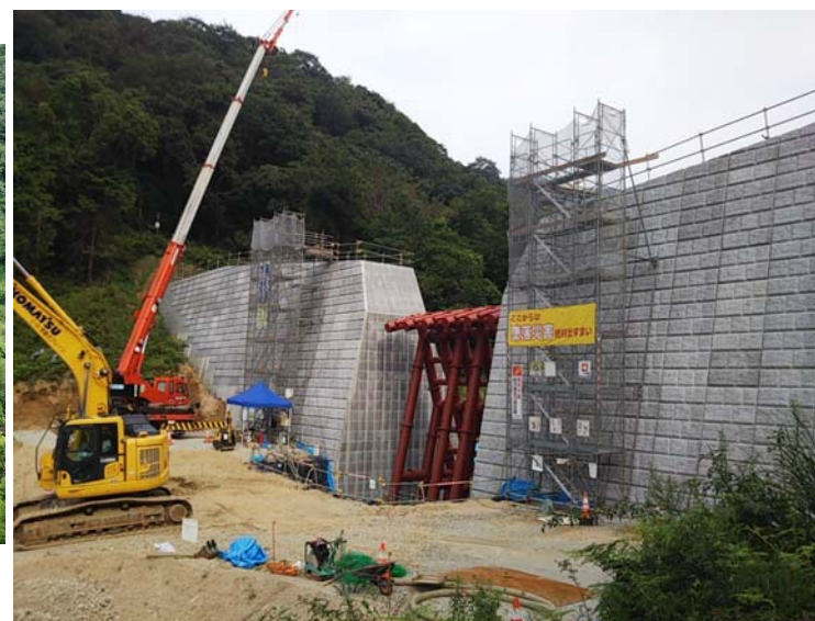
大判川施工状況（左岸側より）
