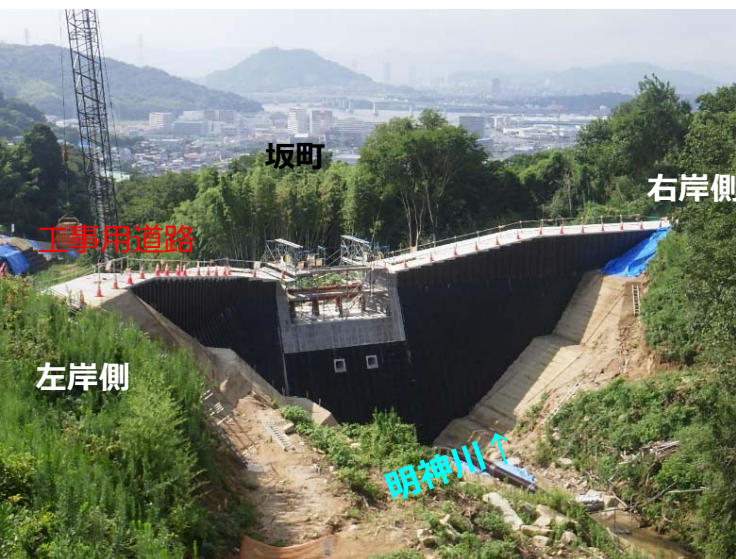
堰堤施工状況(上流より)
