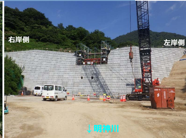
堰堤施工状況(堰堤直下)
