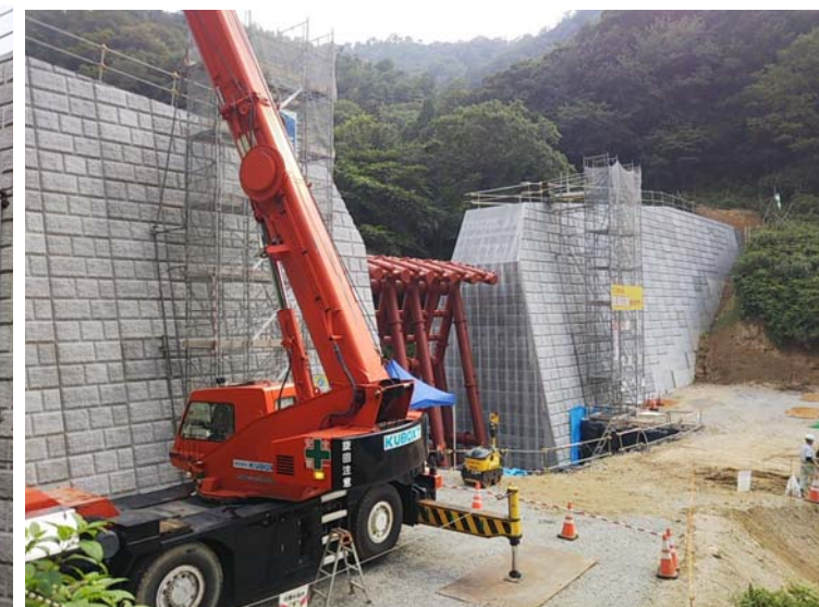
総頭川施工状況（右岸側より）
