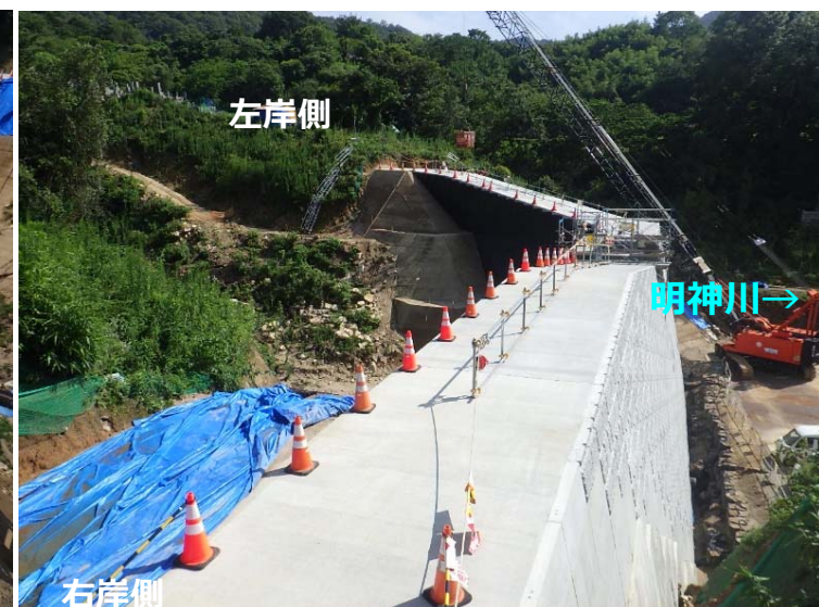
堰堤施工状況(右岸側より)
