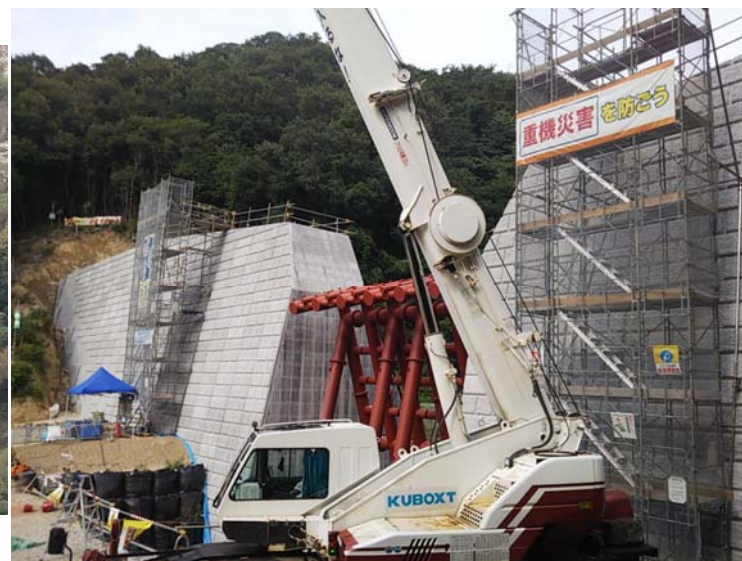
総頭川施工状況（左岸側より）
