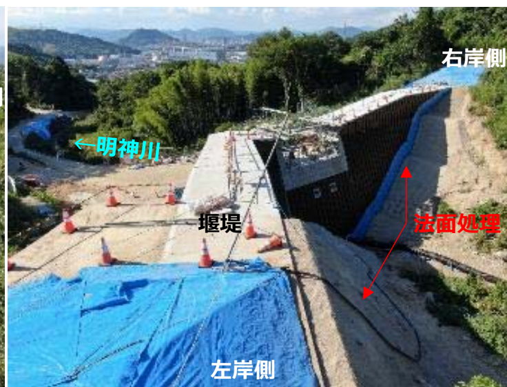
堰堤施工状況(左岸側より)
