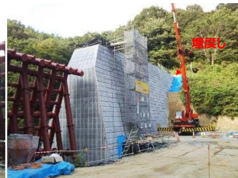
総頭川施工状況（右岸側より）
