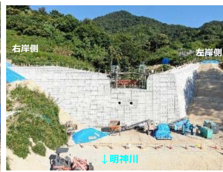
堰堤施工状況(堰堤直下)
