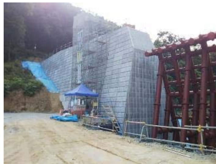
総頭川施工状況（左岸側より）
