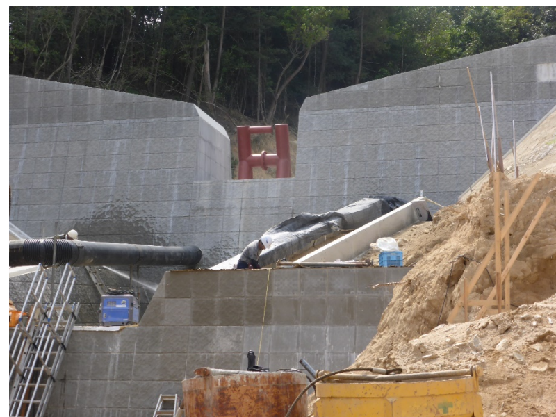
階段工(左岸側)設置予定箇所
