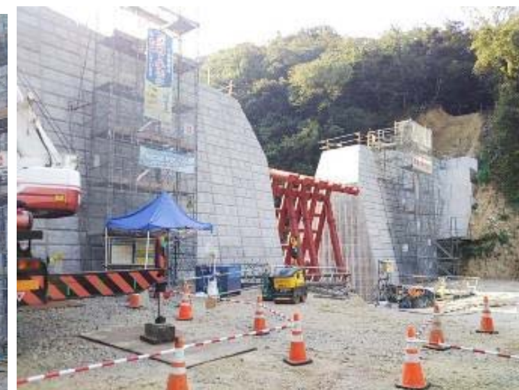
大判川施工状況（右岸側より）
