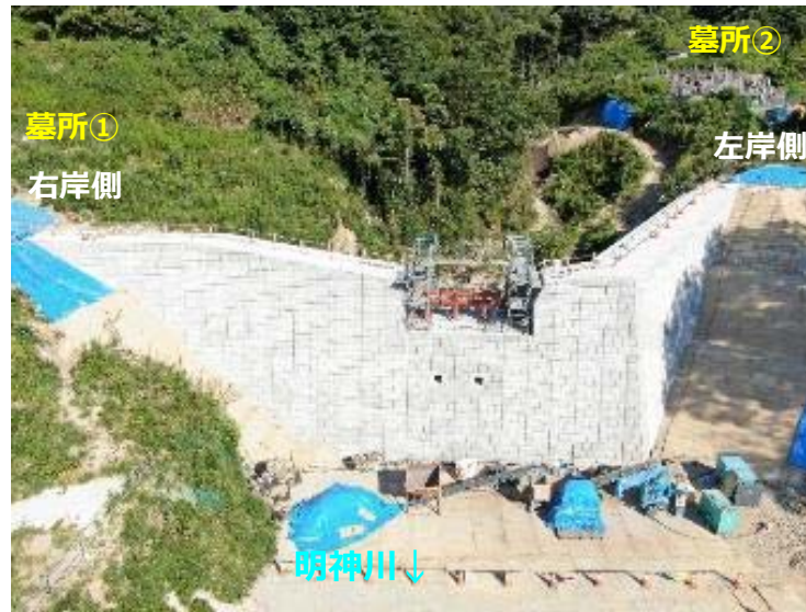
堰堤施工状況(下流斜め)
