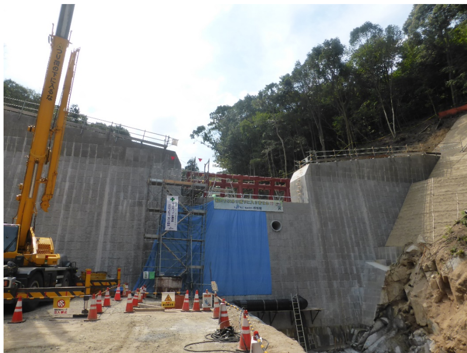
スリット設置状況
