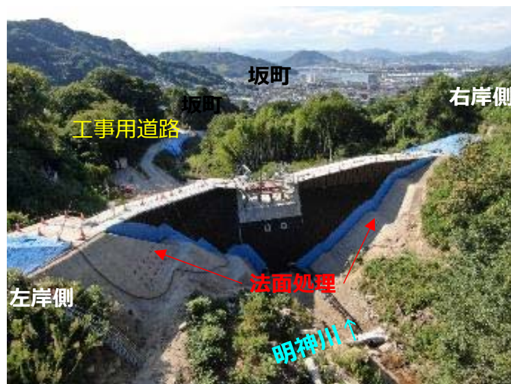
堰堤施工状況(上流より)
