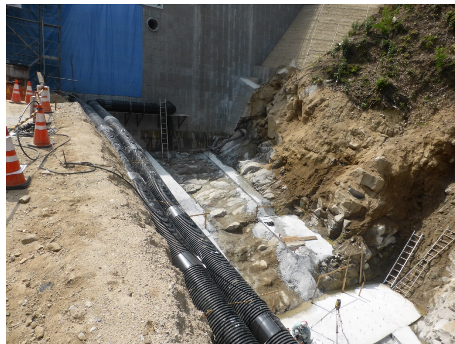
前庭保護工掘削状況
