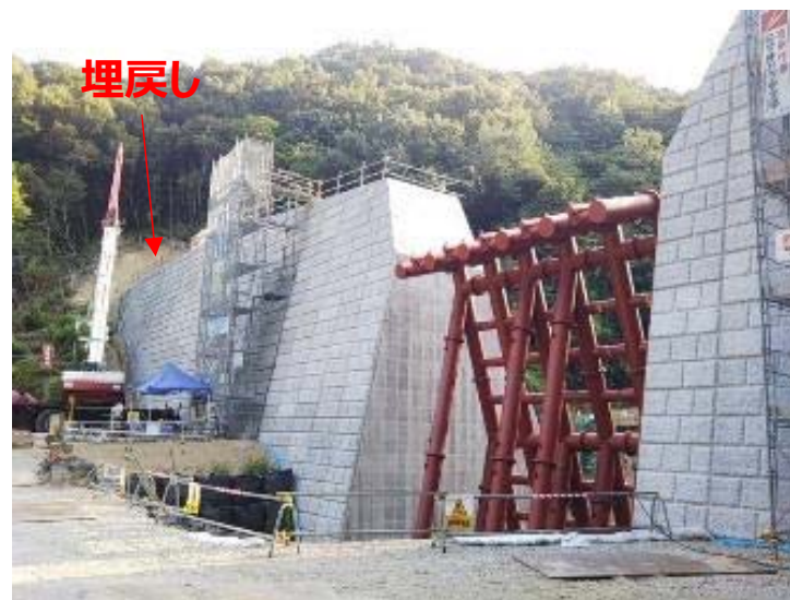
大判川施工状況（左岸側より）
