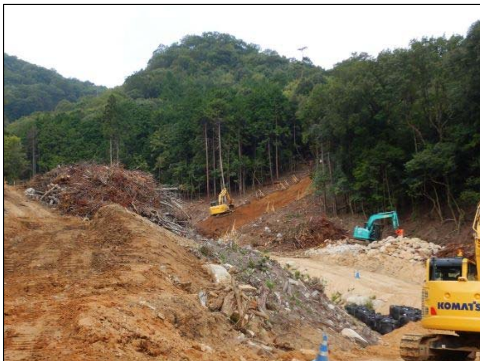
工事用道路施工状況 (堰堤側)
