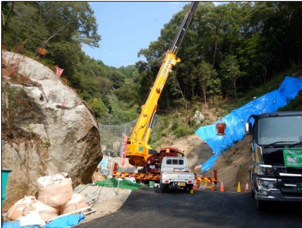
コンクリート打設状況①
