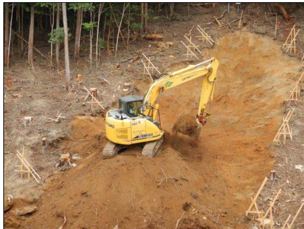
掘削作業状況
