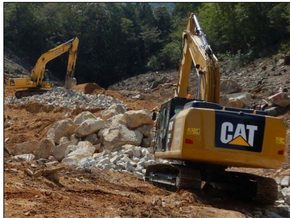
転石破碎状況
