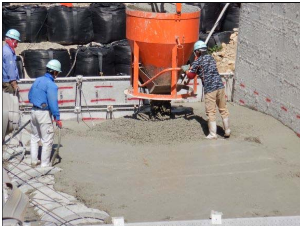
コンクリート打設状況
