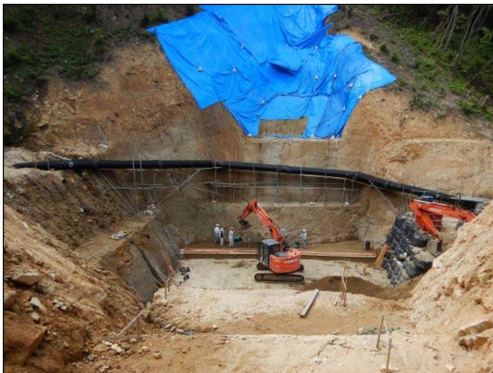
基礎部施工状況
