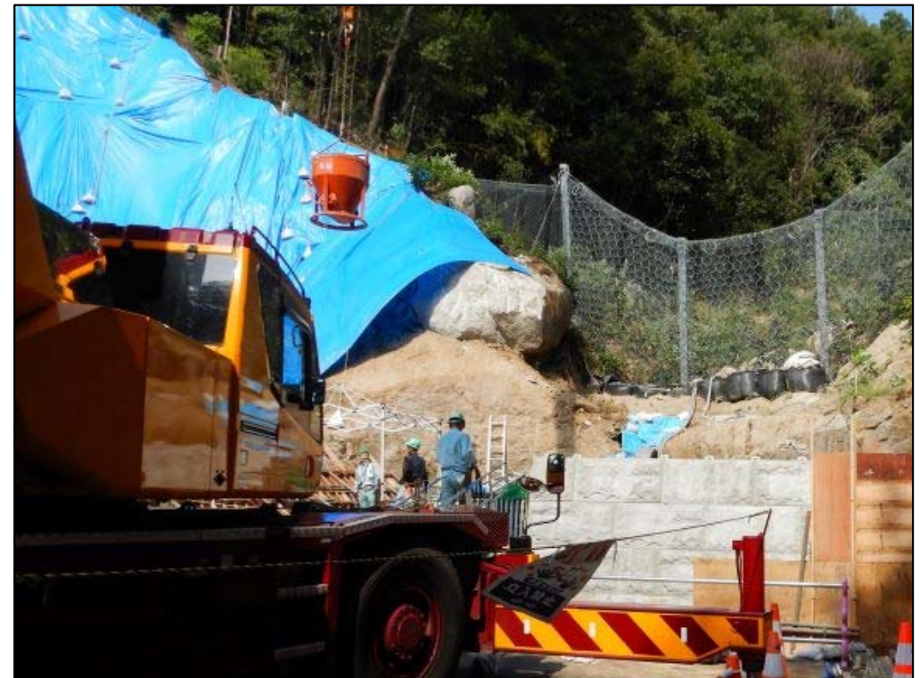
コンクリート打設状況②
