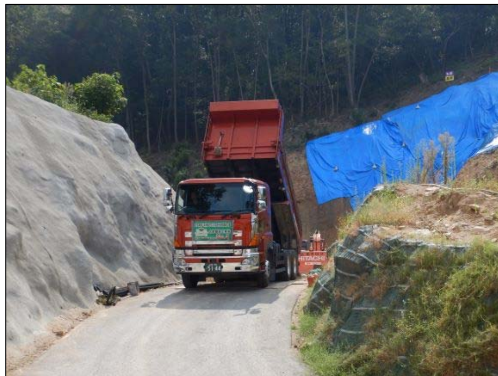
ソイルセメント搬入状況
