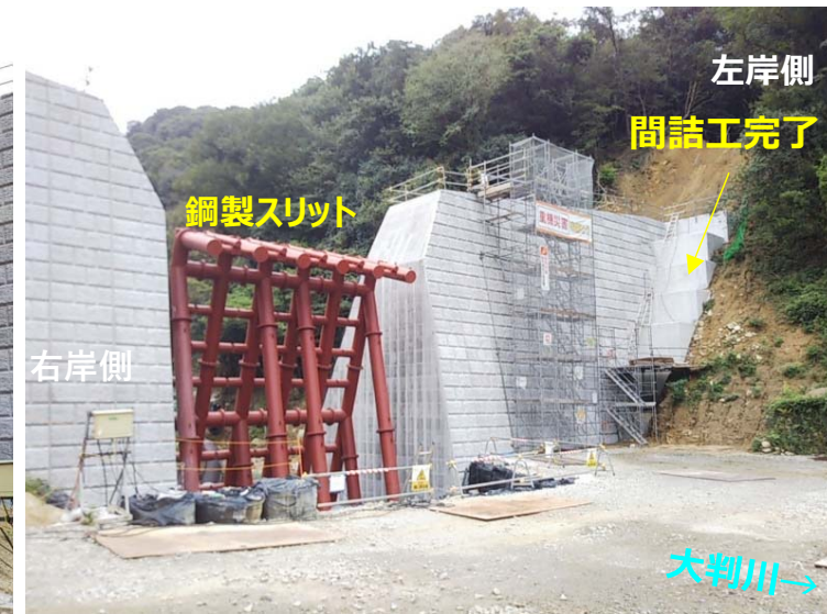
大判川施工状況（右岸側より）
