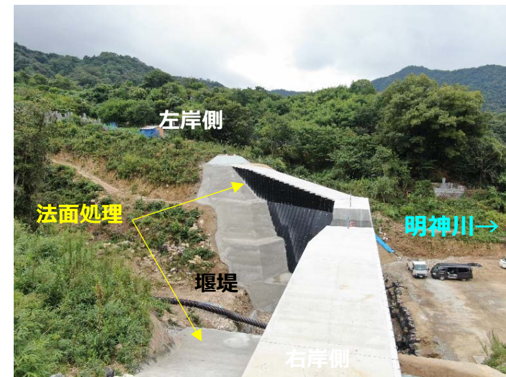
堰堤施工状況(右岸側より)
