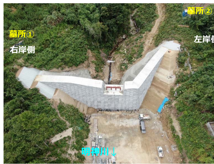
堰堤施工状況(下流斜め)
