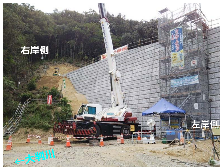
大判川施工状況（左岸側より）
