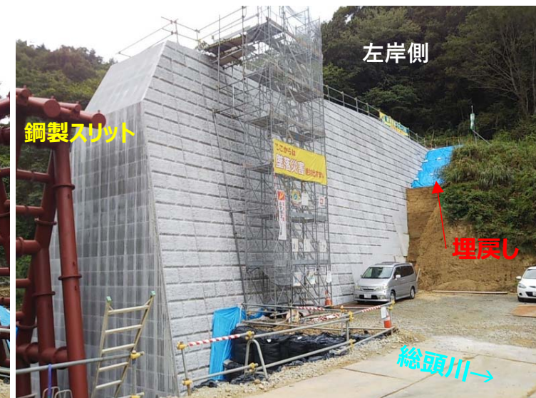
総頭川施工状況（右岸側より）
