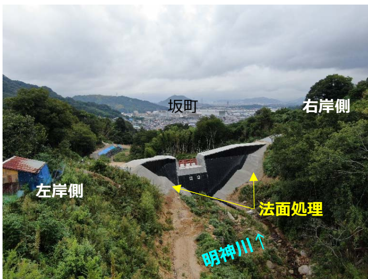
堰堤施工状況(上流より)
