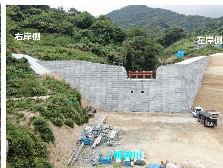
堰堤施工状況(堰堤直下)
