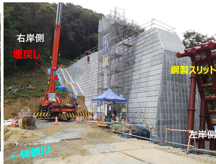
総頭川施工状況（左岸側より）
