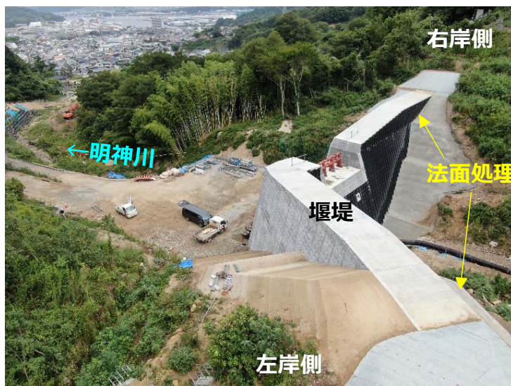
堰堤施工状況(左岸側より)
